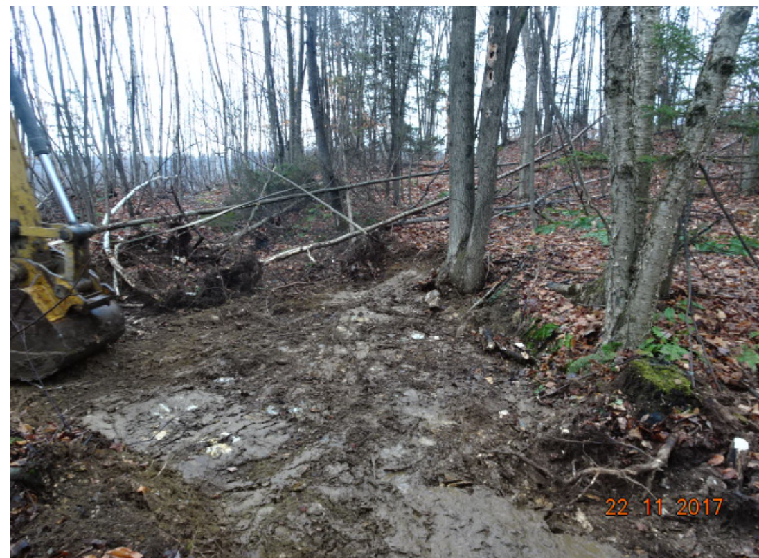
AH-2017-11-22-006 - Fosse 3 après la sécurisation par remblayage en novembre 2017 par le MERN (vue vers le Sud-Ouest)
