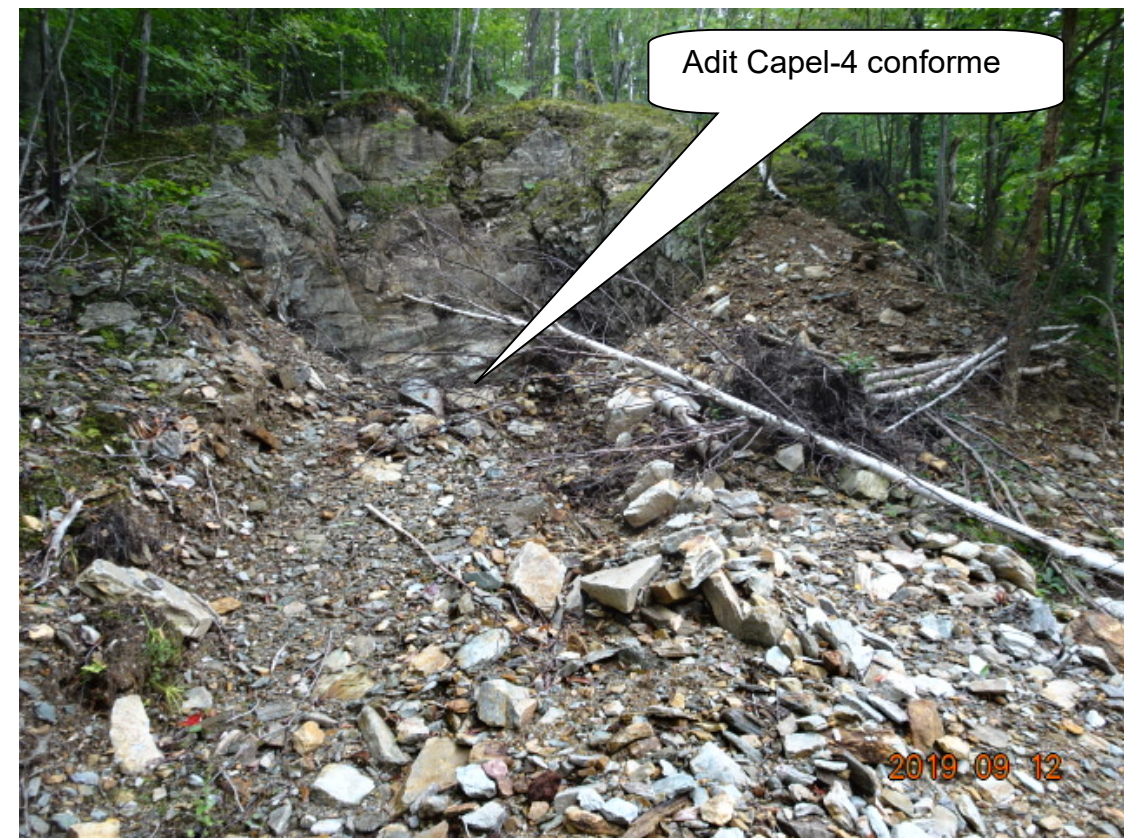
Cap-2019-09-12-006 – Adit Capel-4 conforme et sécurisé par remblayage (vue vers le Sud-Est) Coordonnées UTM Nad 83 : 272255 Est, 5023104 Nord
