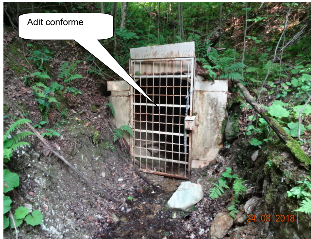
Cap-2018-08-24-001 – Adit Victoria sécurisé avec une grille et barrée avec un cadenas (vue vers l'Est) Coordonnées UTM Nad 83 : 272740 Est, 5023379 Nord
