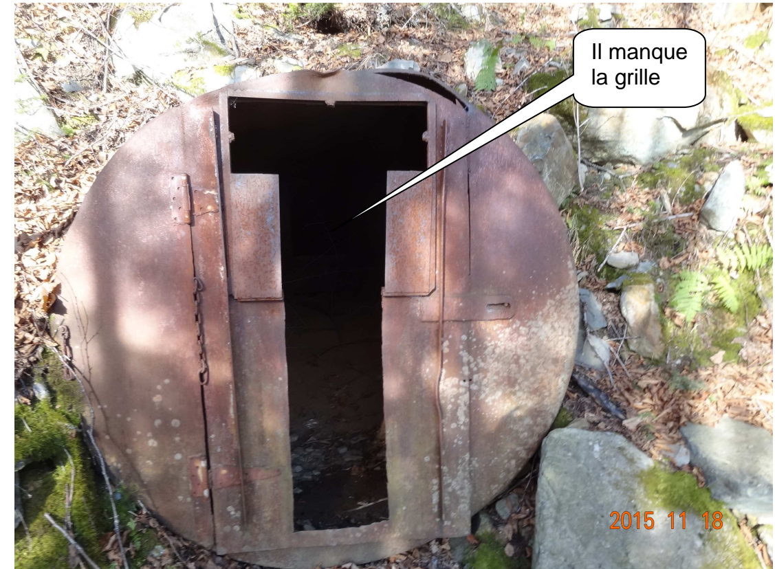
Cop-2015-11-18-002 - Vue de l'Adit sécurisé avec un tuyau qui n'a pas de grille, donc, non conforme (vue vers le Nord)
