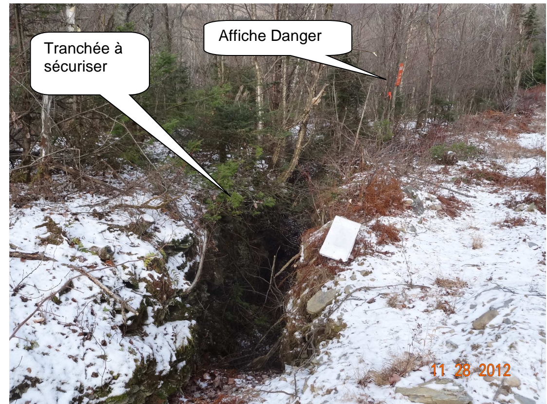
HH-2012-11-28-008 – Tranchée 1 à sécuriser par remblayage. À droite, il y a une affiche « DANGER » (vue vers le nord-est)
