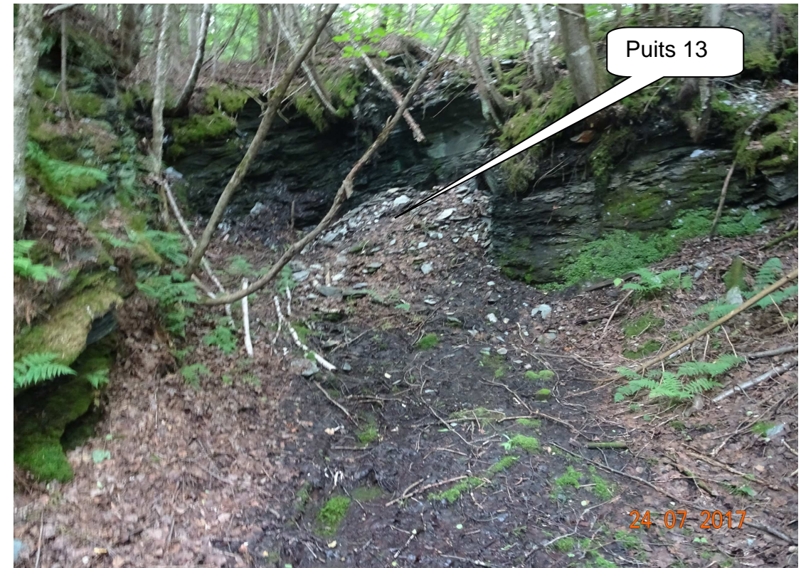
HH-2017-07-24-003 – Puits 13 sécurisé par remblayage et est situé dans la fosse 3 (vue vers l'est)
