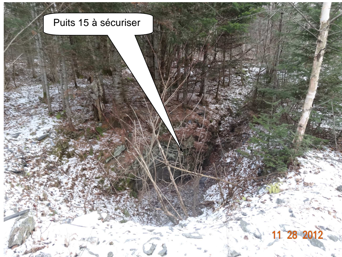
HH-2012-11-28-021 – Puits 15, affaissement à sécuriser par remblayage (vue vers le nord-est)
