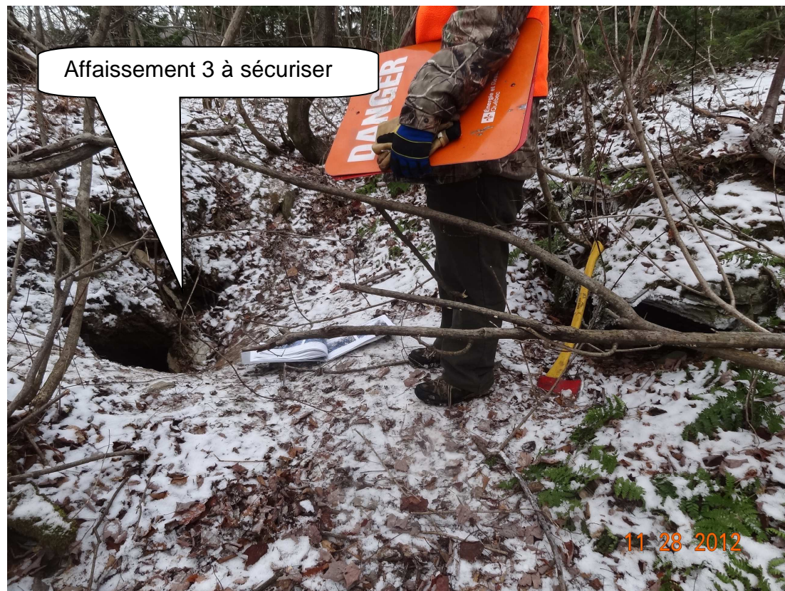
HH-2012-11-28-013 – Affaissement 3 à sécuriser par remblayage (vue vers le nord)
