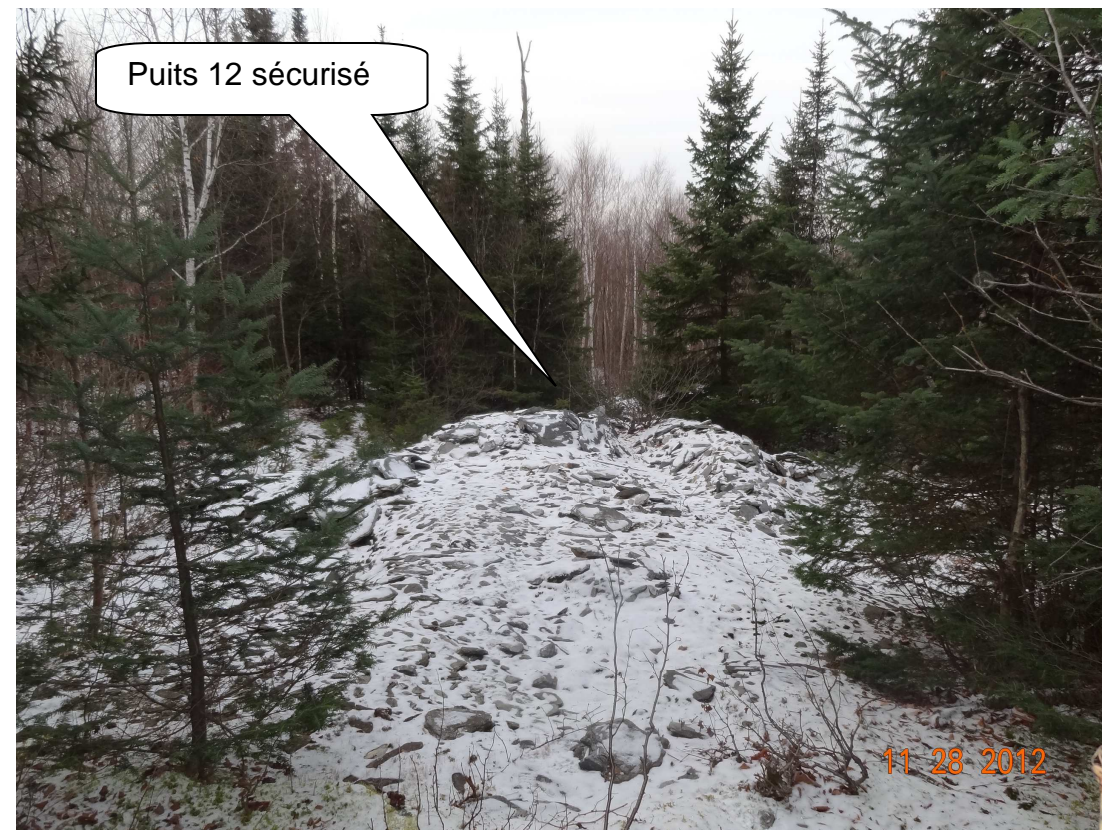
HH-2012-11-28-020 – Puits 12 sécurisé par remblayage et conforme (vue vers le nord)
