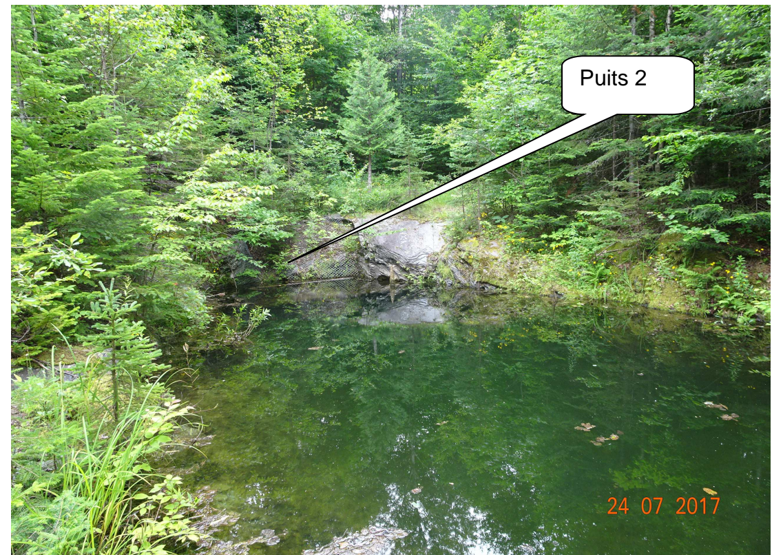
HH-2017-07-24-001 – Puits 2 sécurisé avec une clôture et à sécuriser par remblayage (vue vers le sud)
