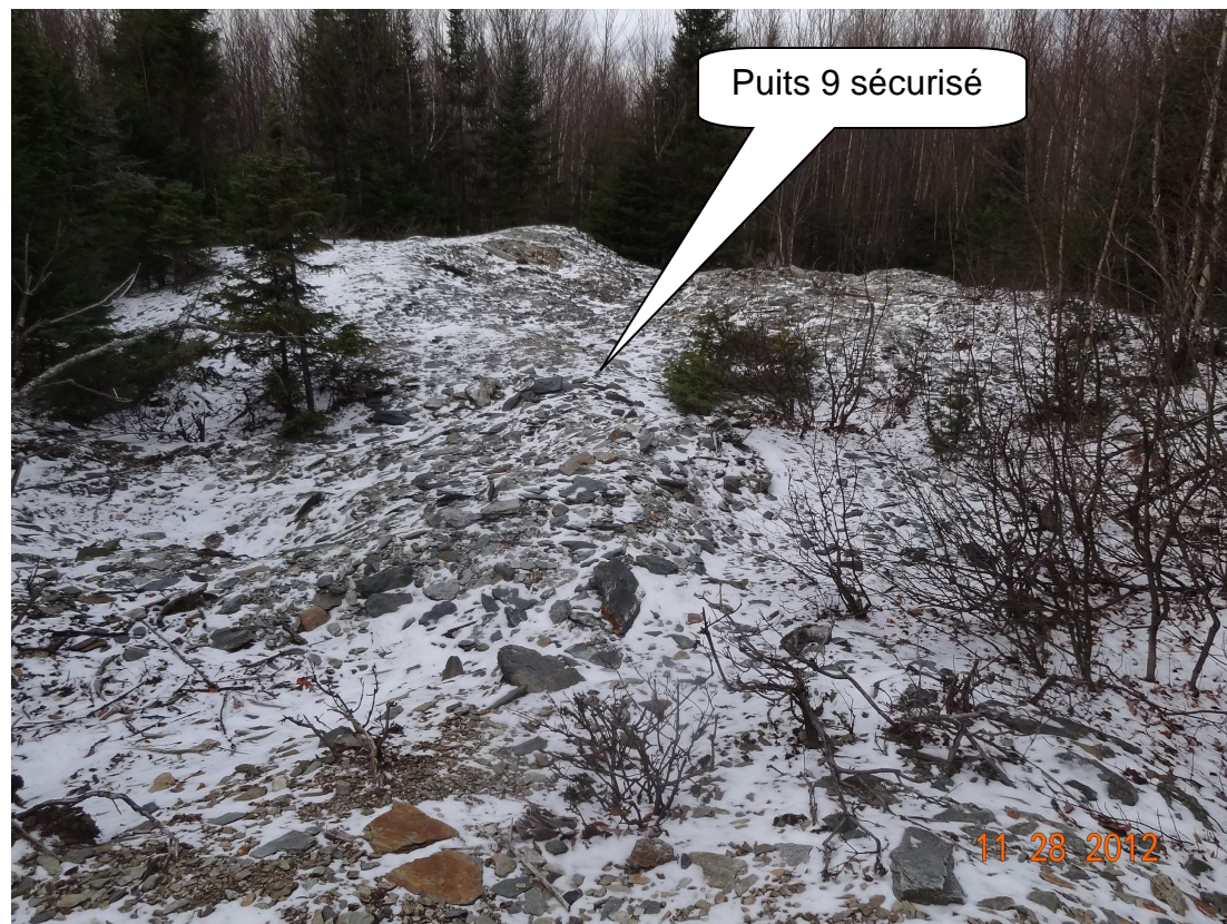
HH-2012-11-28-017 – Puits 9 sécurisé par remblayage et conforme (vue vers le nord)
