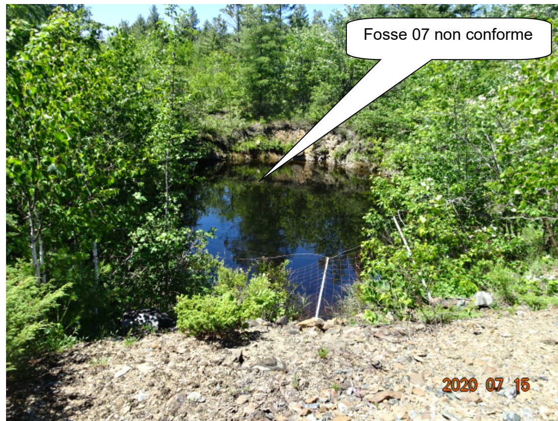
RB-2020-07-15-002 – De la halde 7, fosse 07 non conforme et à sécuriser par remblayage (vue vers l'Ouest) Coordonnées UTM Nad 83 : 318407 Est, 5097851 Nord
