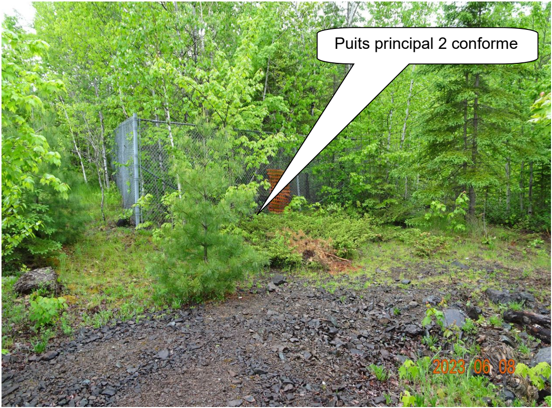
RB-2023-06-08-002 – Puits principal 2 conforme sécurisé avec une dalle de et une clôture (vue vers le Nord-Ouest) Coordonnées UTM Nad 83 : 318601 Est, 5097906 Nord
