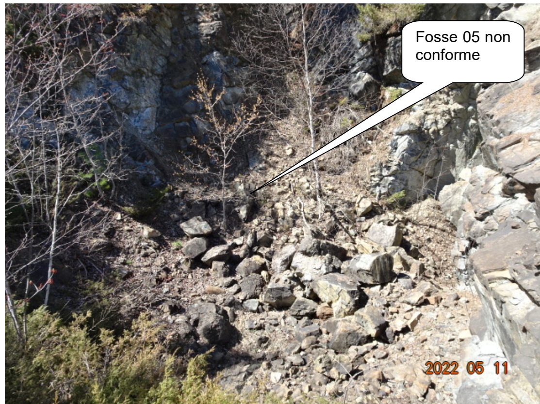
RB-2022-05-11-008 – Fosse 05 non conforme et à sécuriser par remblayage (vue vers le Nord-Ouest) Coordonnées UTM Nad 83 : 318477 Est, 5097896 Nord
