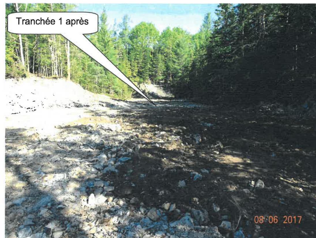
StO-2017-06-08-025 – Tranchée 1 après la sécurisation par remblayage de 2017 par le MERN (vue vers le Nord-Ouest)
