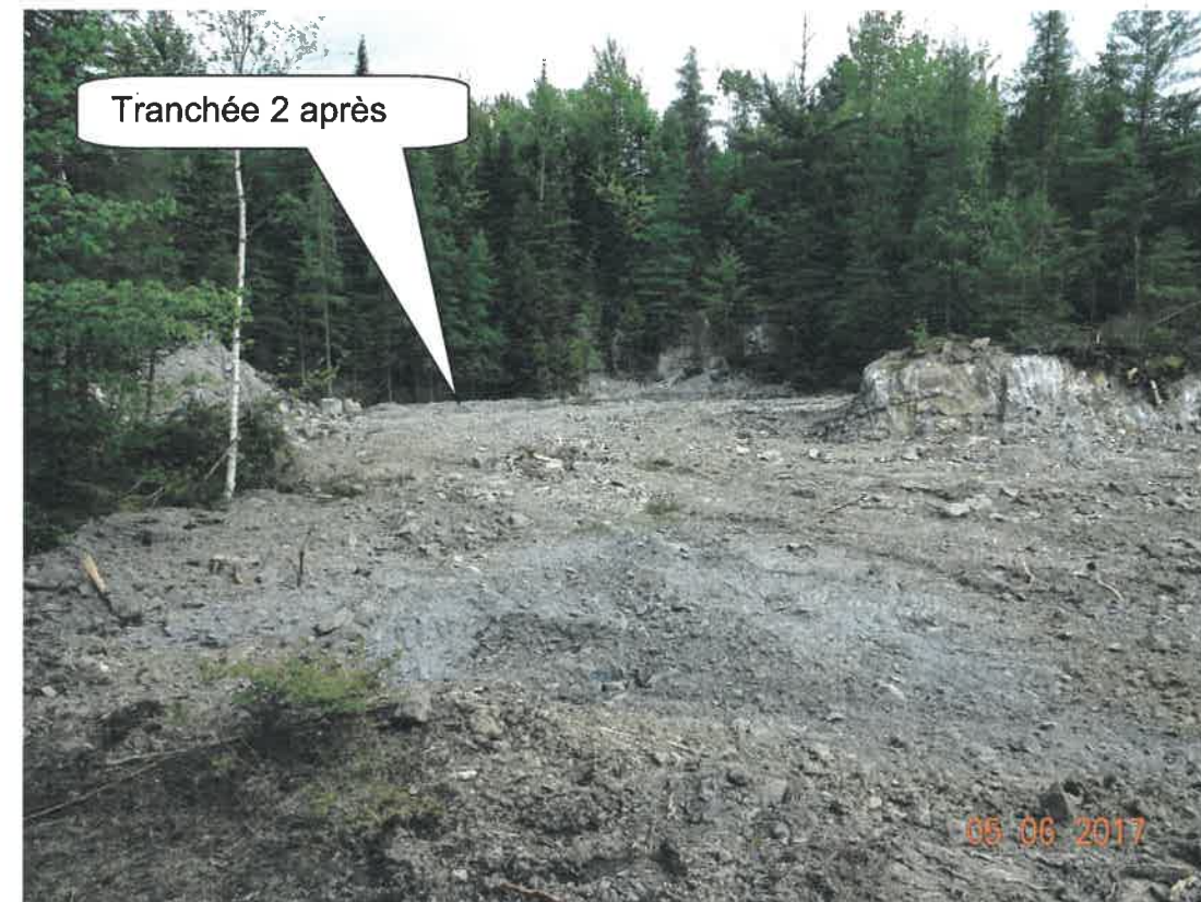
StO-2017-06-05-021 – Tranchée 2 après la sécurisation par remblayage de Mai 2017 par le MERN (vue vers le Nord)
