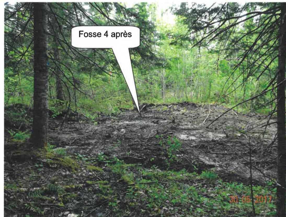
StO-2017-05-30-006 – Fosse 4 après la sécurisation par remblayage de Mai 2017 par le MERN (vue vers le Nord)
