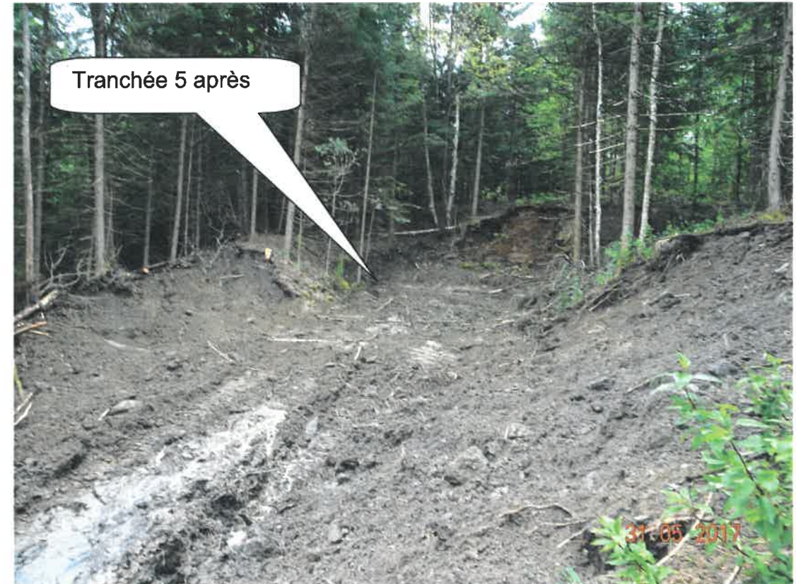
StO-2017-05-31-012 – Tranchée 5 après la sécurisation par remblayage de Mai 2017 par le MERN (vue vers l'Est)
