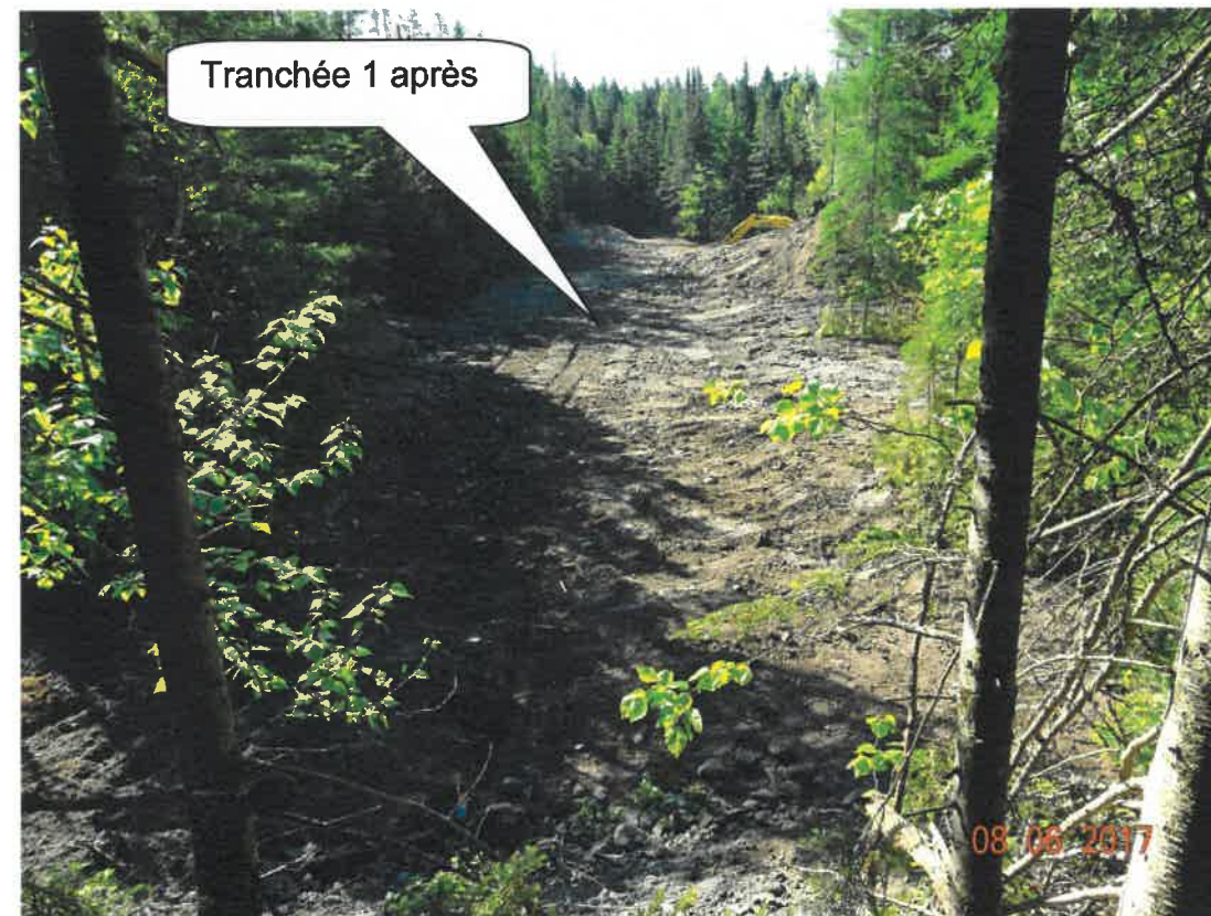
StO-2017-06-08-026 – Tranchée 1 après la sécurisation par remblayage de 2017 par le MERN (vue vers le Sud-Est)
