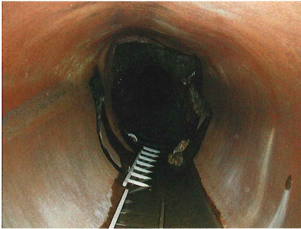
Vue intérieure de l'adit, un cylindre métallique a été inséré dans l'ouverture minière
