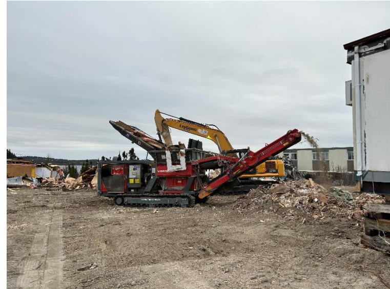
Photo #2 : Déchiquetage des débris de démolition.
