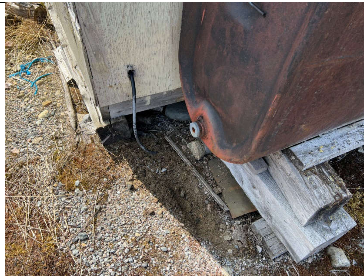
Le réservoir d'huile à chauffage n'a plus de valve et la présence d'odeur d'hydrocarbure a été constaté dans les sols sous l'emplacement de la valve manquante.
