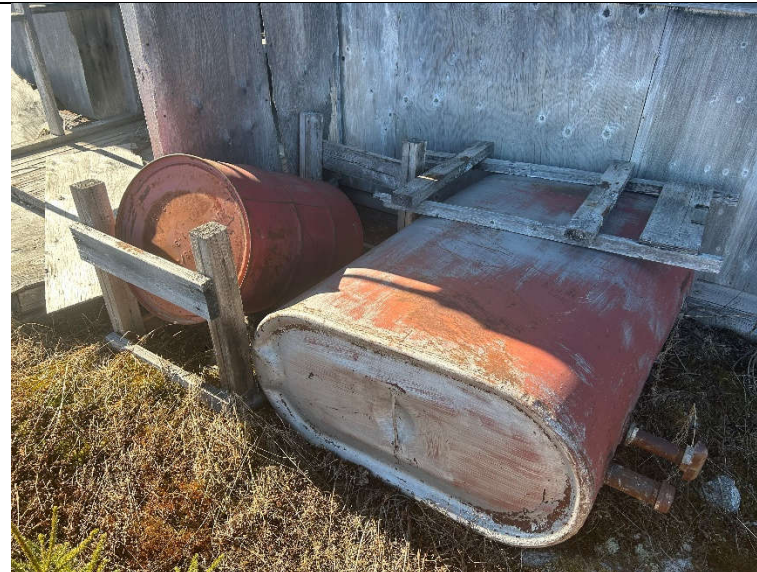
Réservoir d'huile à chauffage et baril. la présence d'odeur d'hydrocarbure a été constaté dans les sols sous le support à réservoir.
