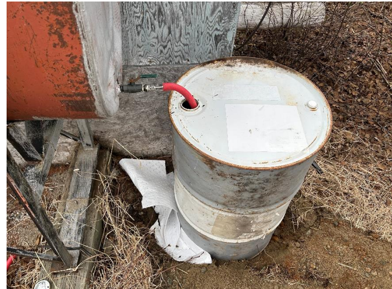
Photo #8 : Vidage du réservoir d'huile à chauffage du camp km 305
