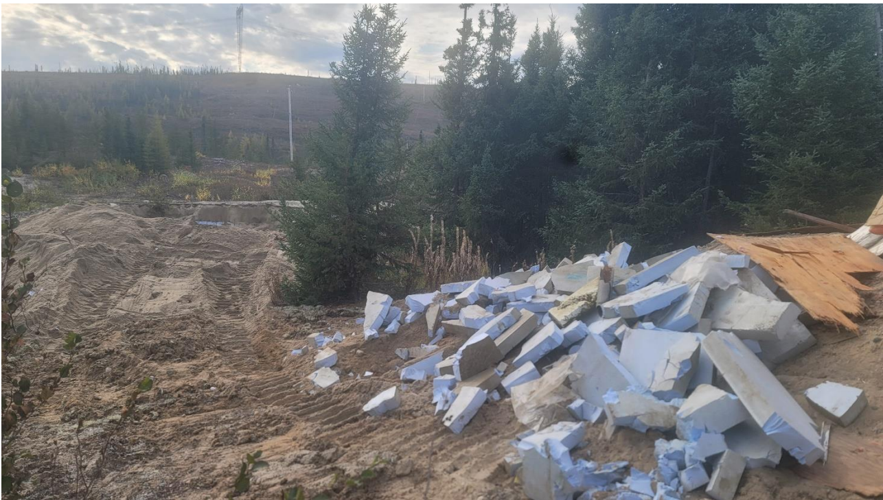
Photo #4 : Démantèlement du champ d'épuration.
