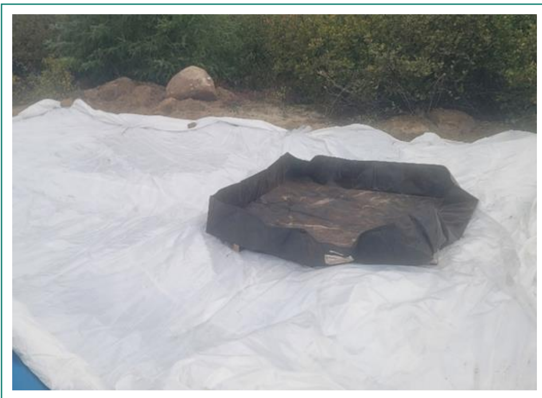
Photo 99 : Aire de lavage avec Insta-Berme 6 pi x 6 pi.
