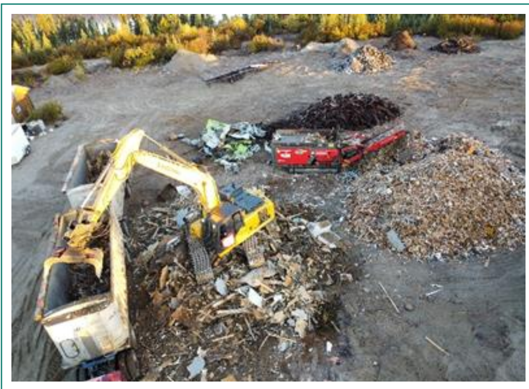
Photo 117 : Piles ségréguées et déchargement des matériaux de démolition des camps satellites (3 octobre 2023).
