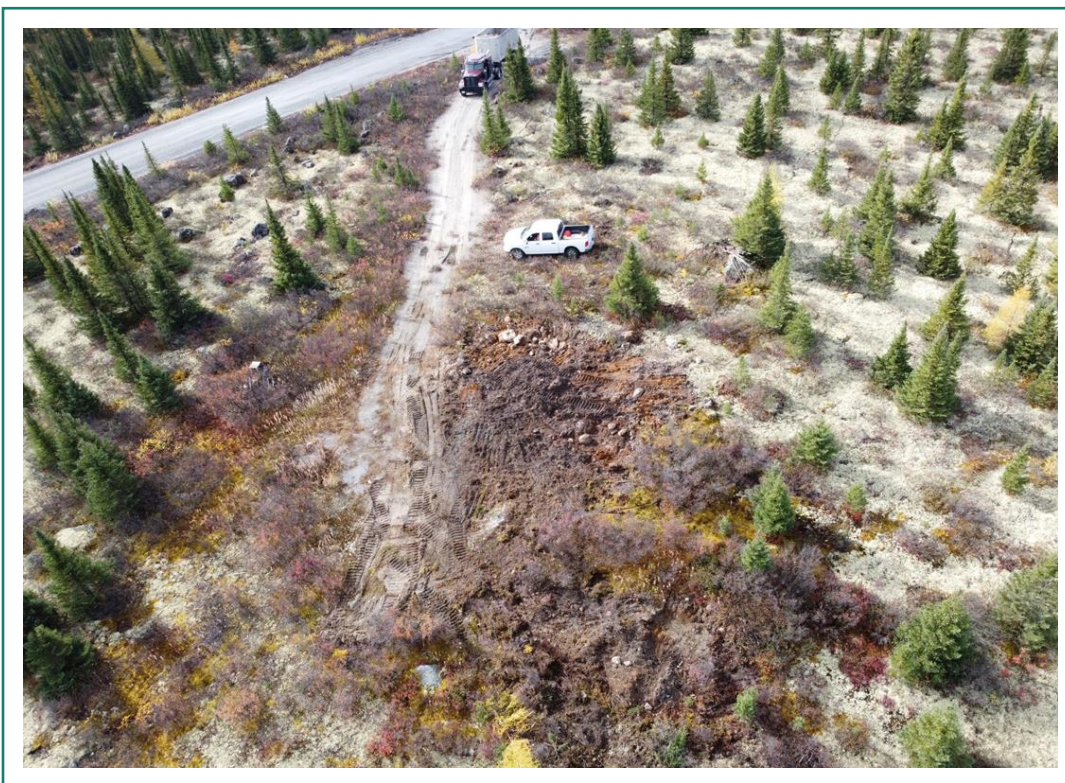
Photo 10 : Km 440 – Site 212691-B (après) Vue du nivellement final du site.
