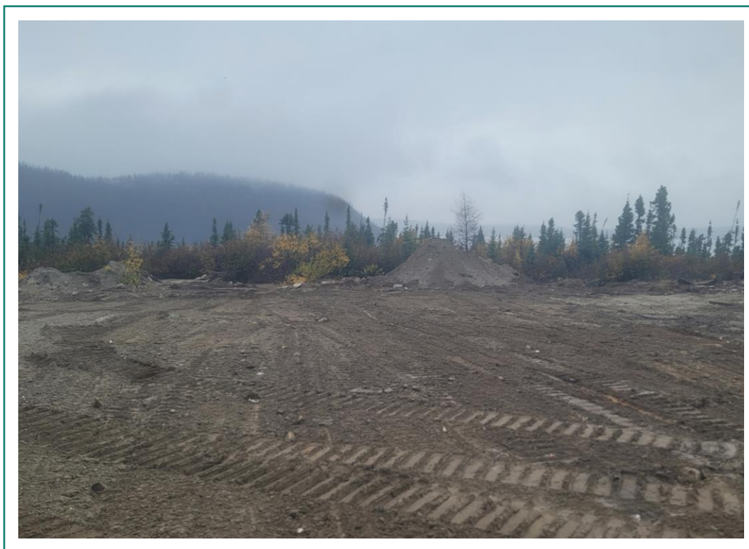
Photo 31 : Vue du terrain nivelé. Vue vers le secteur des anciens bâtiments 6a-RC à 6c-RC (6 octobre 2023). Les sols des piles ont été étendus lors du nivellement final.
