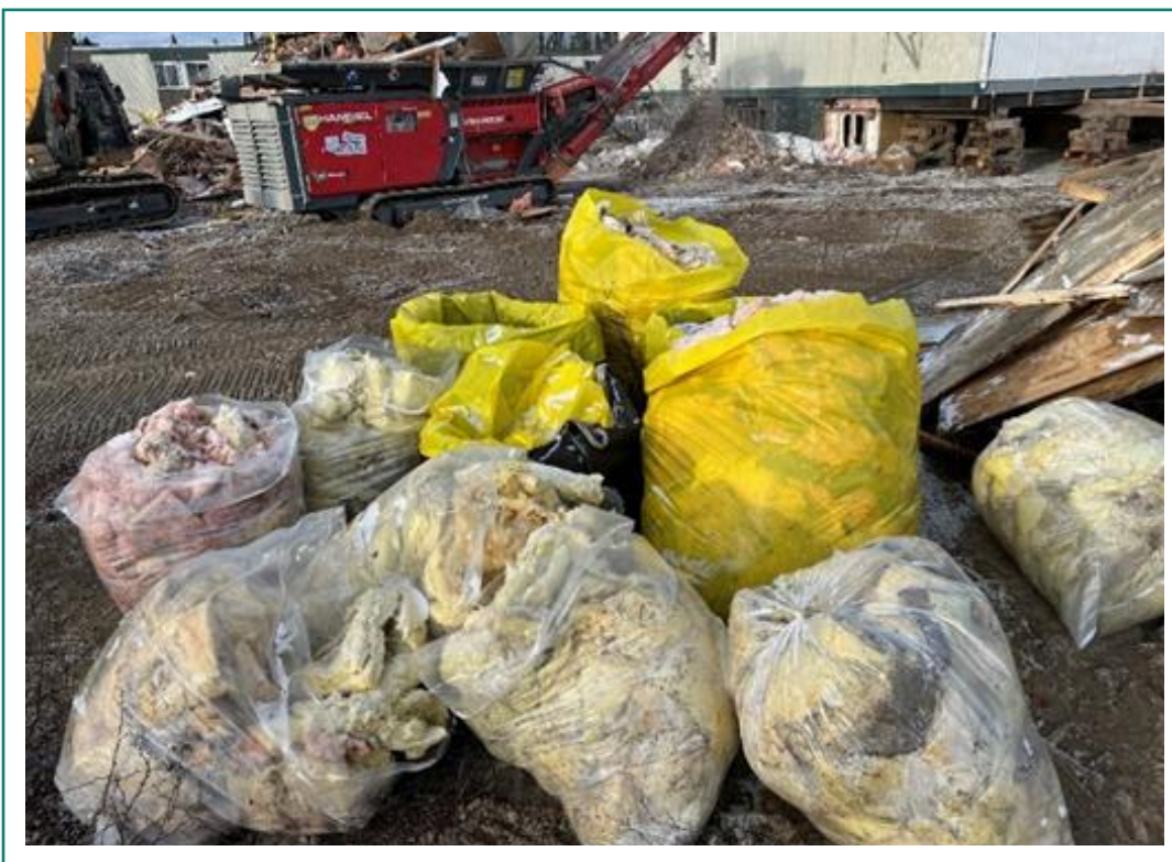
Photo 118 : Ensachage de la laine minérale retirée des bâtiments (16 mai 2023).
