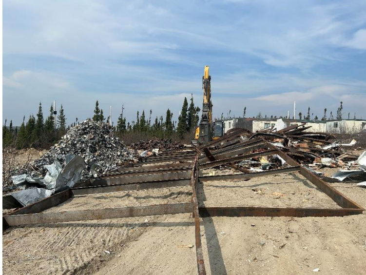
Photo #1 : L'excavatrice qui coupe des bases en fer des roulottes
