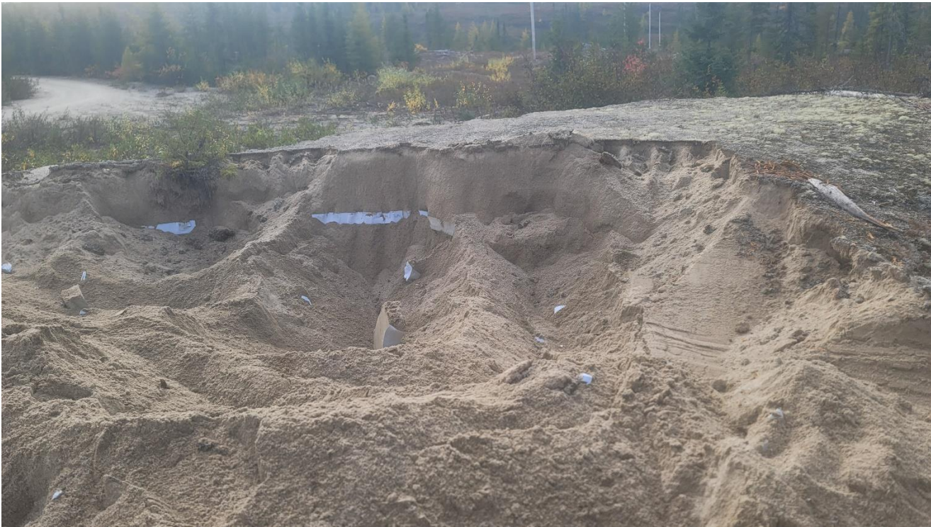
Photo #3 : Démantèlement du champ d'épuration.
