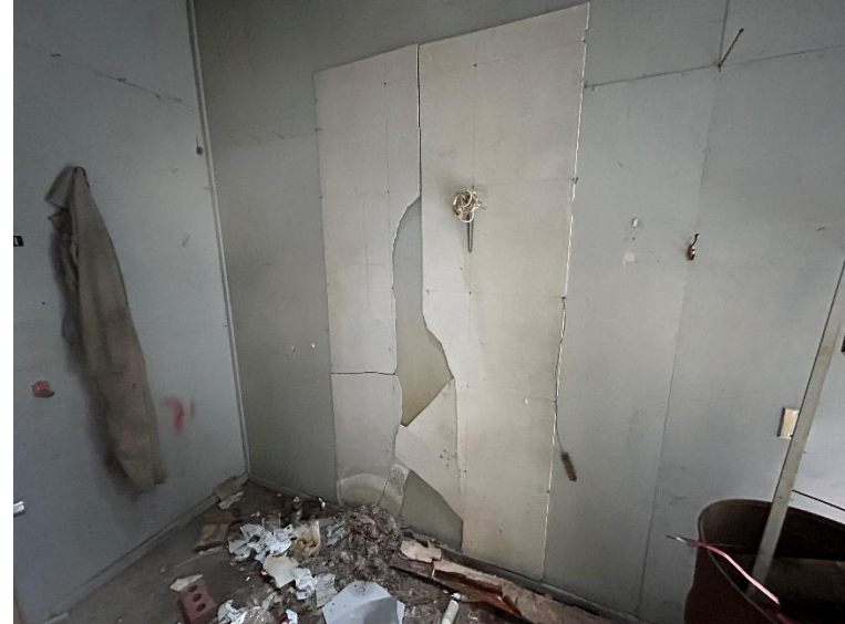
Photo #2 : Amiante ciment dans le garage 4-G
