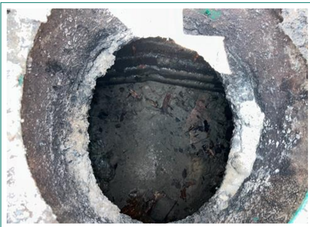
Photo 84 : Vue des boues solides restantes à la suite de la vidange d'eau accumulée dans les fosses septiques (3 juin 2023).
