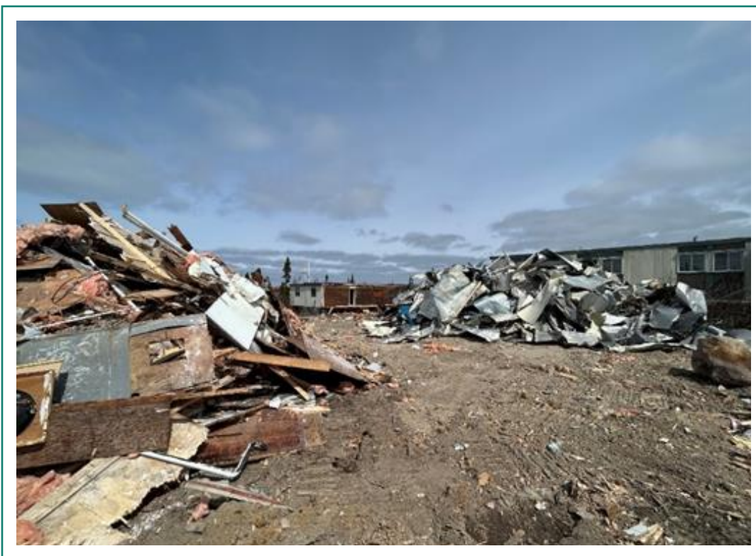
Photo 116 : Piles de matériaux secs ségrégés (bois en avant-plan et tôle en retrait) (22 mai 2023).
