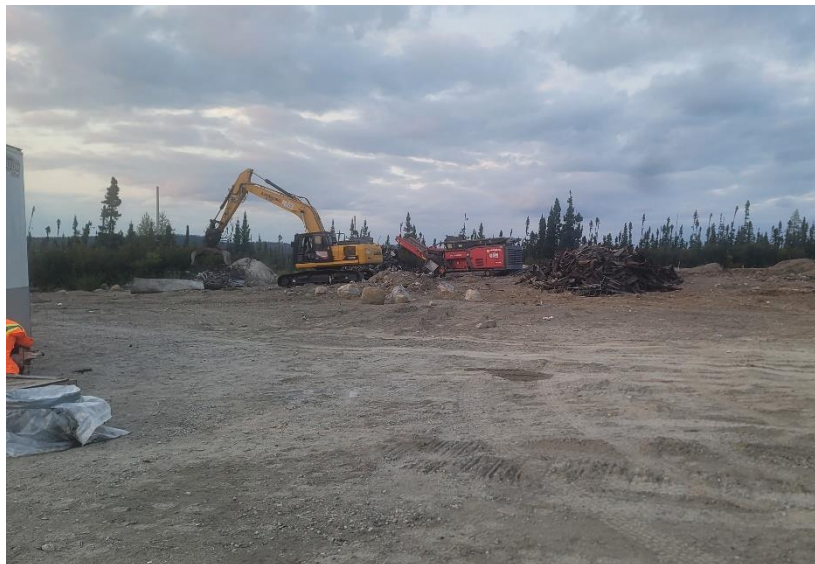
Photo #1 : Continuation du broyage des CRD et barils
