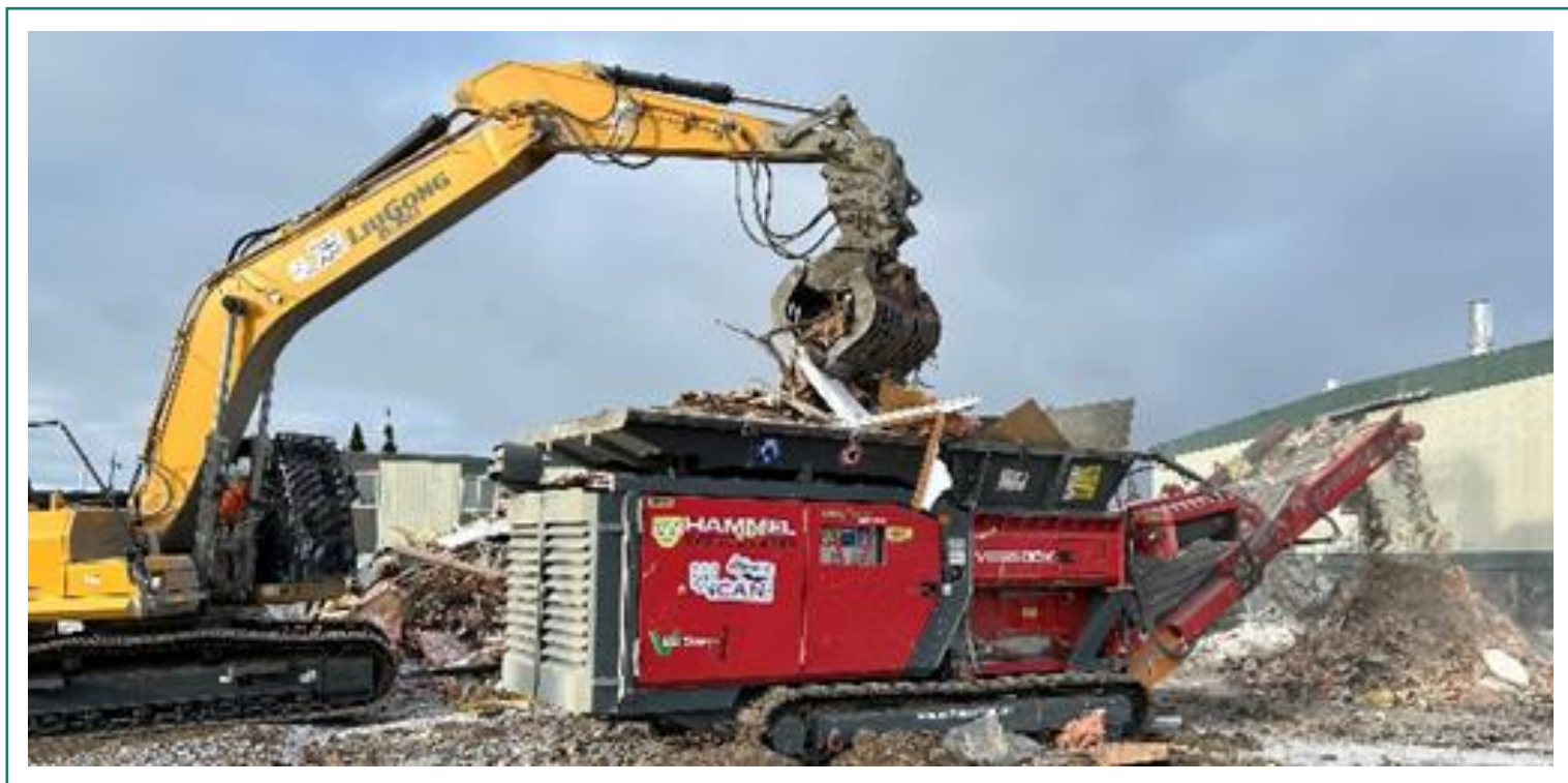
Photo 95 : Excavatrice LuiGong 925-E équipée d'un grappier et broyeur de type Hammel 650 DK.
