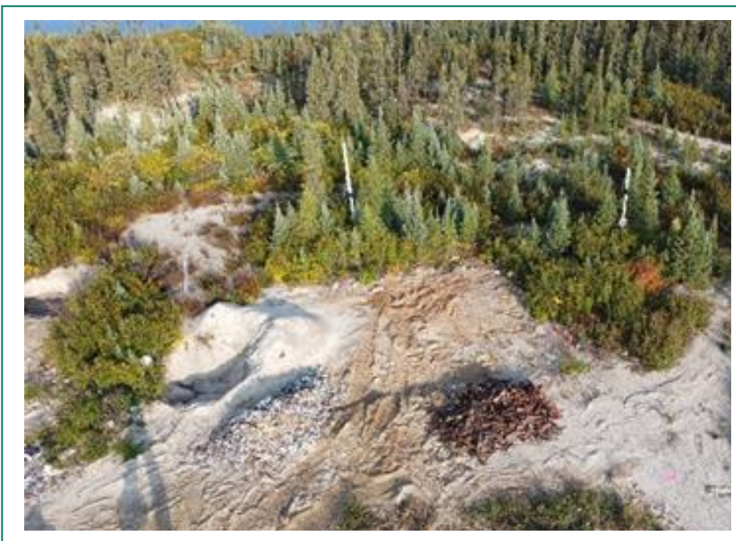
Photo 86 : Vue de l'excavation à la suite du retrait des fosses septiques situées derrière les roulottes 11a-RC (21 septembre 2023).
