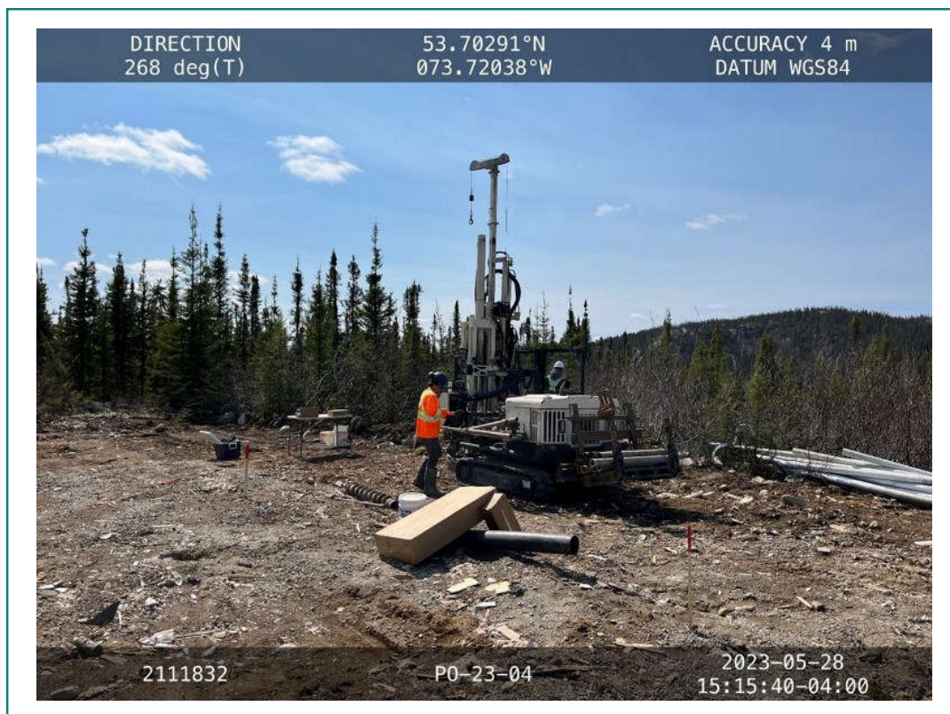
Photo 5 : Vue de la réalisation du forage F-23-04 avec le piquet du sondage F-23-03 à la gauche de la foreuse et le piquet du sondage F-23-05 en avant-plan, à la droite (28 mai 2023).
