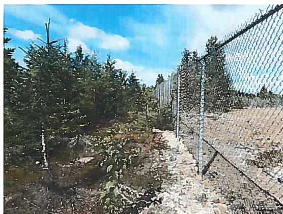
Photographie 2016-09-01_E-SUL-003 La clôture du chantier ouvert est en bon état.
