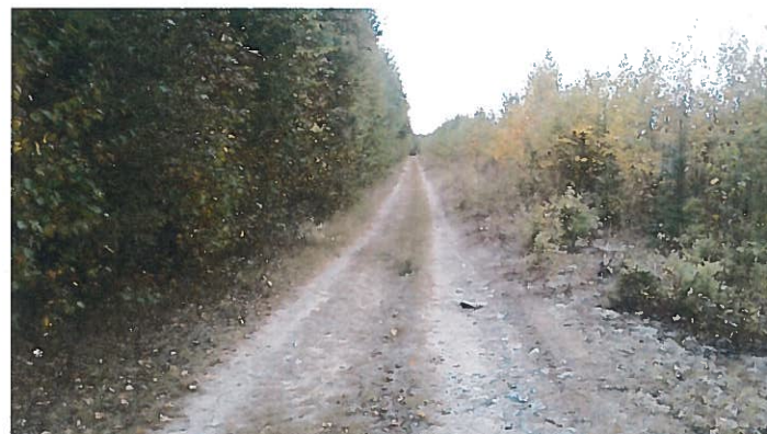
Photographie 2017-09-18_E-SUL-006 Digue nord du bassin nord.
