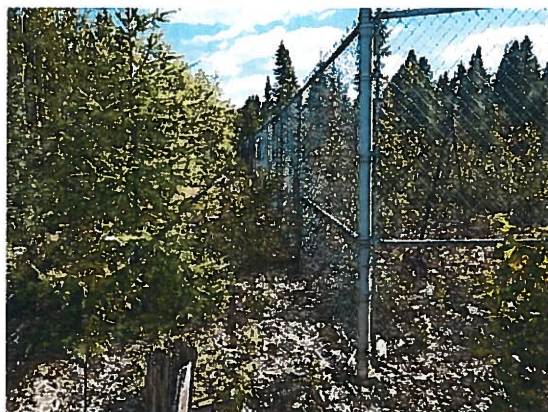
Photographie 2016-09-01_E-SUL-007 Autre portion de la clôture du chantier ouvert.
