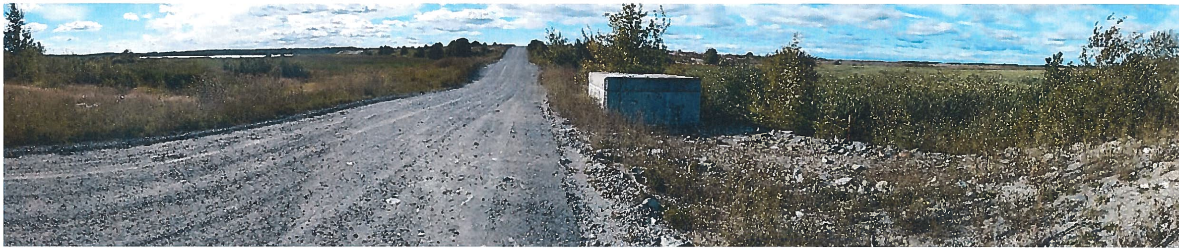
Photographie 2016-09-01_E-SUL-025 — Tour et déversoir d'urgence du bassin est.
