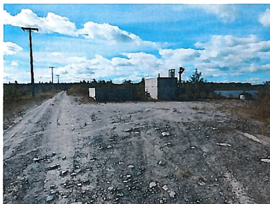
Photographie 2016-09-01_E-SUL-015 Structure de régulation des eaux sortant du bassin sud.
