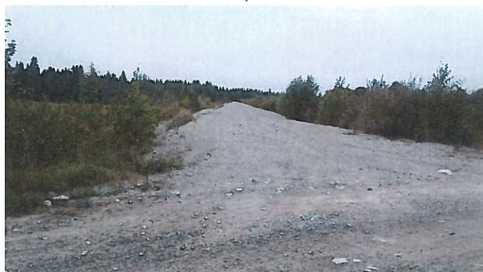
Photographie 2017-09-18_E-SUL-002 Digue bassin ouest est toujours en bon état.
