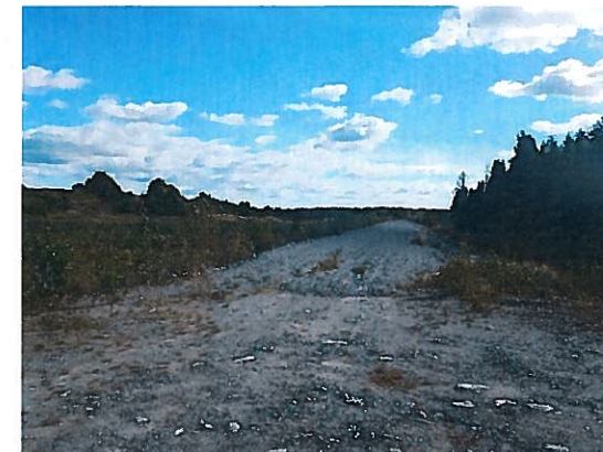
Photographie 2016-09-01_E-SUL-023 Digue ouest du bassin ouest réparé en 2014.
