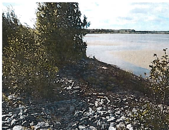
Photographie 2016-09-01_E-SUL-017 Déversoir d'urgence du bassin sud.
