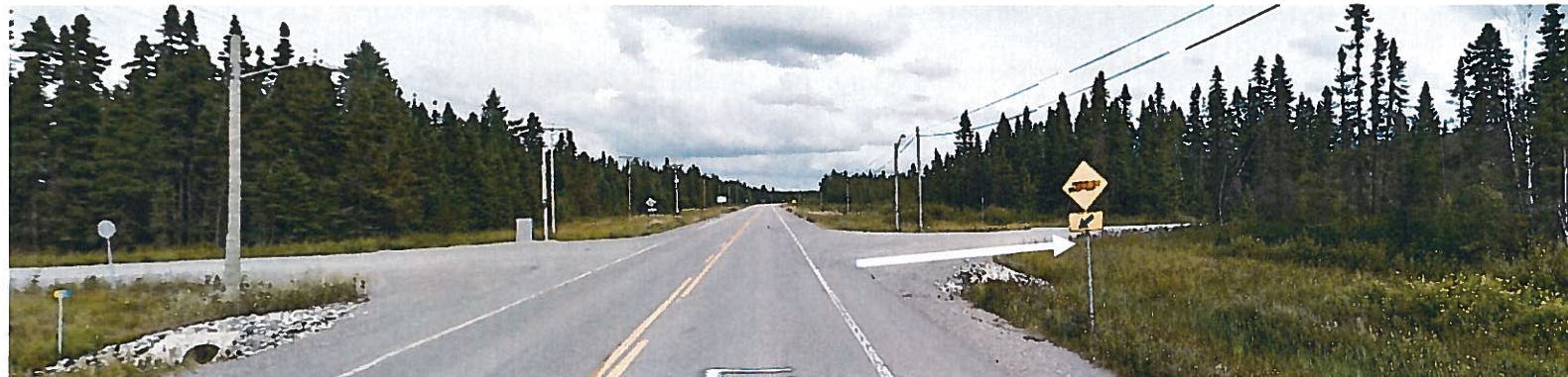
Route 117 vers Louvicourt et intersection de la voie de contournement de Domtar.
