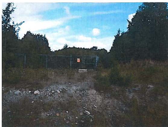
Photographie 2016-09-01_E-SUL-001 La barrière ouest du chantier ouvert est toujours en bon état.
