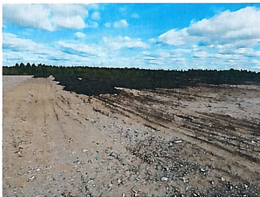
Photographie 2016-09-01_E-SUL-022 Disposition de boues, pour recouvrement final.
