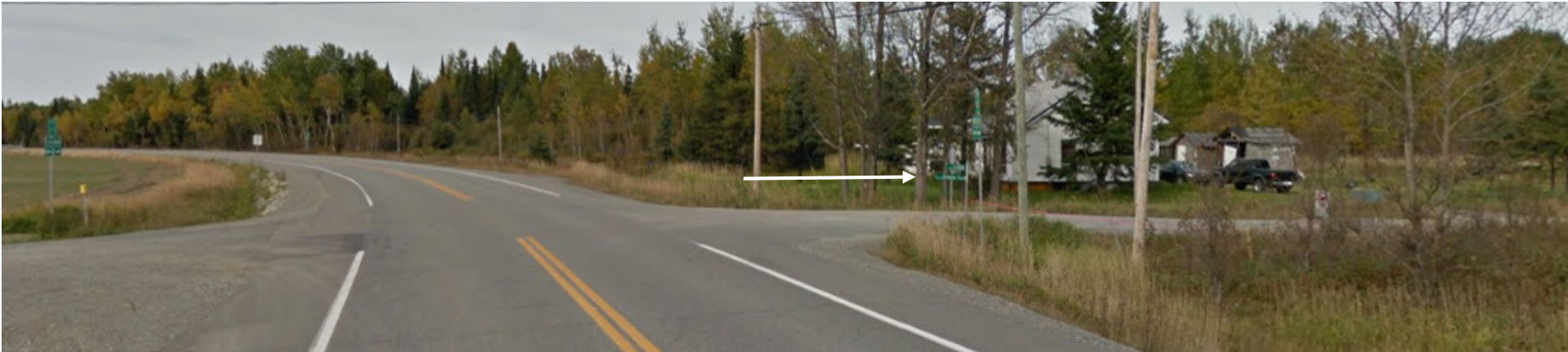
Intersection route 111 et chemin Québec Lithium.
