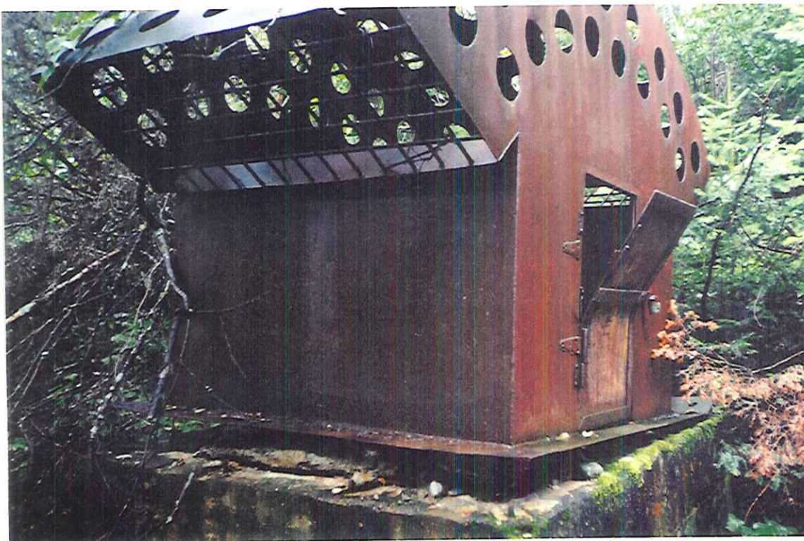
Photo 1. Ancienne bouche de ventilation en acier assise sur la dalle de béton (avant les travaux).
