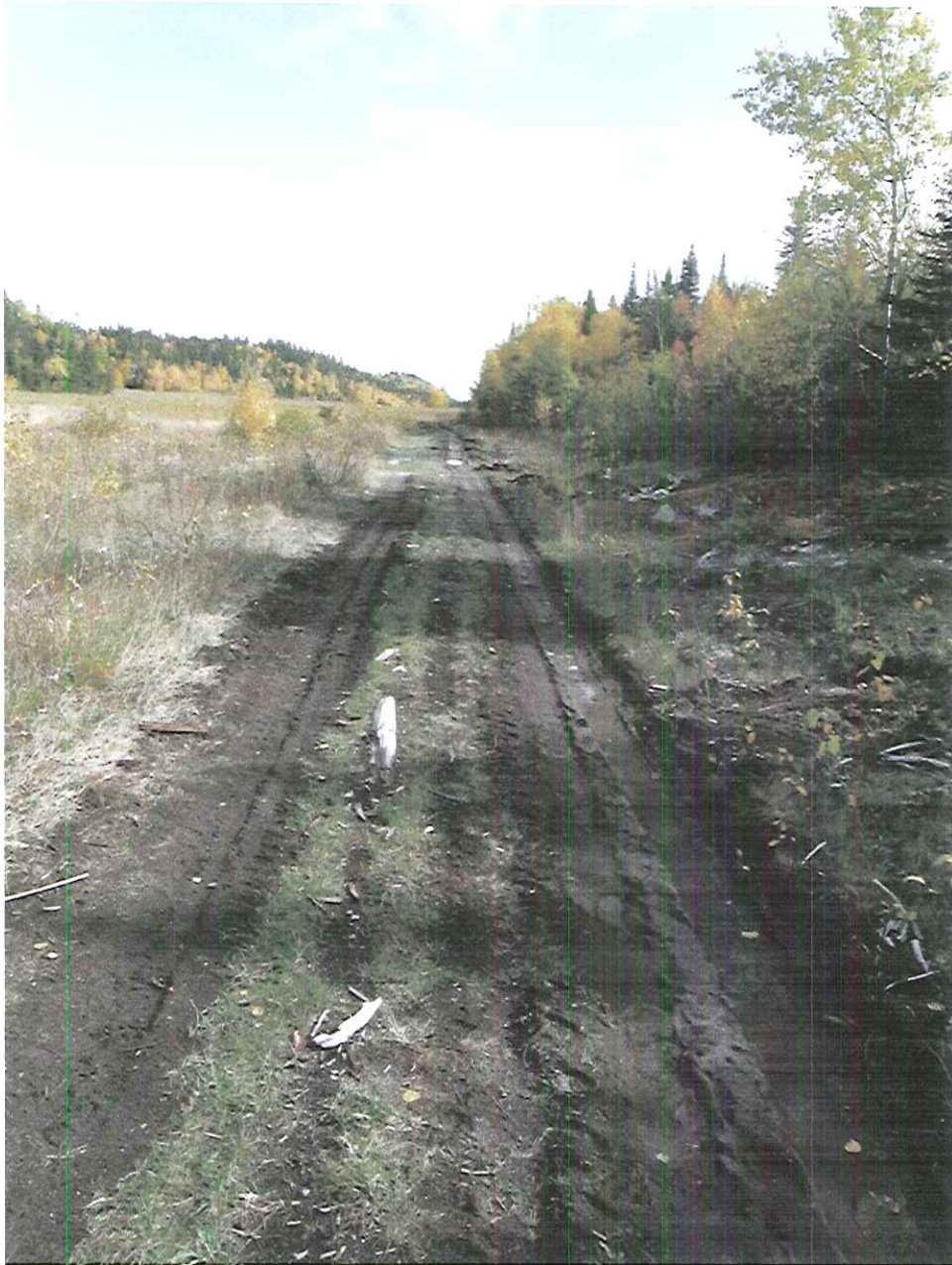
Fig 7 : Le chemin en bordure sud du parc montre de plus en plus des signes évidents d'érosion dû au passage de différents véhicule.
