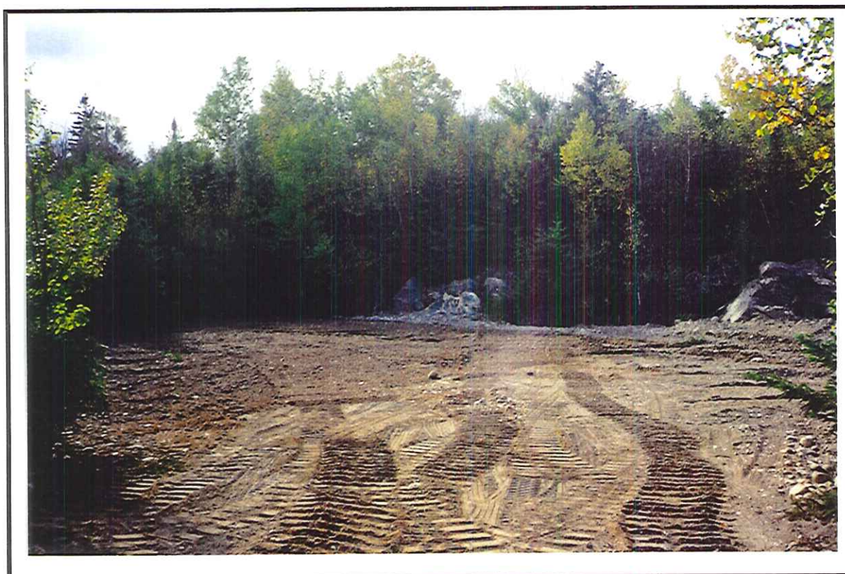
Photo 22. Remblai de l'ancien bassin d'eau.
