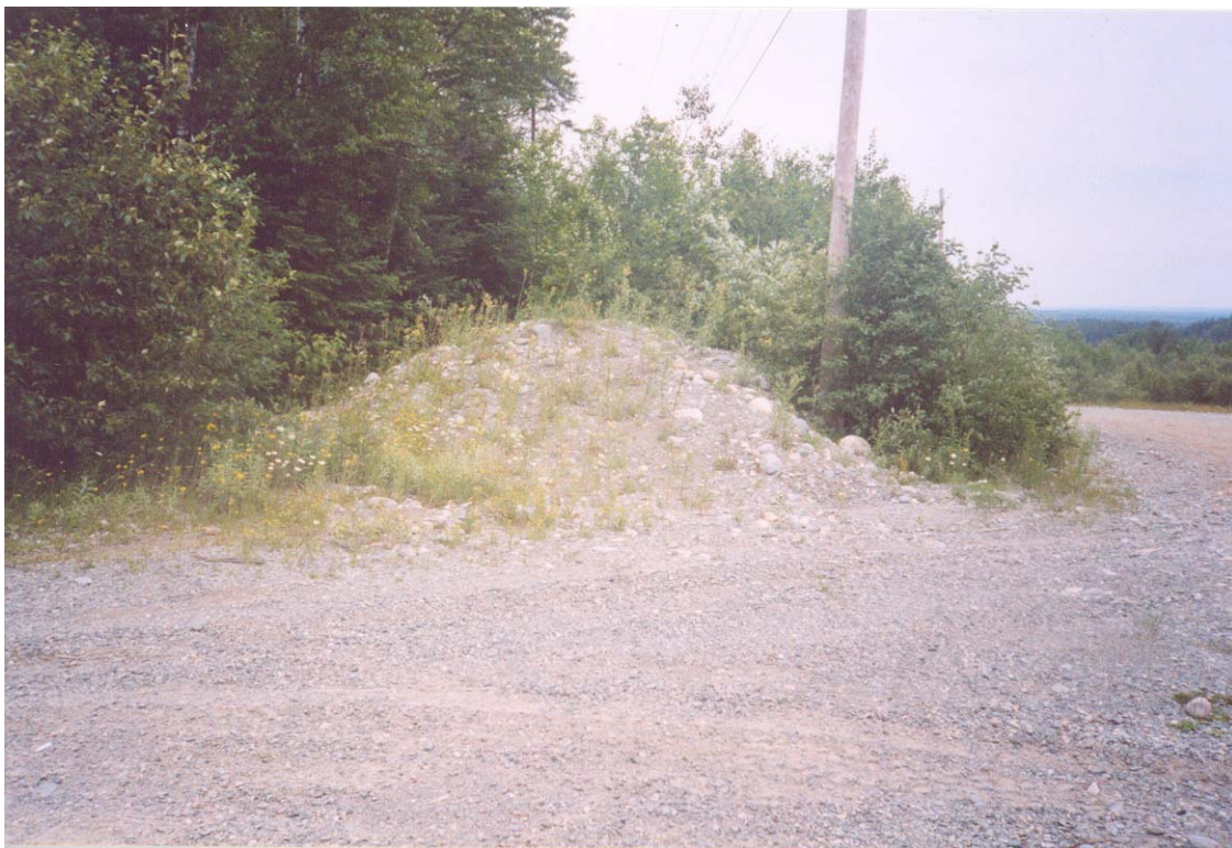
La cheminée #1 est recouverte par une dalle de béton et par des matériaux meubles. Cette dernière est adjacente à la route (coté ouest) et à proximité du sentier qui nous mène aux autres ouvertures et à bâtiment de Télébec.
