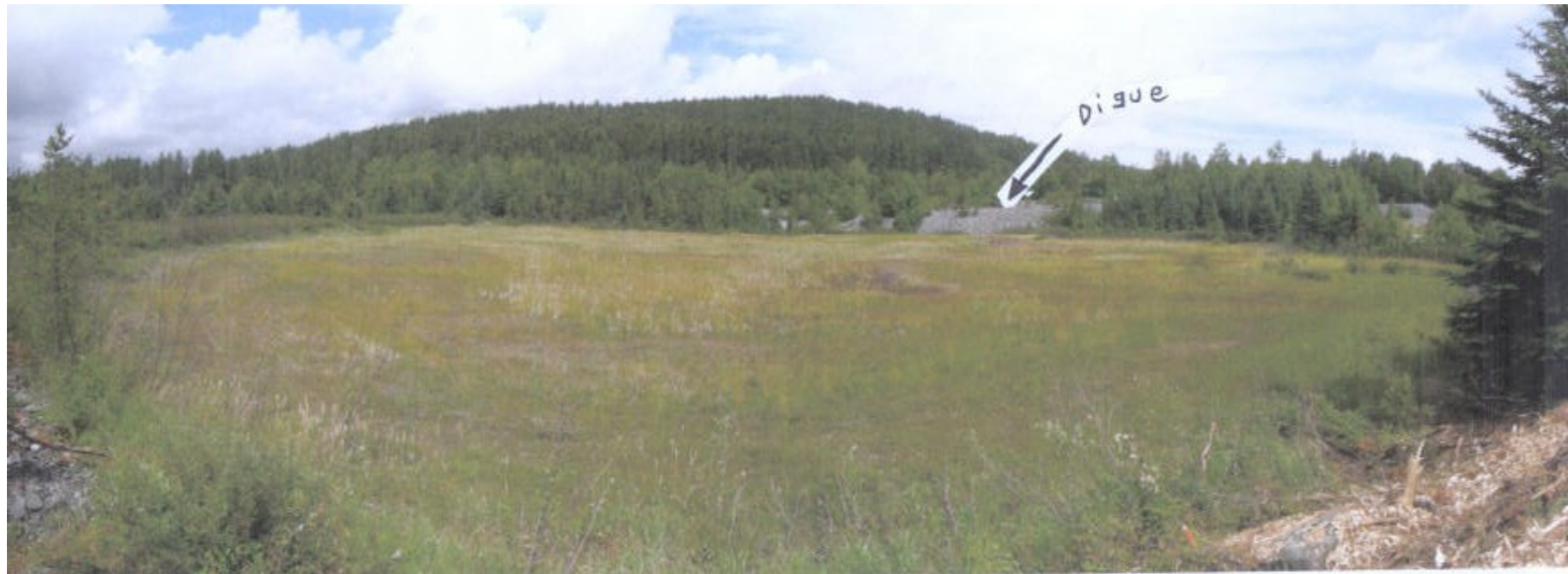
QL-2010-08-04-003 – Le bassin de polissage revégété et au fond la digue ouest
