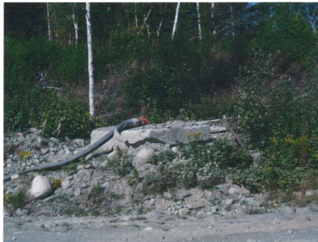
Photographie Qc-Lith_2014-08-29-007 Toujours l'ouverture #3. Cette dernière est située tout près de l'ancien chemin d'accès au site. Le nouveau chemin était en construction, mais les travaux ont subitement été interrompus, à l'automne.
