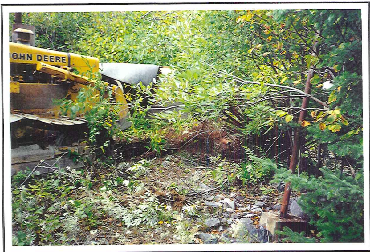
Photo 14. Démantèlement de la vieille clôture.
