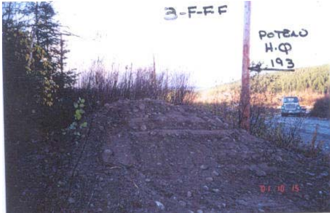
QL-2001-10-011 – Monterie A : recouverte
