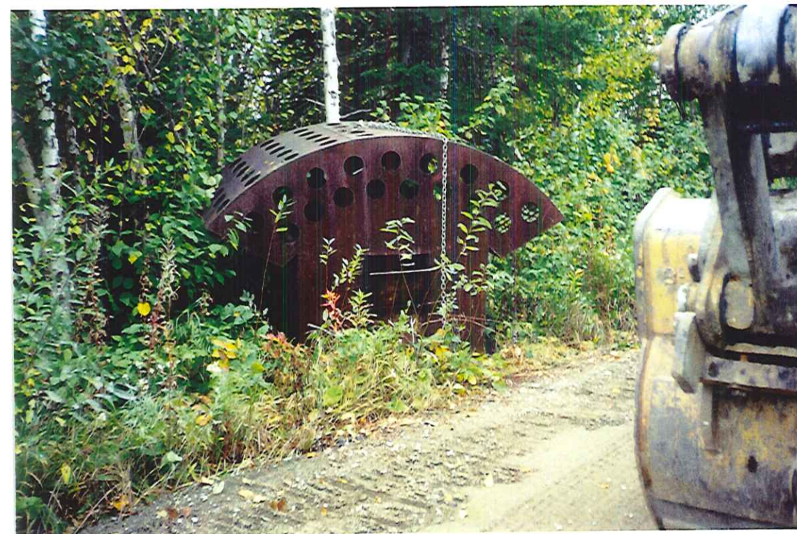
Photo 2. Démantèlement de la bouche de ventilation en acier (après les travaux).
