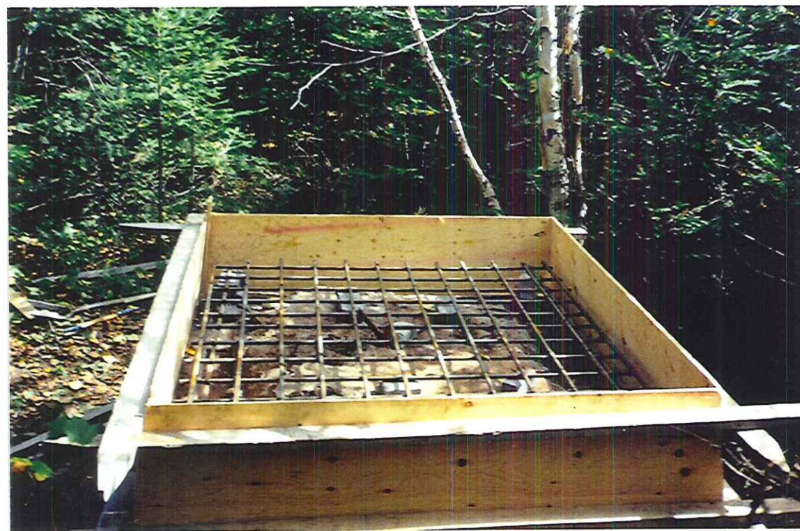
Photo 4. Coffrage pour la coulée de la nouvelle dalle de béton de la cheminée de ventilation.
