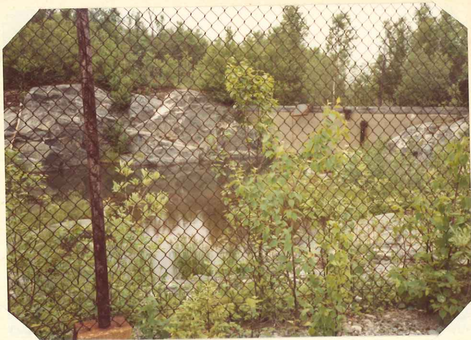
Excavation à ciel ouvert prise en direction Nord. RESERVE D'EAU E-81501A
