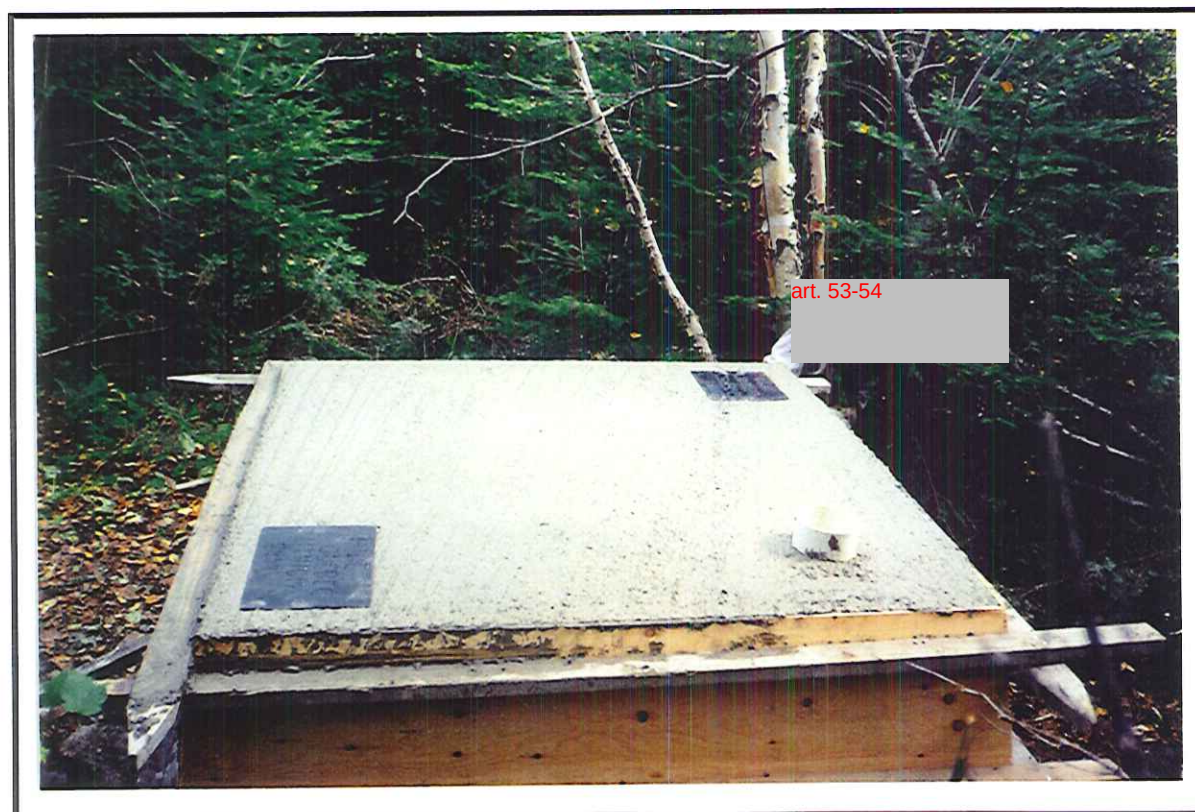
Photo 6. Coulée de la nouvelle dalle de béton de la cheminée de ventilation.
