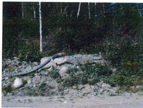
Photographie Qc-Lith_2014-08-29-007 Toujours l'ouverture #1. Cette dernière est située tout près de l'ancien chemin d'accès au site. Le nouveau chemin était en construction, mais les travaux ont subitement été interrompus, à l'automne.
