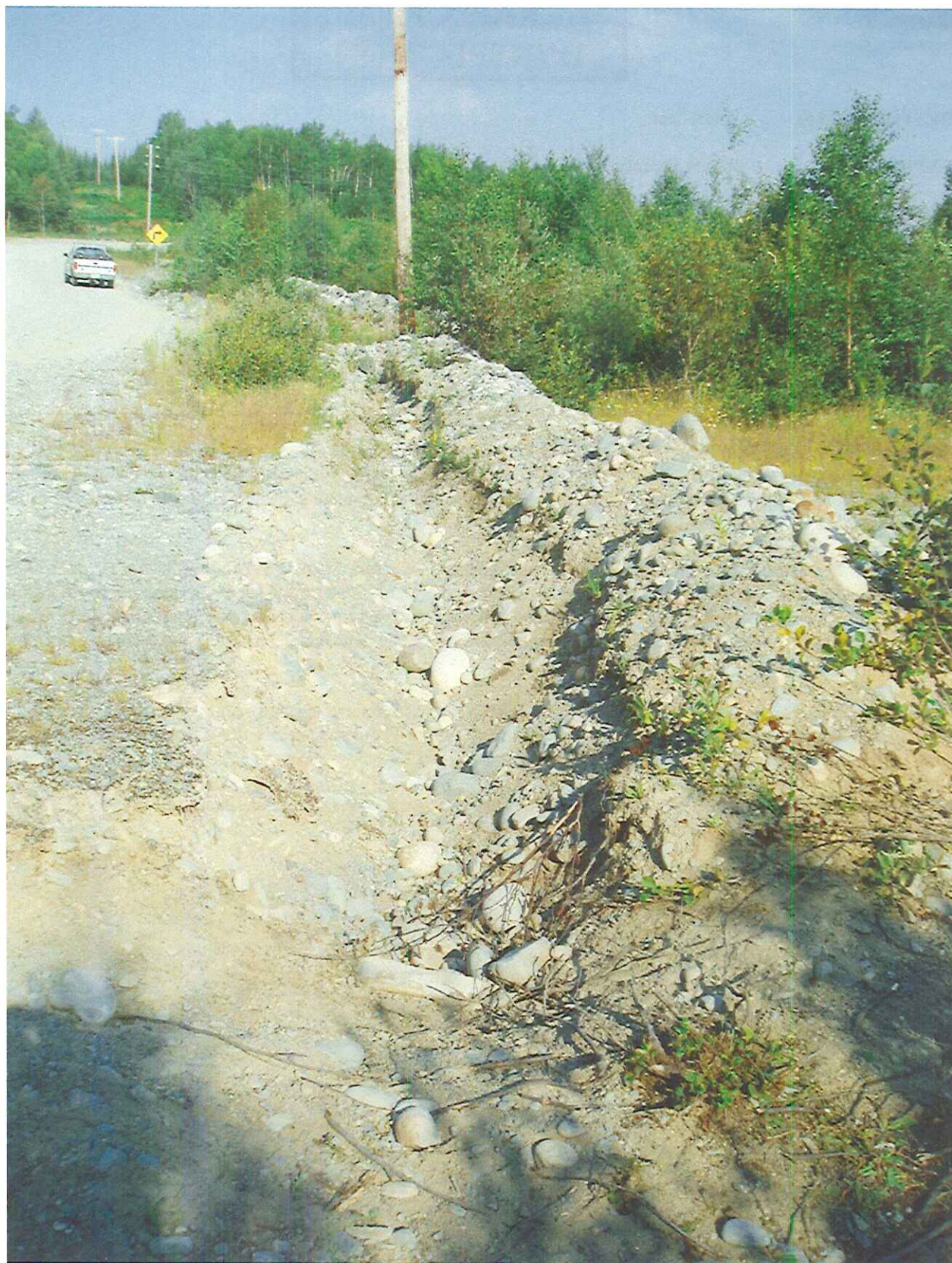
Fig 1 : Le berme et le fossé à l'entrée est du site.
