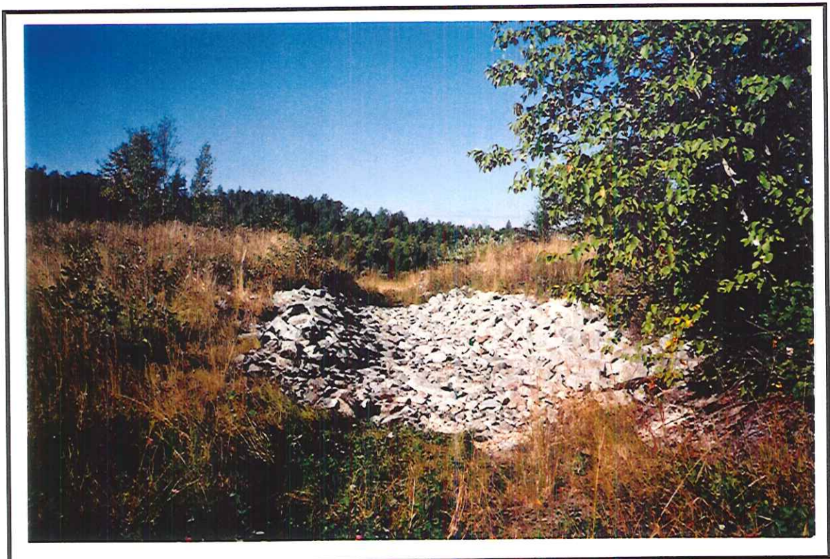
Photo 24. Déversoir du parc à résidus corrigé.
