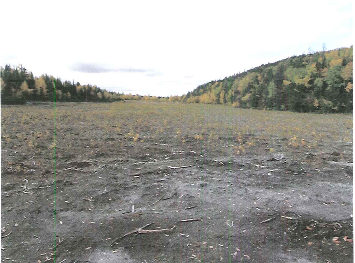
Photo 8 : La partie est du parc à résidus en regardant en direction ouest. Au premier plan on note un manque de végétation.
