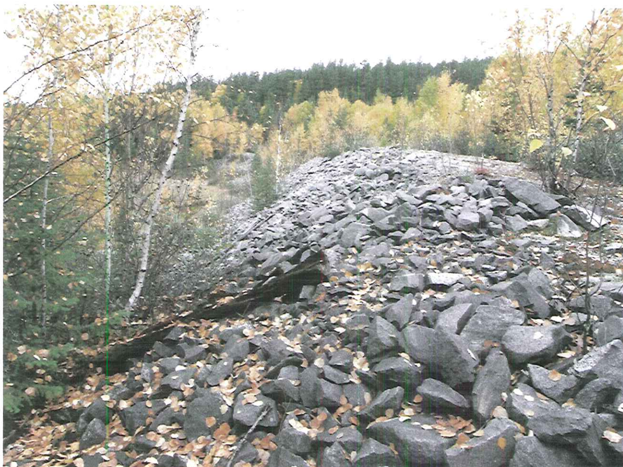
Photo 16 : Une portion de la digue en enrochement à l'extrémité ouest du parc à résidus à peu de distance du secteur de l'ancien bassin de polissage.
