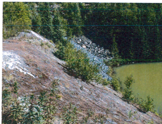
Photographie Qc-Lith_2014-08-29-002 Portion nord de la digue est. On remarque la couleur de l'eau de ce qui est décrit comme étant l'accumulation d'eau nord.
