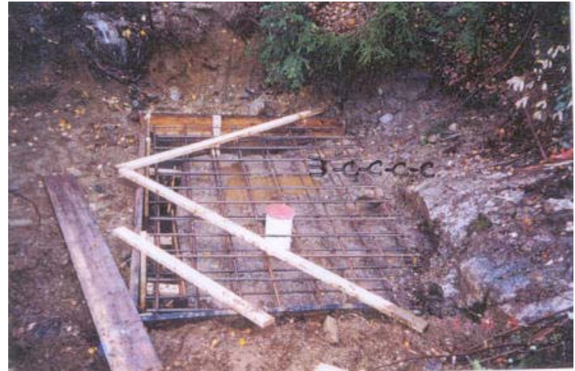
QL-2001-10-012 – Monterie S : dalle de béton
