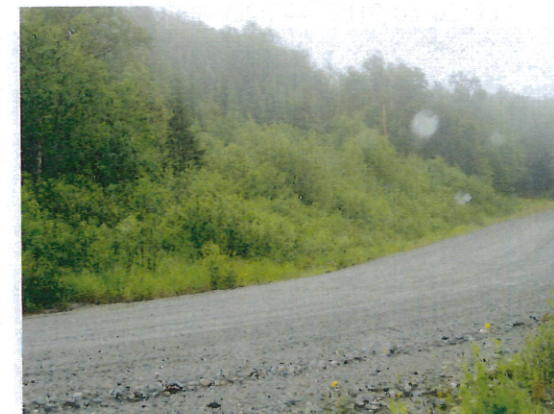
Photographie Qc-Lith_2015-07-07-004 Secteur du pilier de surface potentiellement dangereux
