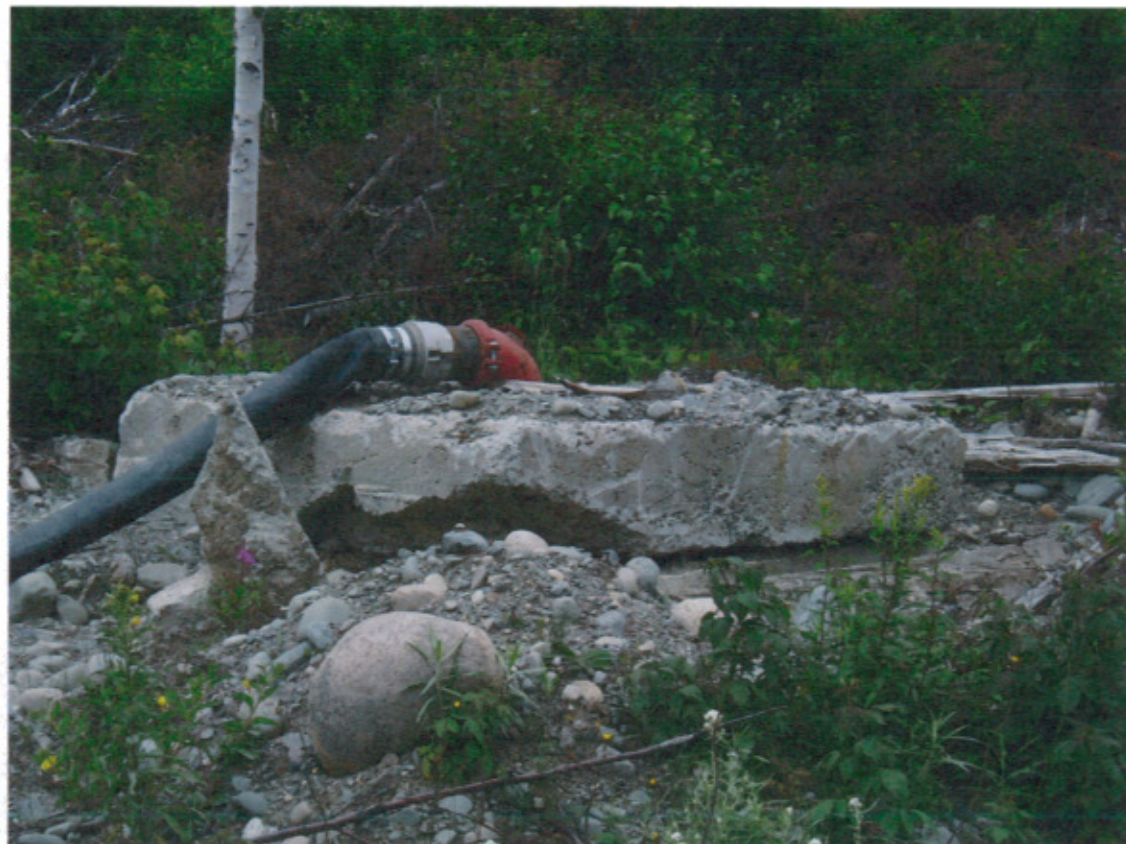
Photographie Qc-Lith_2014-08-29-006 Cheminée #3 vue de près.
