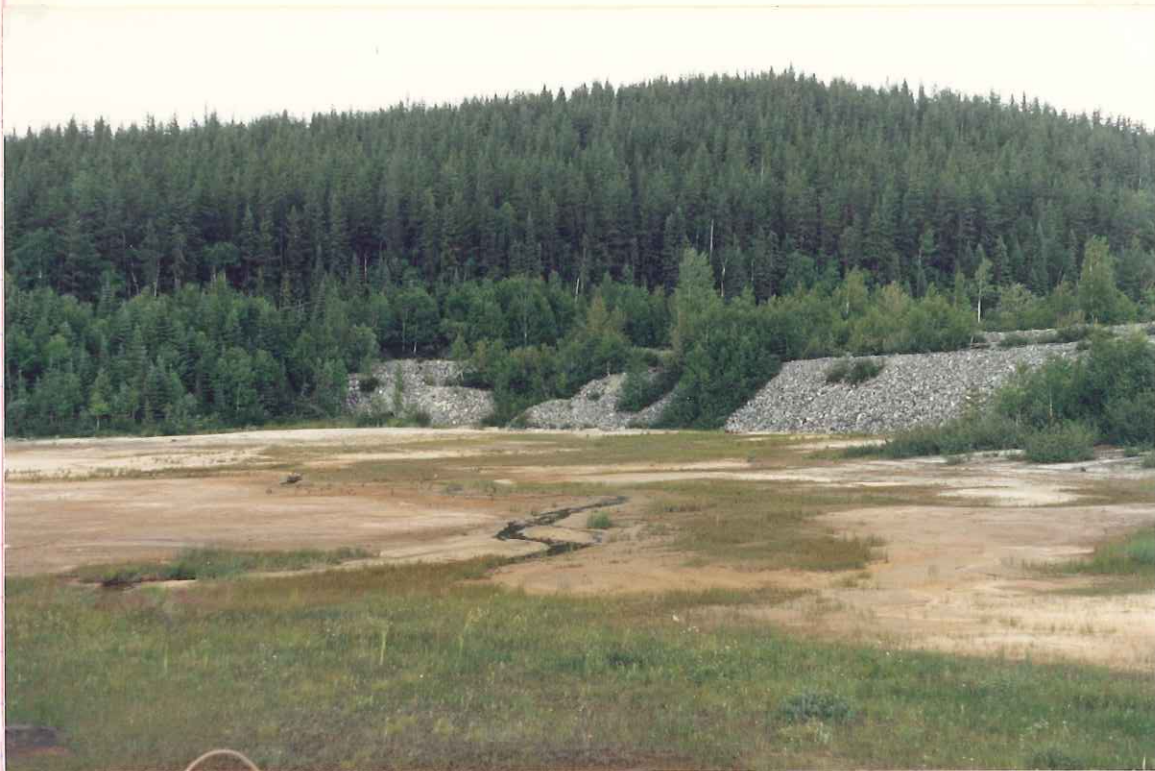
Vue Nord prise en bas de la digue à l'extrémité Ouest
