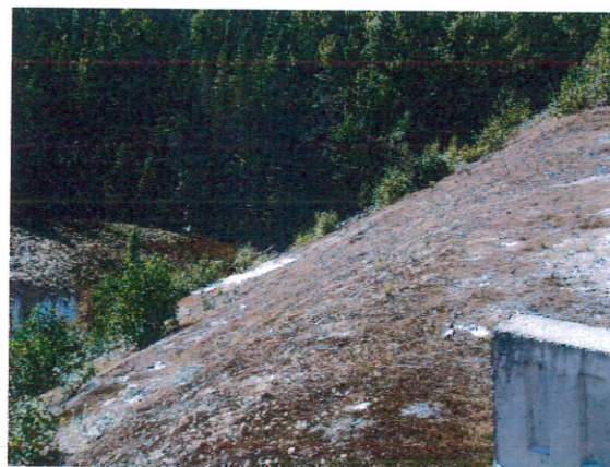
Photographie Qc-Lith_2014-08-29-003 Portion sud de la digue est. L'eau présente dans cette portion (accumulation sud) est différente de celle de l'accumulation nord. Sur les plans joints en annexe on voit bien que ces deux accumulations sont distinctes.
