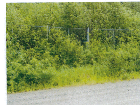
Photographie Qc-Lith_2015-07-07-005 Clôture qui ceinture le pilier de surface potentiellement dangereux.
