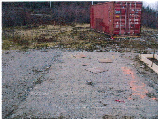
Photographie Qc-Lith_2012-10-31-001 Des travaux ont été effectués dans le secteur du puits, car maintenant la dalle qui recouvre ce dernier est bien visible.
