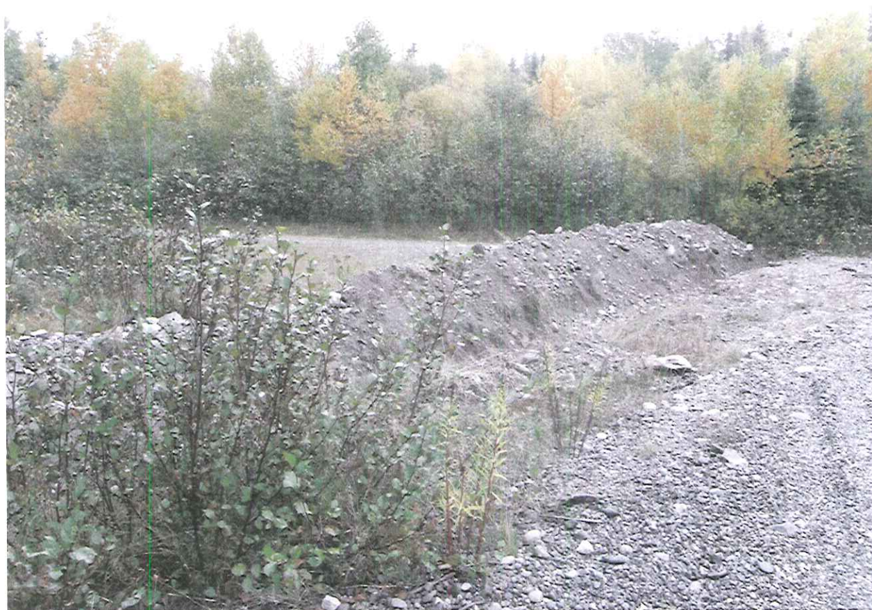
Fig 1 : L'ensemble berme et fossé à l'accès est.
