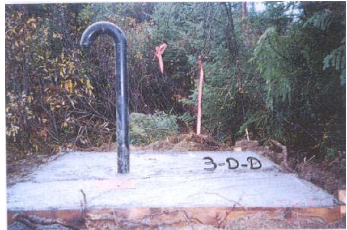
QL-2001-10-008 – Montrie ventilateur de surface : dalle de béton
