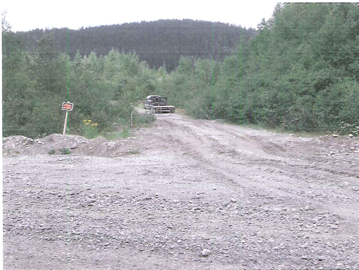
Photo 1 : L'accès est du site et ce qui reste du berme à gauche. UTM nad 83, 18U : 0292189E / 5365757N.
