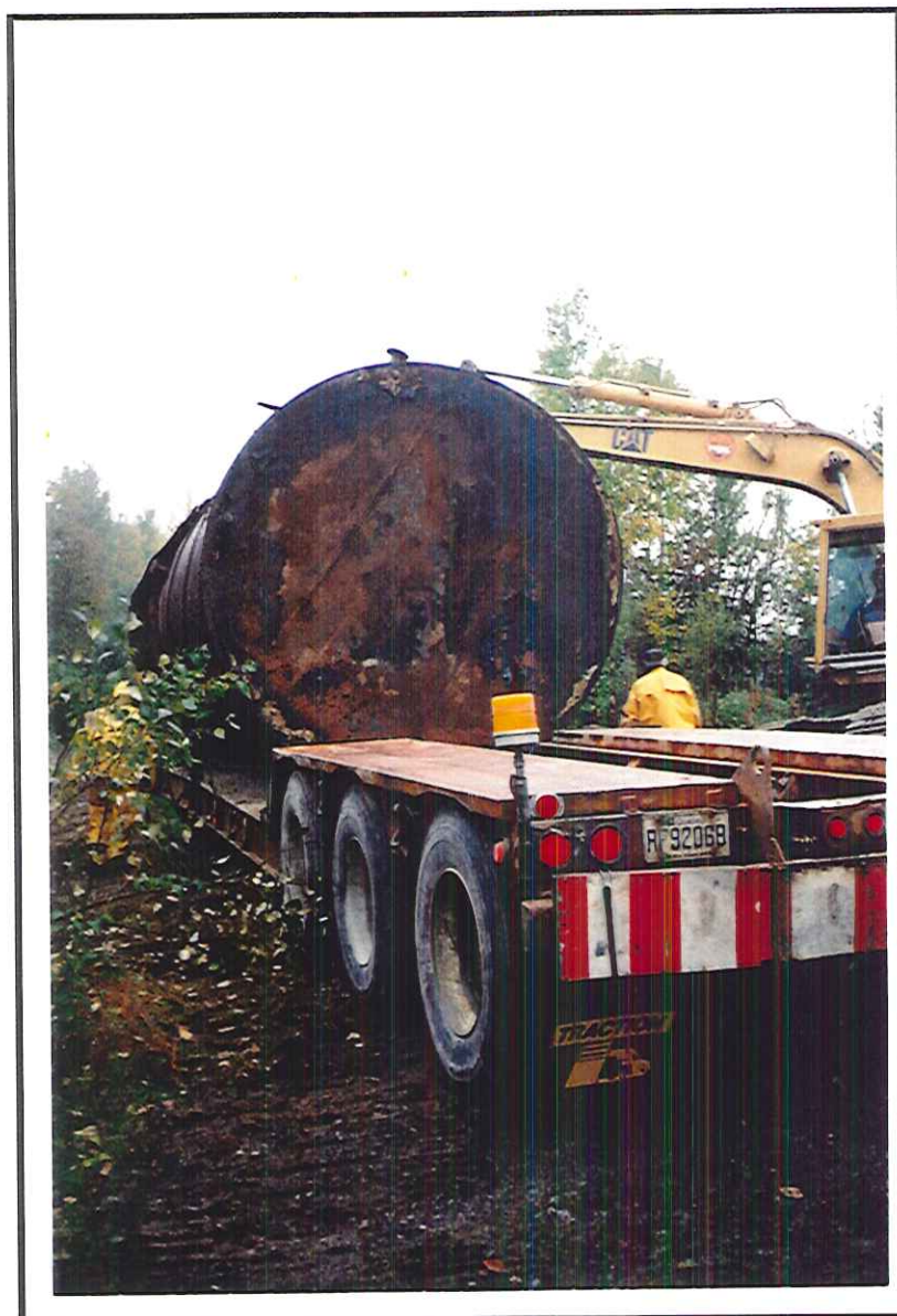
Photo 11. Démantèlement et disposition de l'ancien réservoir à eau.
