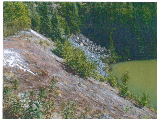
Photographie Qc-Lith_2014-08-29-002 Portion nord de la digue est. On remarque la couleur de l'eau de ce qui est décrit comme étant l'accumulation d'eau nord.
