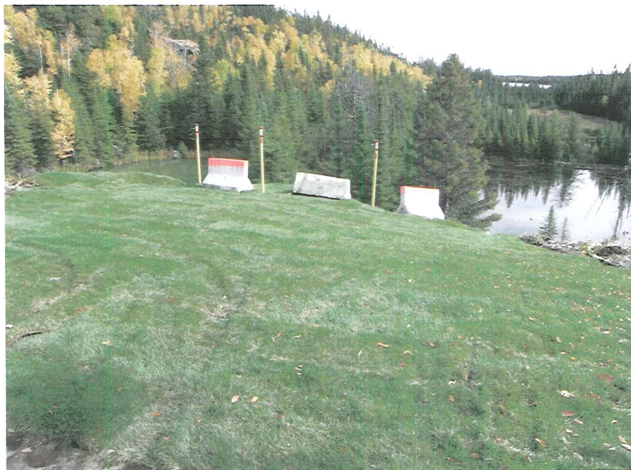
Photo 12 : Les récents travaux correcteurs de Iamgold à l'extrémité est du parc.
