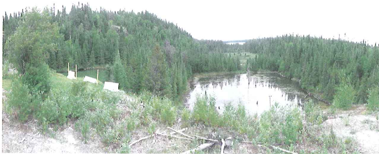
Photo 8 : Les 2 bassins de sédimentation au pied de la digue est du parc à résidus. UTM nad 83, 18U : 0292740E / 5366210N.
