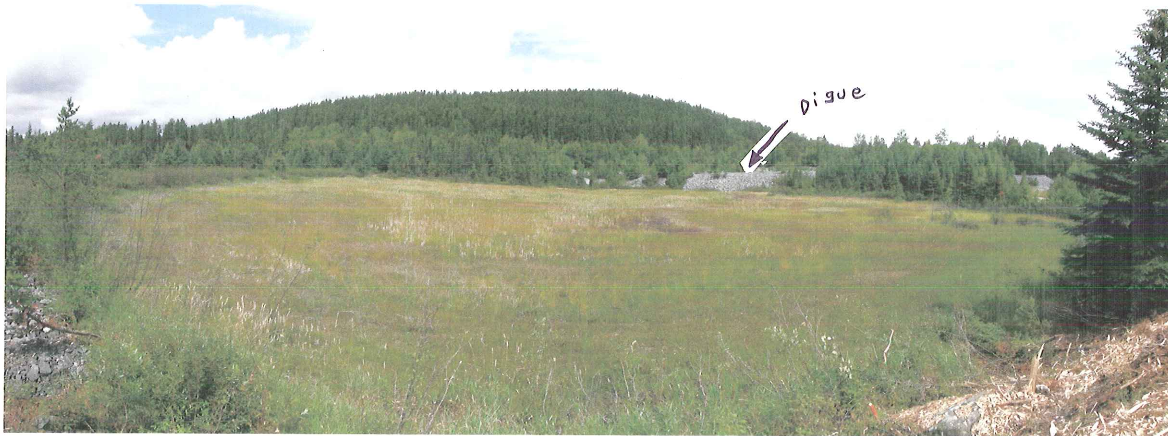
Photo 5 : En gris au fond la digue ouest du parc à résidus miniers et à l'avant plan le bassin de polissage revégété. UTM nad 83, 18U : 0292085E / 5366166N.
