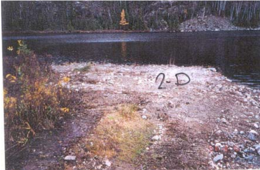
QL-2001-10-005 – La prise d'eau au lac Roy après la restauration
