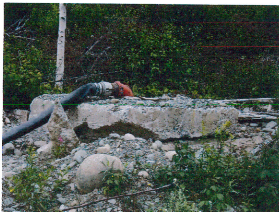
Photographie Qc-Lith_2014-08-29-006 Cheminée #1 vue de près.
