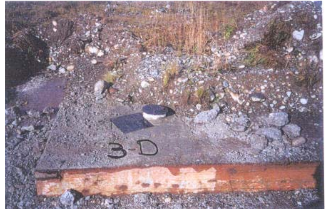
QL-2001-10-006 – Puits principal : dalle de béton
