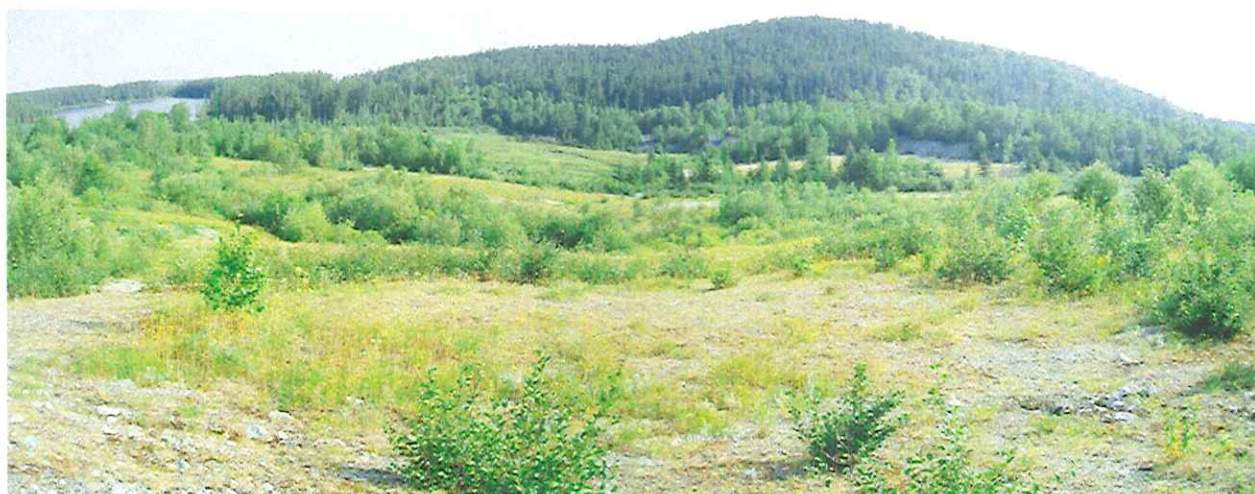
Fig 3 : Une partie du site des infrastructures et au fond à gauche le lac Lortie (vue à partir du chemin).
