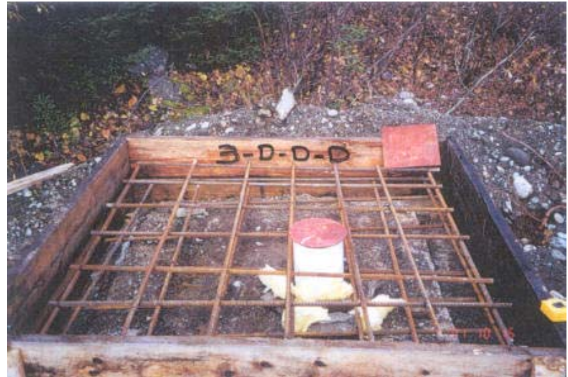
QL-2001-10-010 – Monterie A : dalle de béton
