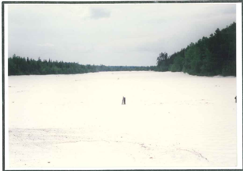
Surface du parc à résidus, confiné par deux digues à chaque extrémité.
