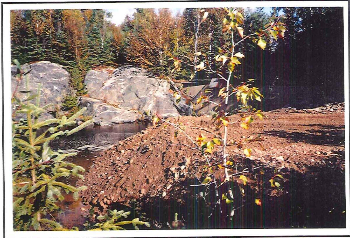
Photo 18. Remblai de l'ancien bassin d'eau.
