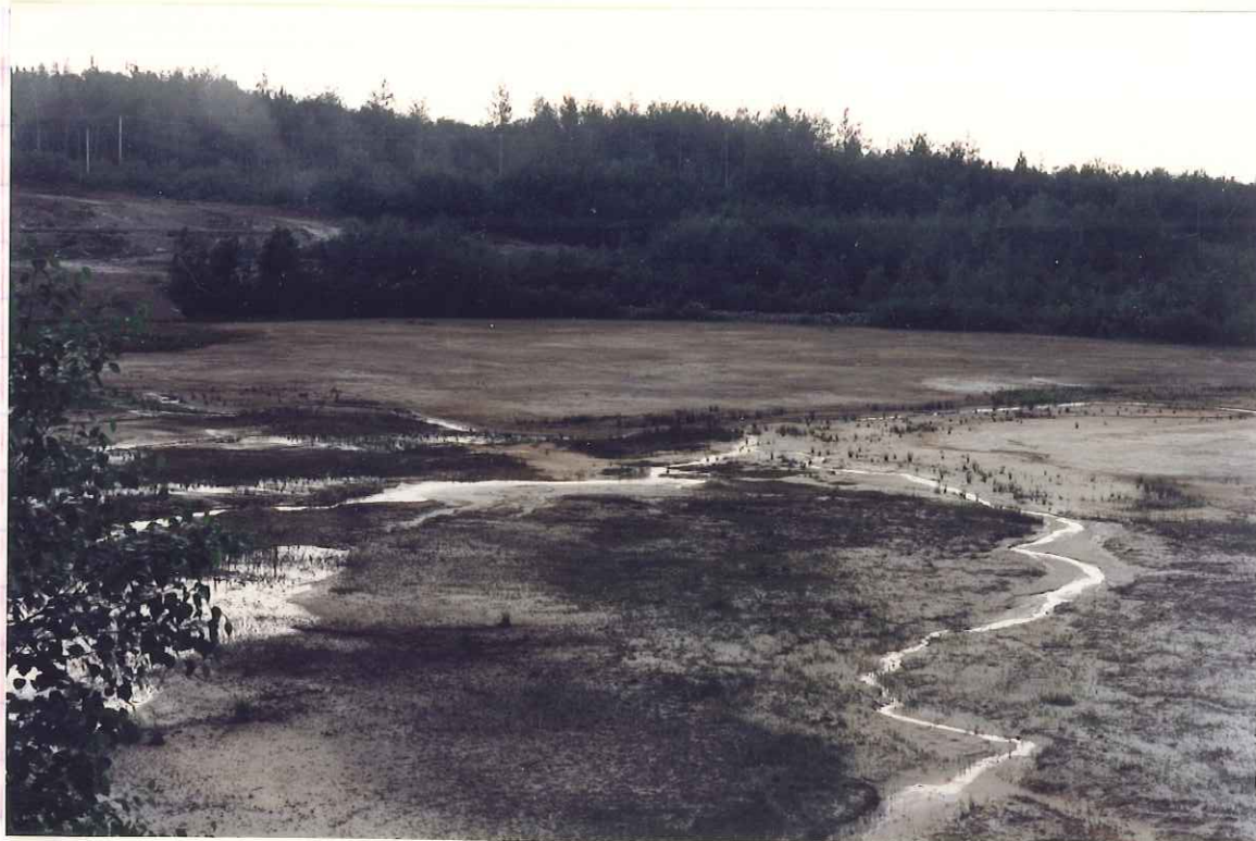
Vue Ouest prise sur la digue à l'extrémité Ouest (montrant les résidus au bas de la digue)
