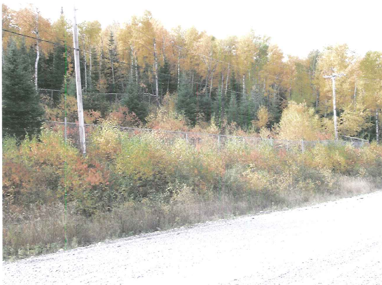
Photo 17 : La clôture au chantier 1A3E est toujours en bon état.
