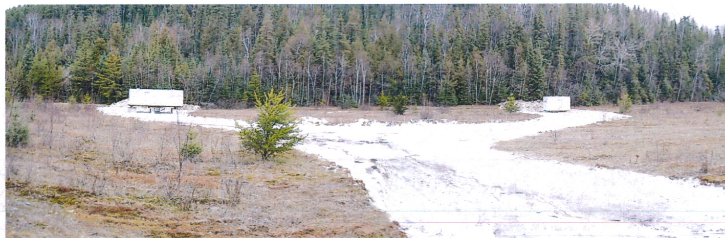
Photographie Qc-Lith_2012-10-31-003 Pour aménager les entrepôts d'explosifs, la compagnie Québec lithium a retiré une partie de la végétation pour aménager des routes d'accès.
