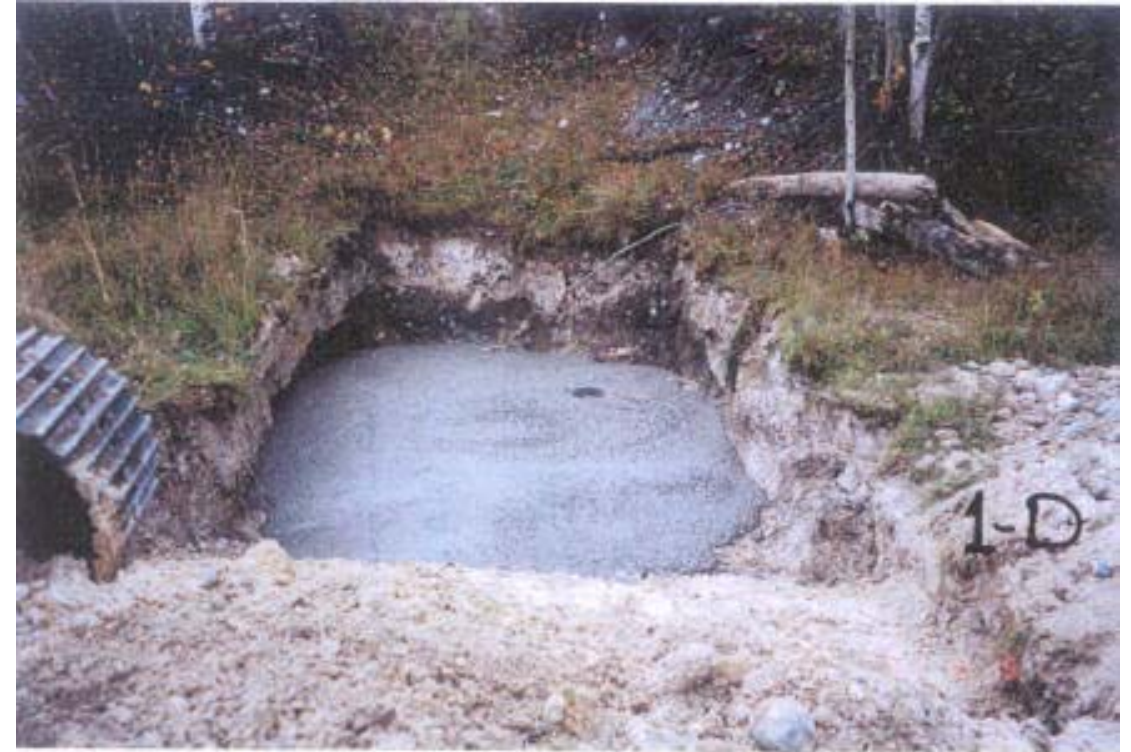
QL-2001-10-002 – Tour de décantation : dalle de béton
