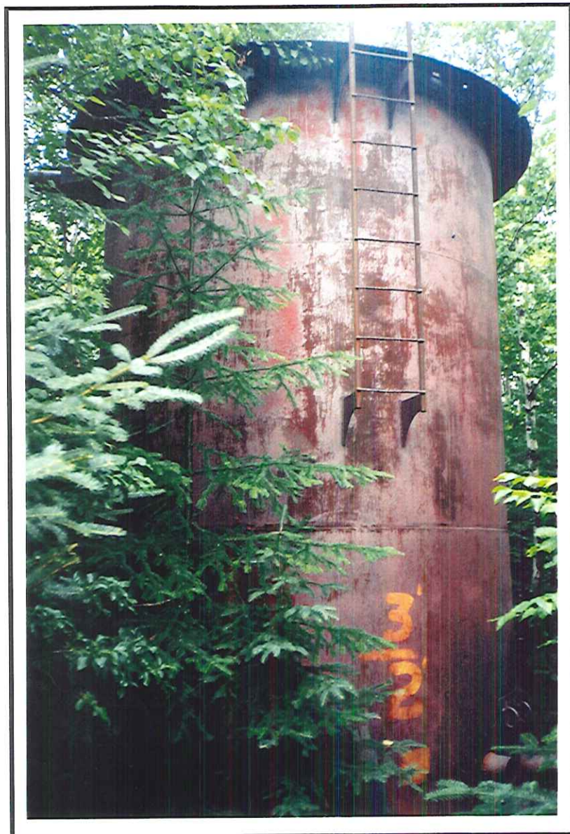
Photo 10. Ancien réservoir à eau ( avant les travaux ).
