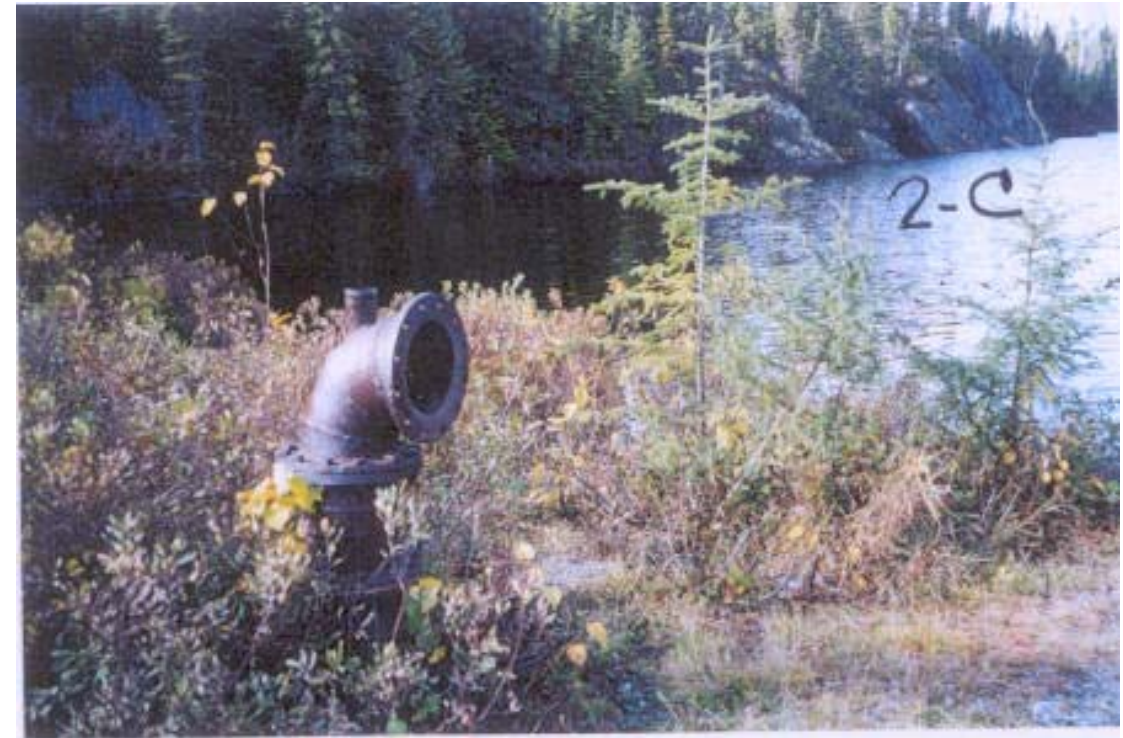
QL-2001-10-004 – La prise d'eau au lac Roy avant la restauration
