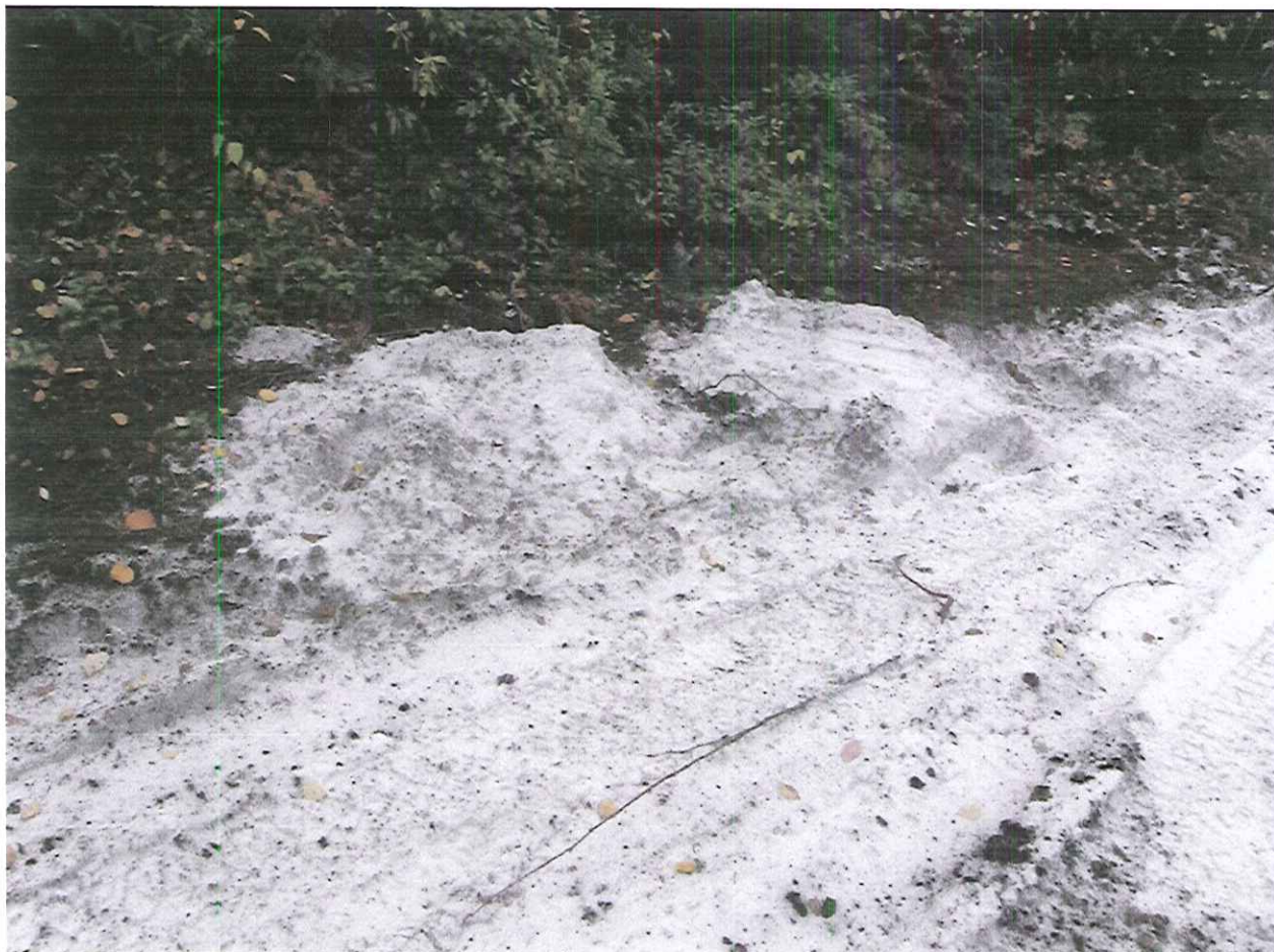
Photo 11 : Les résidus affleurent en plusieurs endroits le long du chemin de la périphérie sud du parc.
