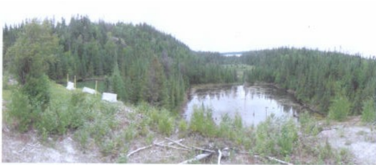
QL-2010-08-04-004 – Les 2 bassins de sédimentations au pied de la digue est.
