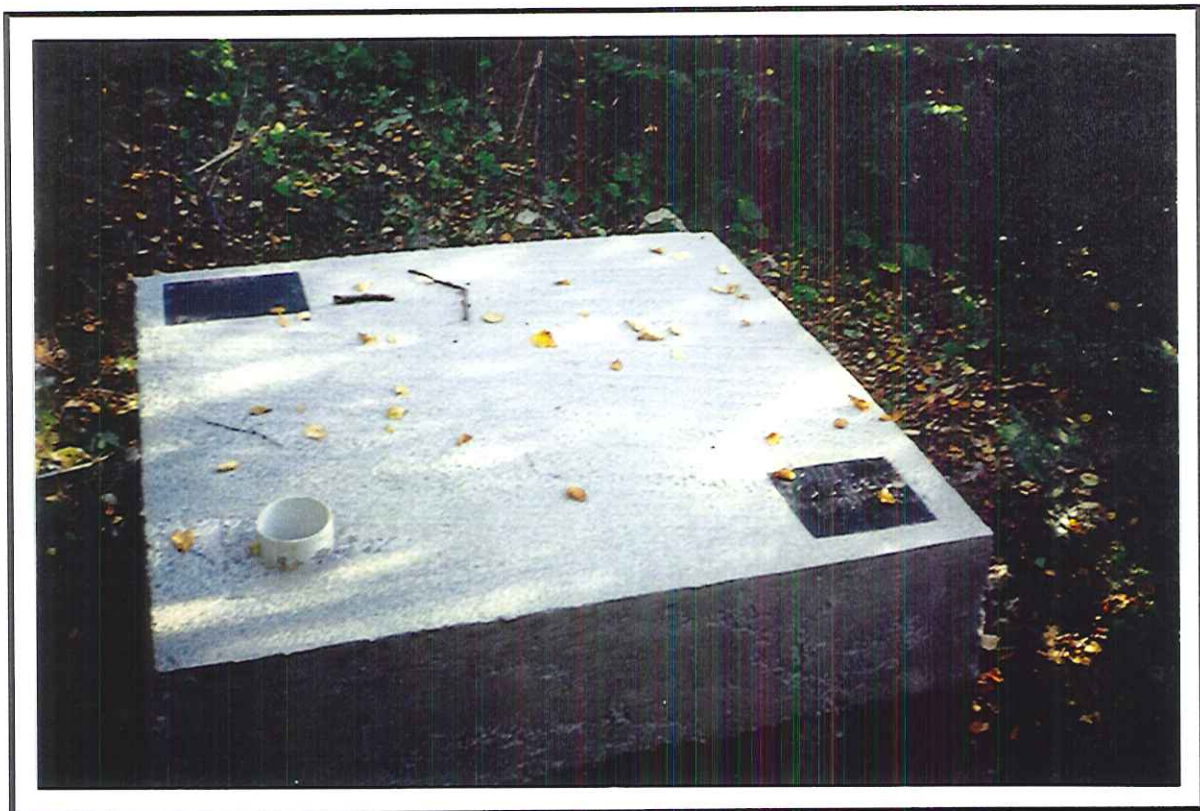
Photo 9. Dalle de béton de la cheminée de ventilation terminée (après les travaux).
