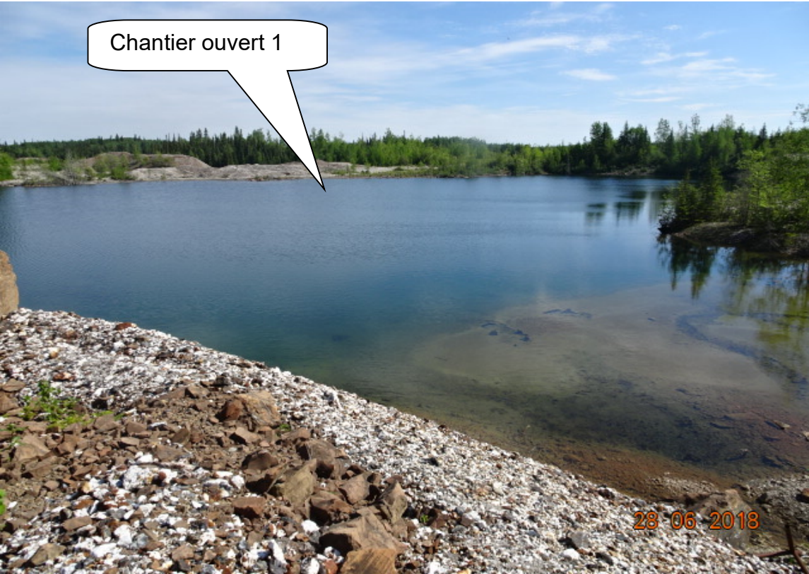
IS-2018-06-28-005 – Du côté Sud-Ouest, vue du chantier ouvert 1 (vue vers le Nord-Est) Coordonnées UTM Nad83 : 584595 Est, 5565588 Nord
