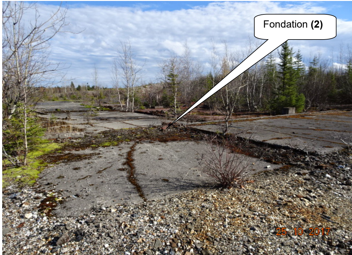
IS-2017-10-25-003 – Fondation de béton (2) (vue vers l'Est)
