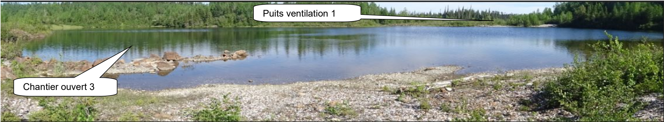
IS-2018-06-28-003 – Chantier ouvert 3 et le puits de ventilation 1 conforment (vue Ouest vers l'Est) Coordonnées UTM Nad83 : 584456 Est, 5566472 Nord
