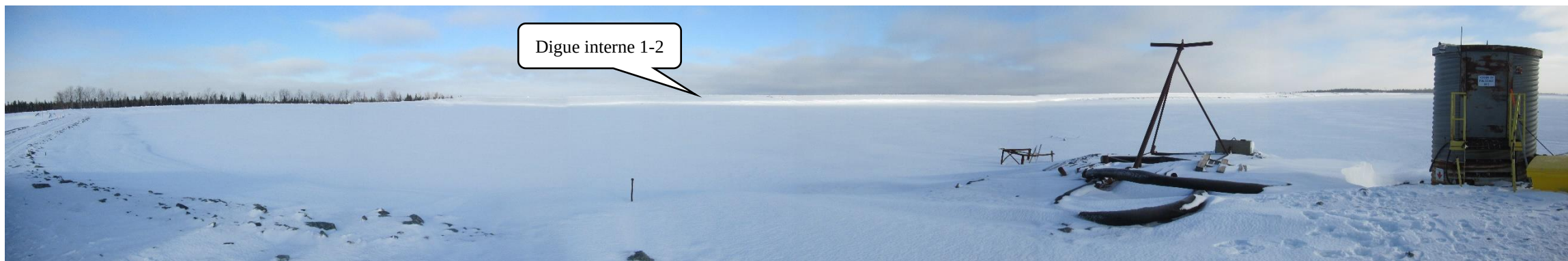
2021-12-03_CAM_014 : Bassin 1 du parc à résidus et station de pompage
