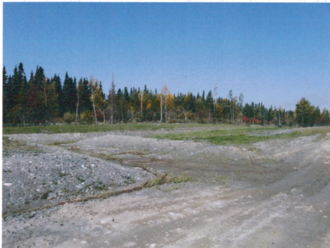
Photo Camflo-2014-09-26-009 : Déversoir d'urgence construit depuis la dernière inspection à l'ouest du bassin no 1.
