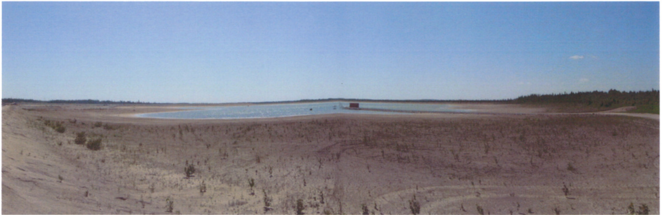
Photo 7 : Cellule no 1 du parc à résidu. Coordonnées de la photo UTM NAD 83 : 17U : 720357 E / 5336616 N
