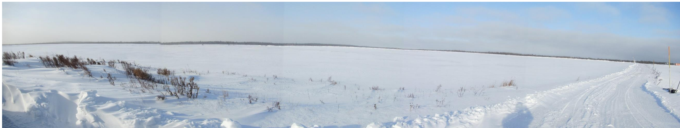
2021-12-03_CAM_011 : Bassin 3 du parc à résidus et digue interne pour l'accès à la station de pompage
