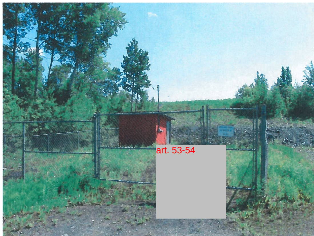
Photo Camflo-2012-06-21-001 : Ancien effluent provincial, situé à la sortie du bassin no 1
