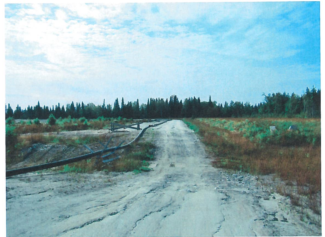
Photo Camflo-2017-08-29-009 : Déversoir d'urgence sur la digue 1-ouest
