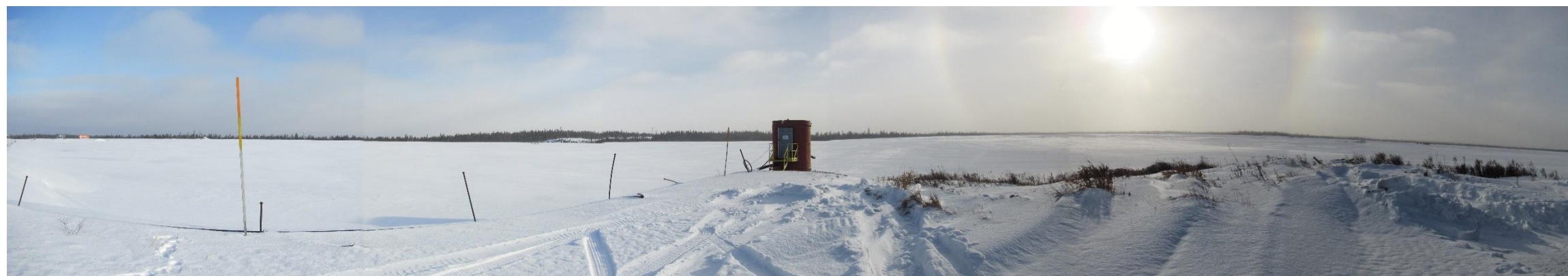
2021-12-03_CAM_010 : Bassin 3 du parc à résidus et station de pompage
