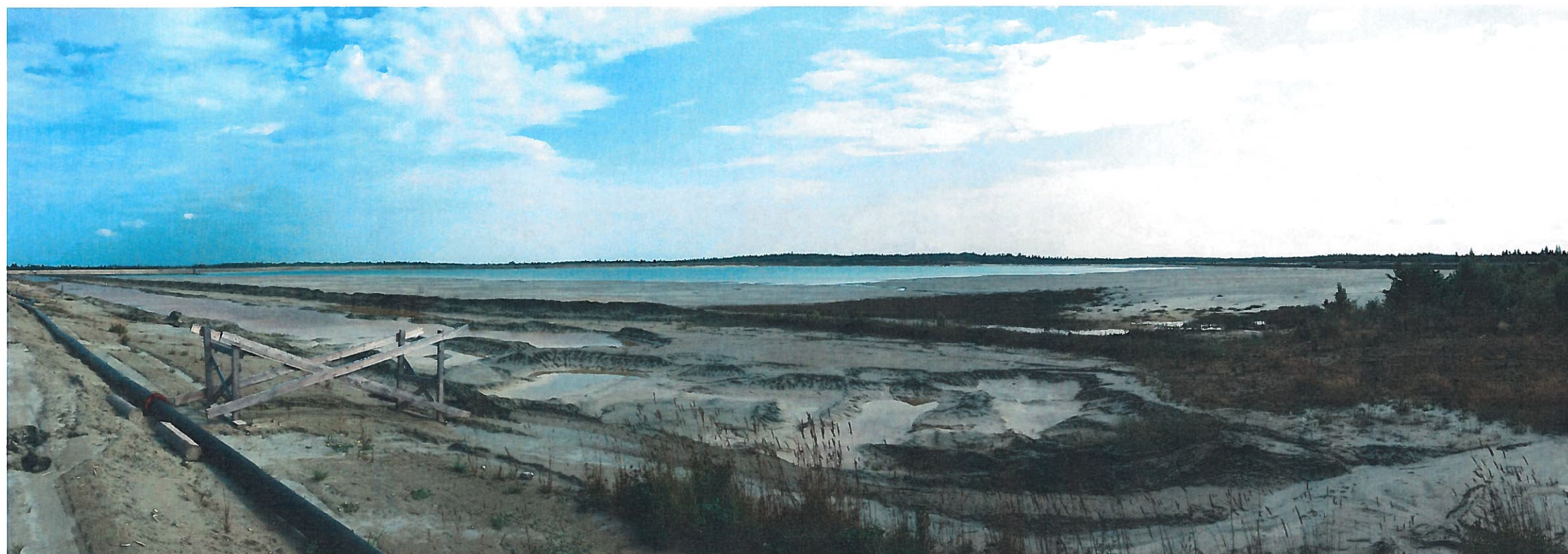
Photo Camflo-2017-08-29-005 : Parc à résidus, bassin 1, regard nord-est.
