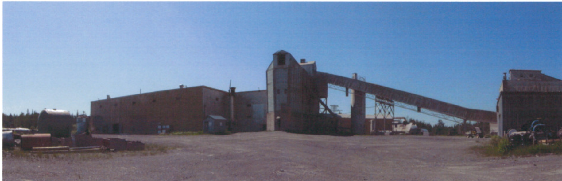
Photo 1 : Usine Camflo. Coordonnées de la photo UTM NAD 83 : 17U : 720579 E / 5337678 N
