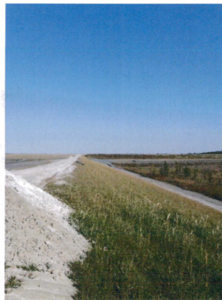
Photo Camflo-2014-09-26-007 : Digue 1-est, profilée et mise en végétation.
