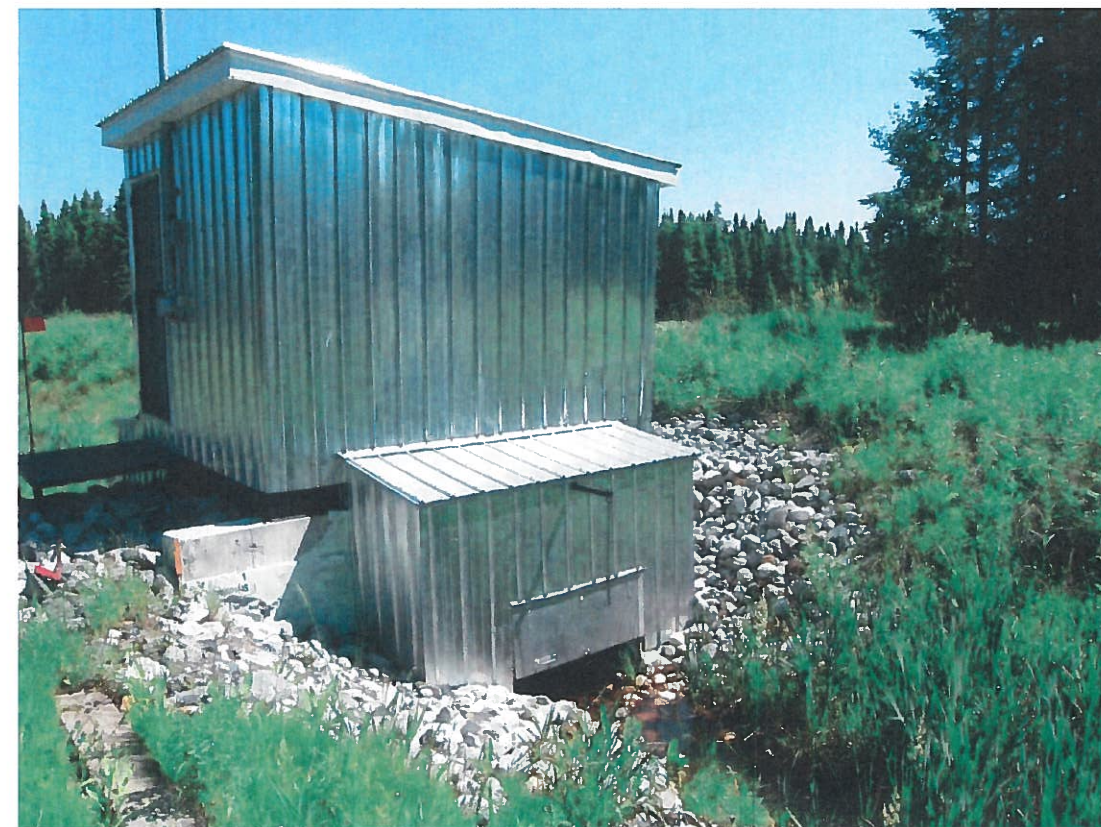
Photo Camflo-2012-06-21-002 : Effluent final, situé à l'extrémité nord-ouest du bassin 1.
