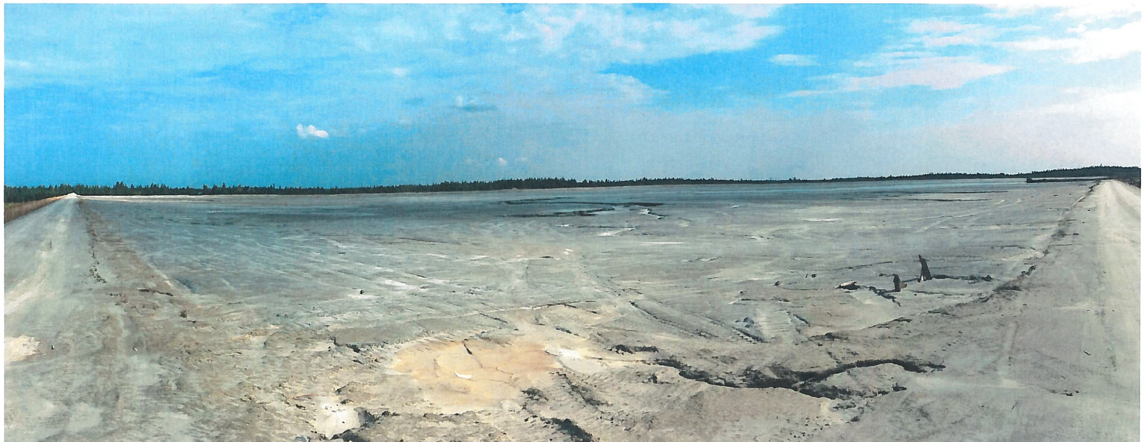
Photo Camflo-2017-08-29-006 : Parc à résidus, bassin 2, regard vers le nord-est.
