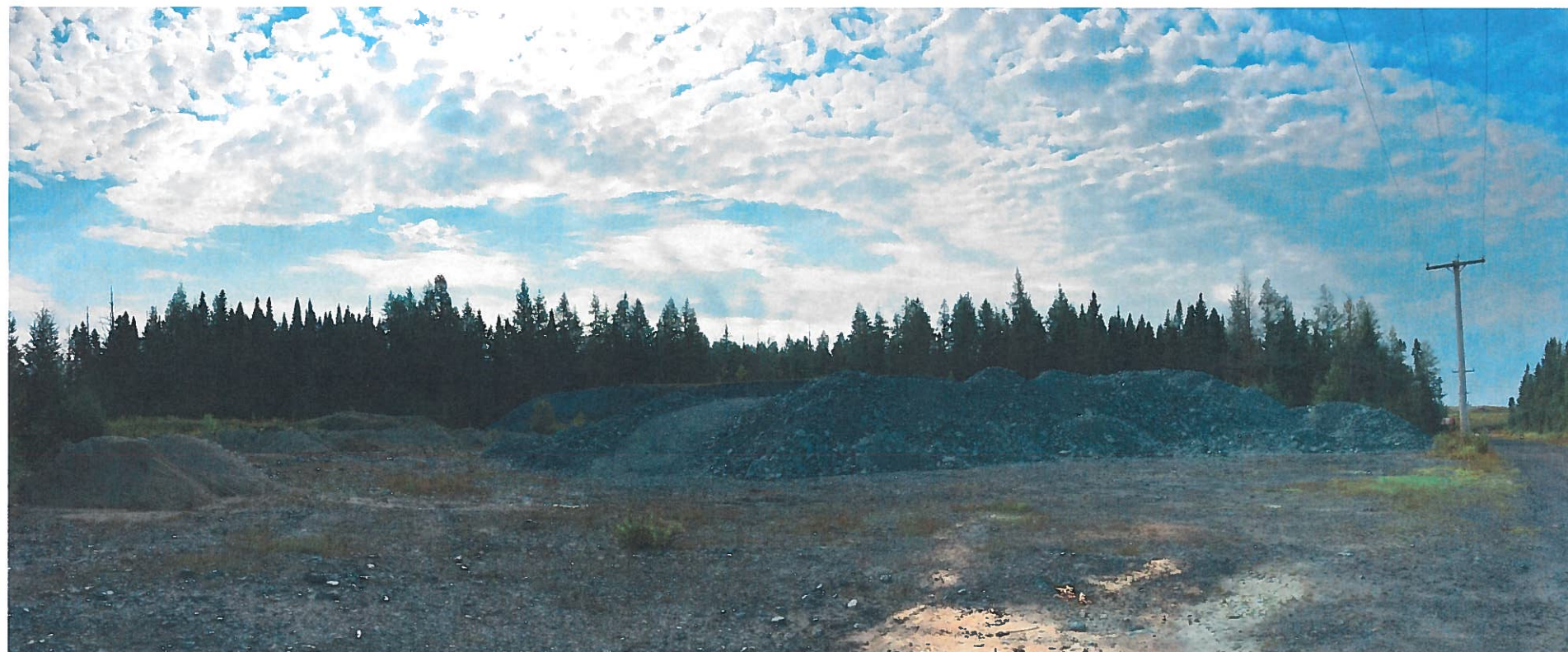
Photo Beaufor-2017-08-29-011 : Stérile de la mine Goldex entreposés pour les travaux de rehaussement au parc à résidus
