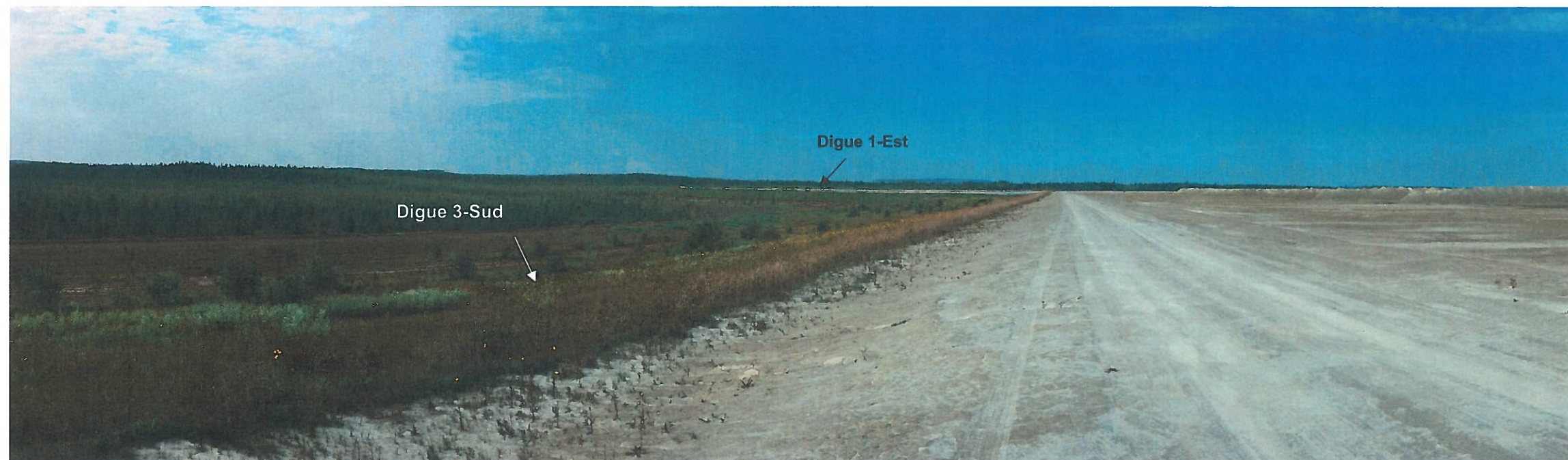
Photo Camflo-2017-08-29-002 : Vue de la végétation sur les digues 3-sud et 1-est
