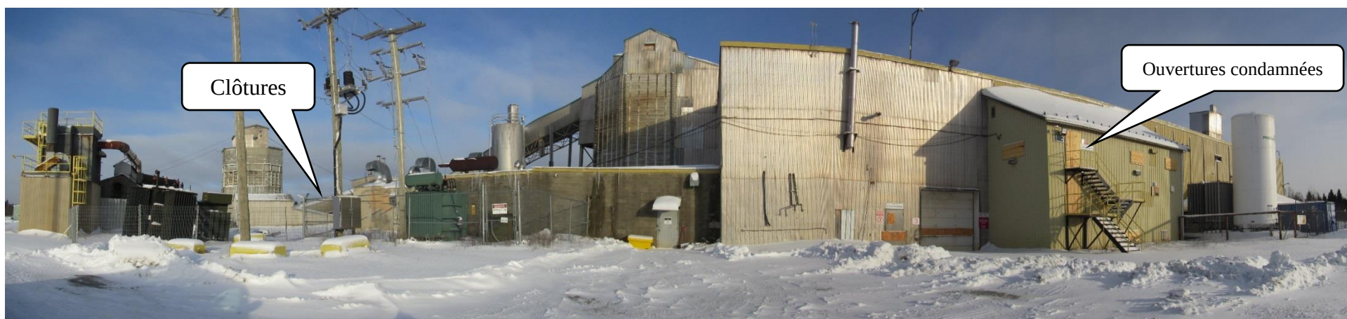
2021-12-03_CAM_004: Vue d'ensemble de l'usine de traitement du minerai
