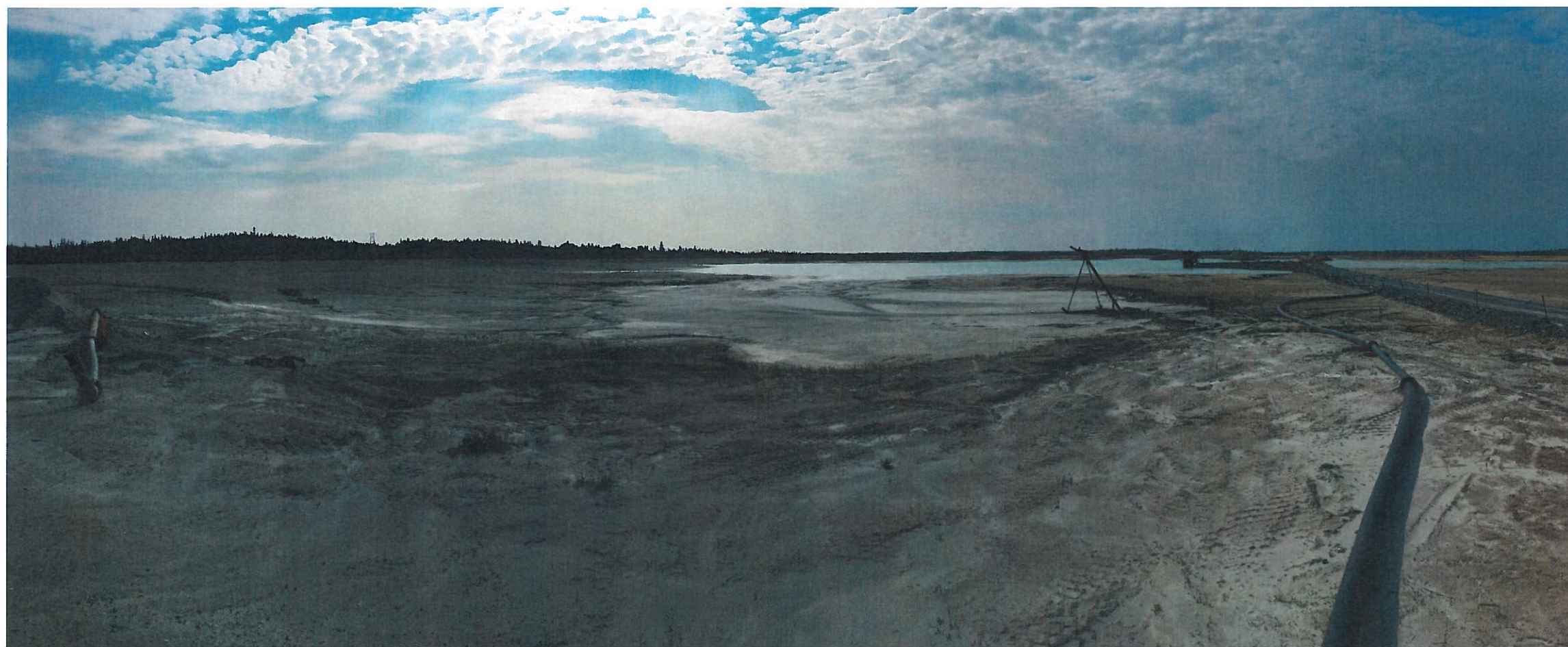
Photo Camflo-2017-08-29-001 : Parc à résidus, bassin 3. Ce bassin a atteint sa pleine capacité. Regard vers le sud
