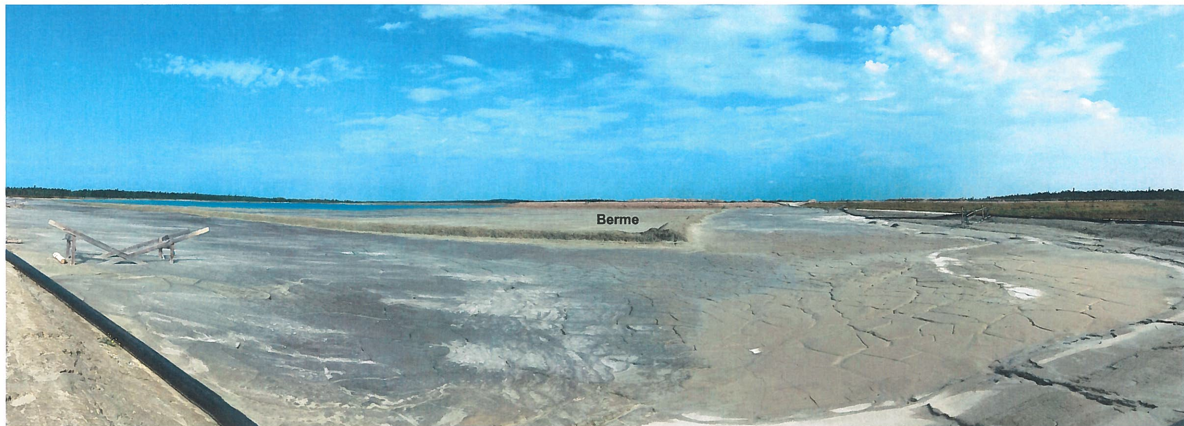
Photo Camflo-2017-08-29-004 : Parc à résidus, bassin 1, regard nord-ouest. Site de déposition pour permettre le rehaussement de la digue. La berme délimite jusqu'où il faut remplir.
