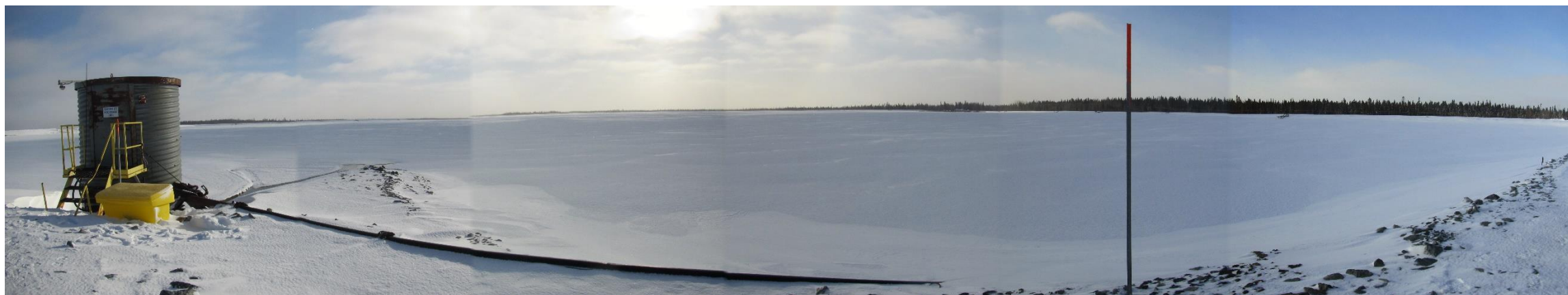
2021-12-03_CAM_015 : Bassin 1 du parc à résidus et station de pompage
