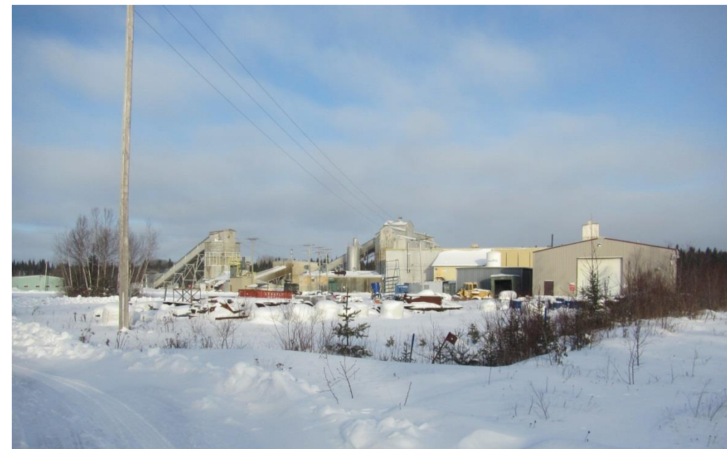
2021-12-03_CAM_007 : Vue d'ensemble de l'usine de traitement et du garage
