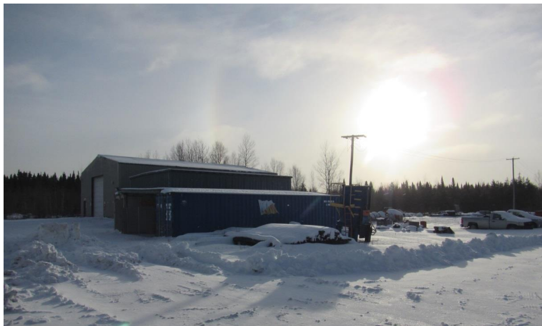
2021-12-03_CAM_005 : Garage et entrepôt de l'usine
