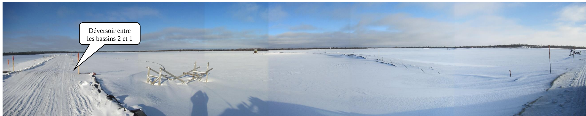
2021-12-03_CAM_017 : Bassin 2 du parc à résidus et station de pompage
