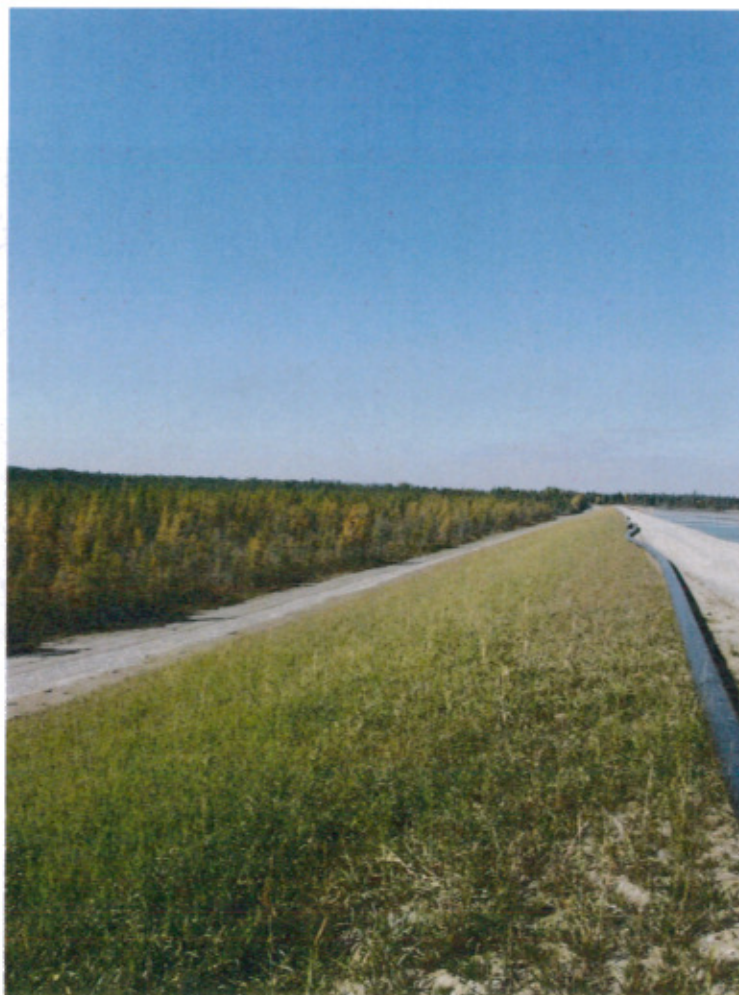
Photo Camflo-2014-09-26-006 : Digue 1-sud, profilée et mise en végétation.
