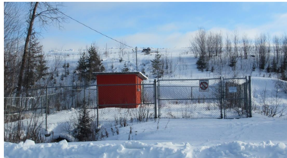
2021-12-03_CAM_021 : Cabanon de l'effluent final EF-BI (Bassin 1)
