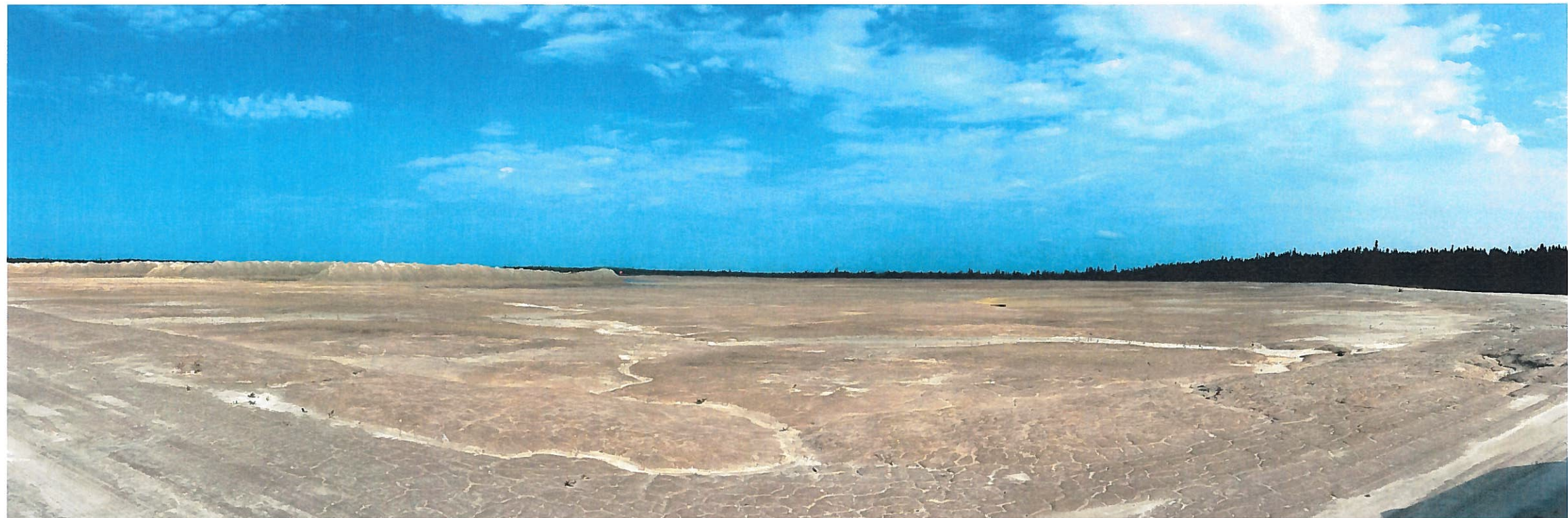
Photo Camflo-2017-08-29-003 : Parc à résidus, bassin 3. Des bancs d'emprunts de résidus ont été préparés pour des travaux de rehaussement si des résidus secs sont nécessaires.
