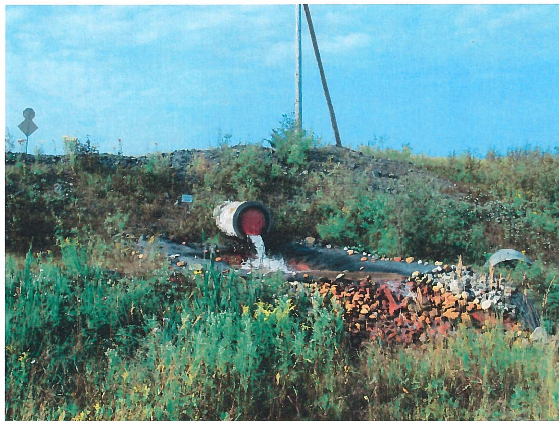
Photo Camflo-2017-08-29-010 : Capteur nord pour le ruissellement de surface
