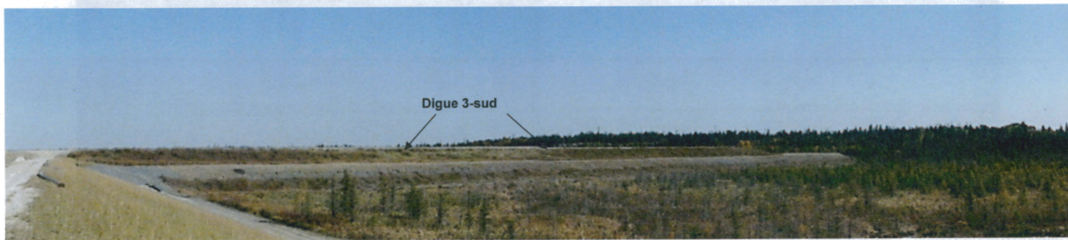
Photo Camflo-2014-09-26-005 : Digue 3-sud, profilée et mise en végétation.
