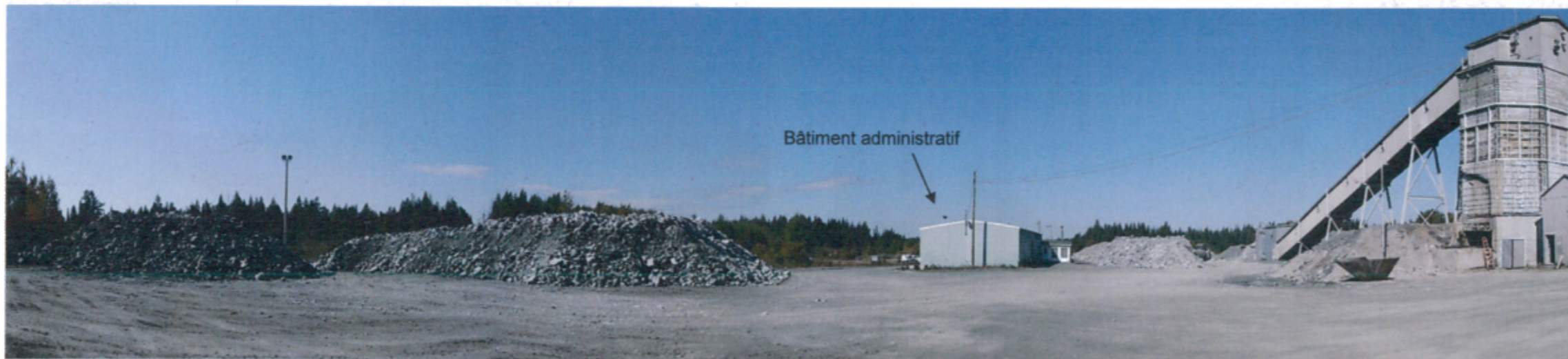
Photo Camflo-2014-09-26-013 : Halde à minerais du site Monique et bâtiment administratif.
