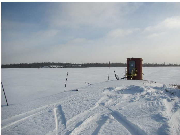
2021-12-03_CAM_012 : Station de pompage du bassin 3 du parc à résidus
