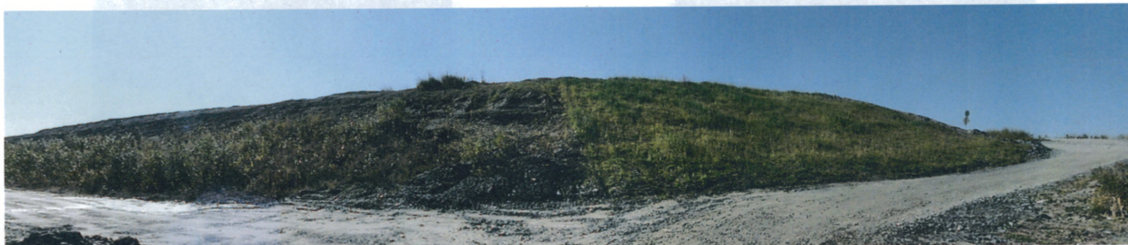
Photo Camflo-2014-09-26-008 : Travaux de mise en végétation sur la digue 3-nord.
