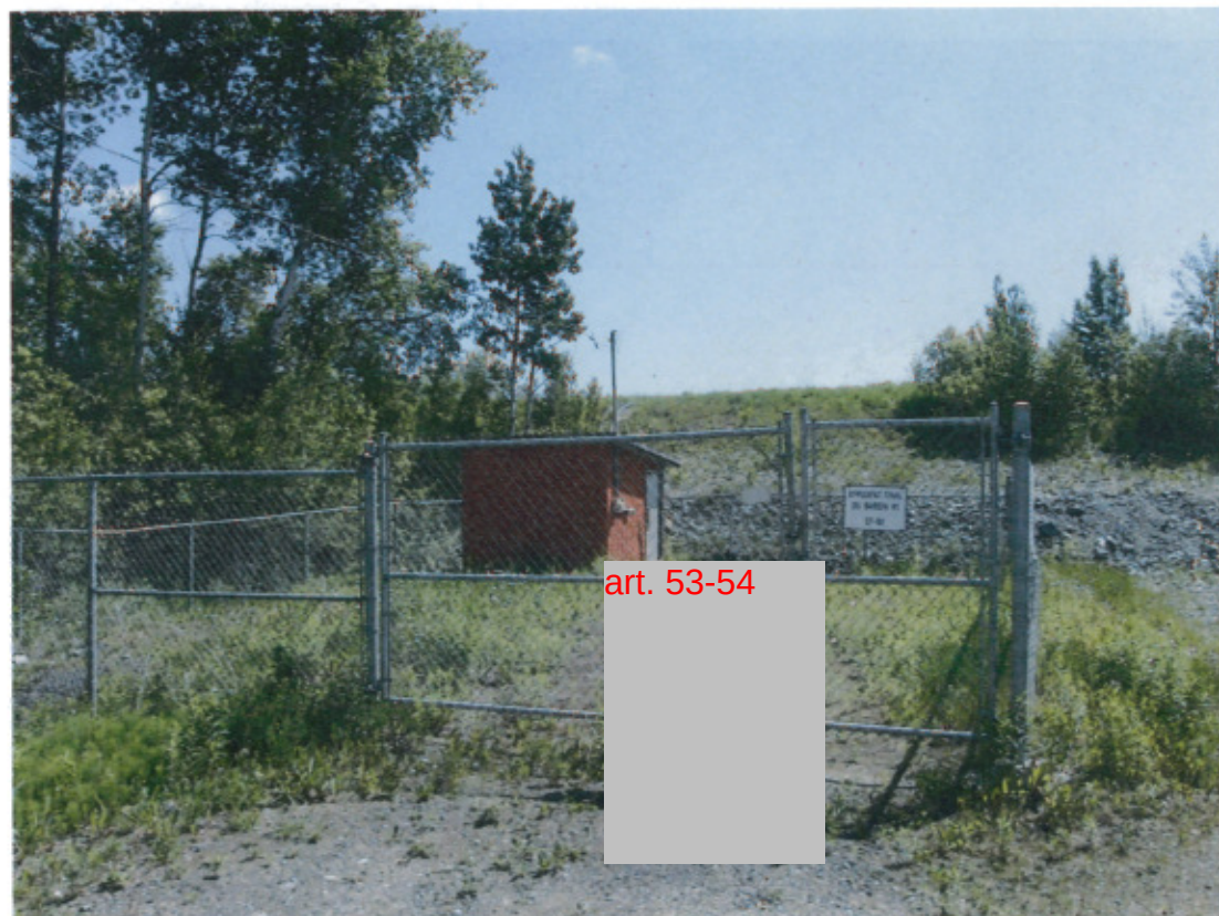
Photo Camflo-2012-06-21-001 : Effluent provincial, situé à la sortie du bassin no 1 et reconnu par le MDDELCC.
