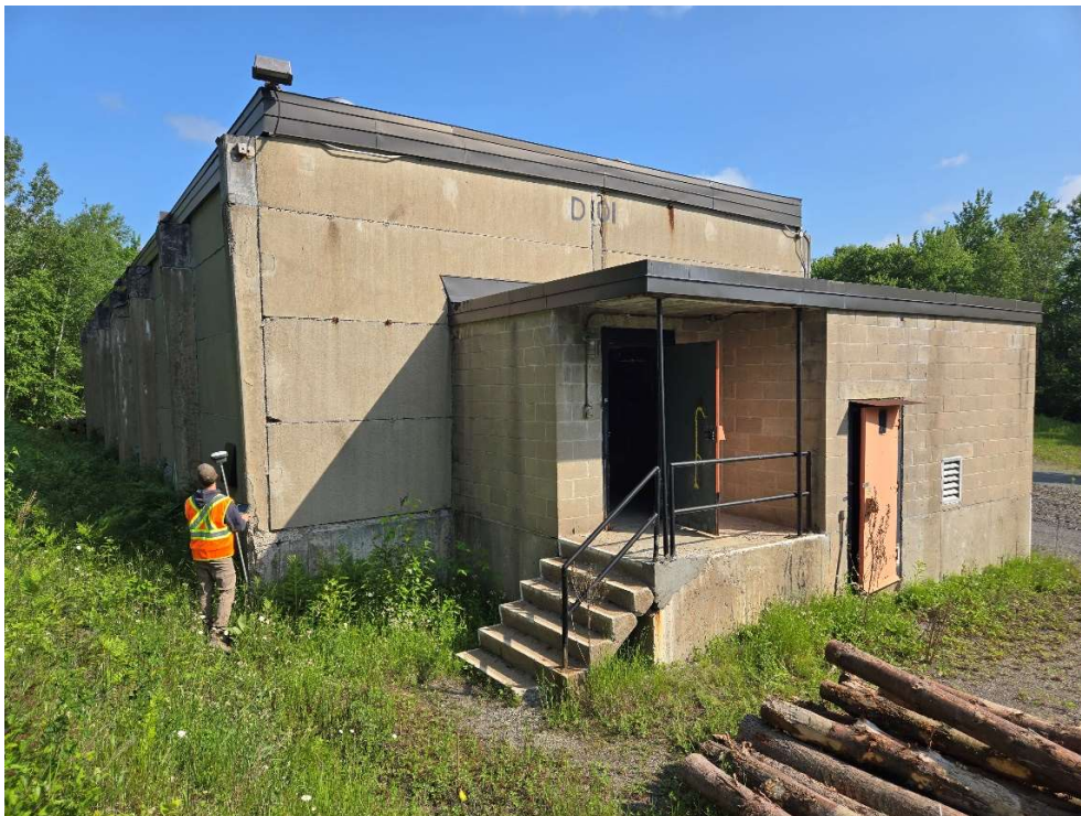
Bâtiment type localisé sur les lieux
