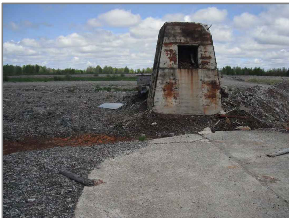
Photo 28 : Structures supportant les chargeuses fixes à l'entrée de l'usine (direction Nord)
