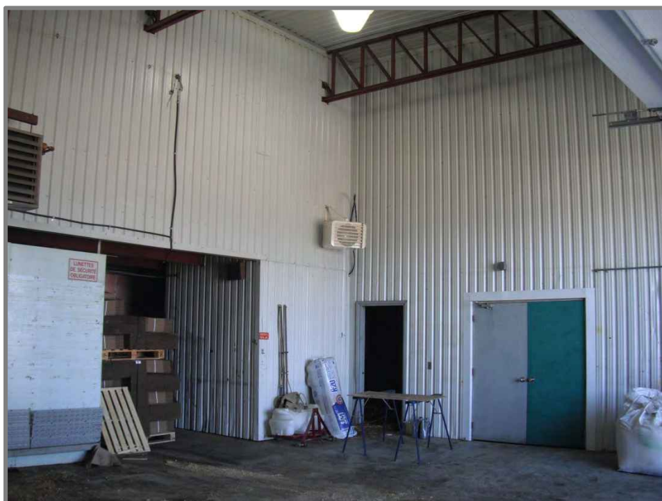
Photo 16 : Intérieur de l'entrepôt
