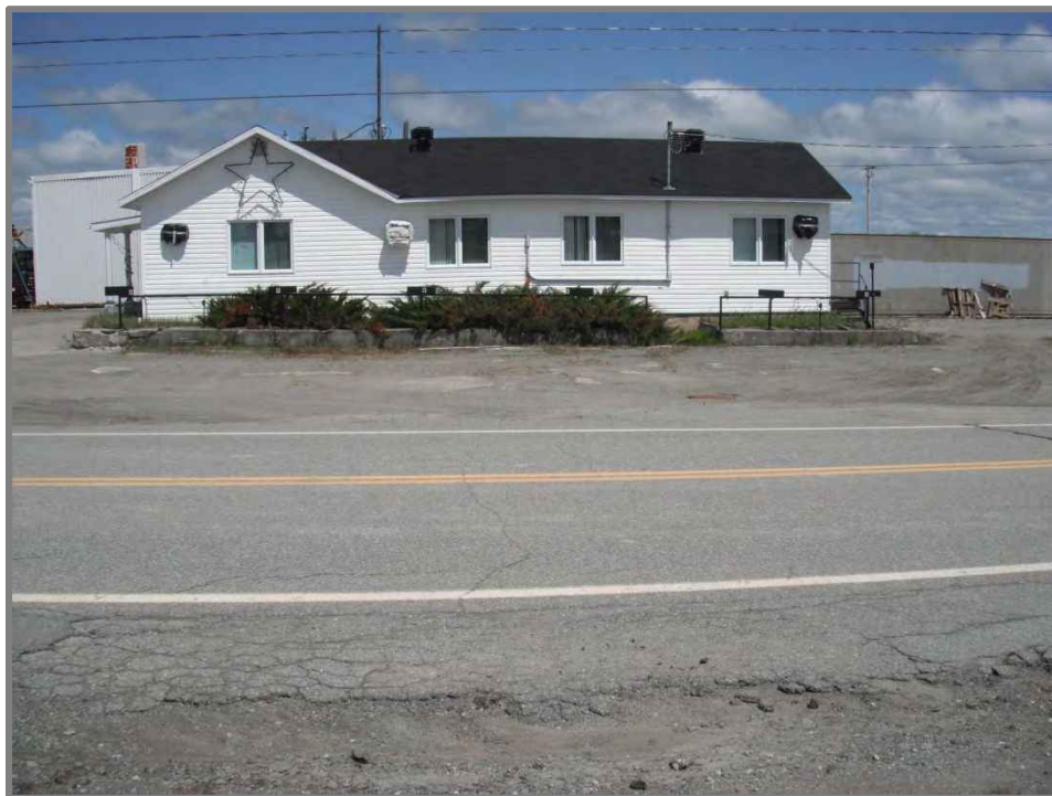
Photo 19 : Côté Sud du bâtiment administratif (direction Nord)
