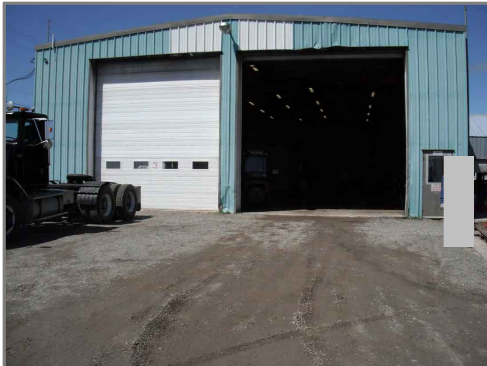
Photo 3 : Côté Est du garage (direction Ouest)
