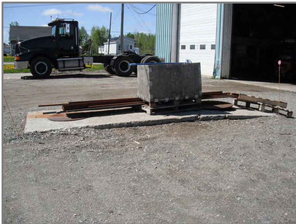
Photo 7 : Séparateur eau/huile du garage (direction sud)
