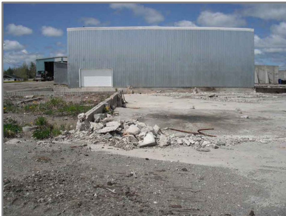
Photo 13 : Côté Est de l'entrepôt et dalle de béton de l'usine de sciage (direction Ouest)
