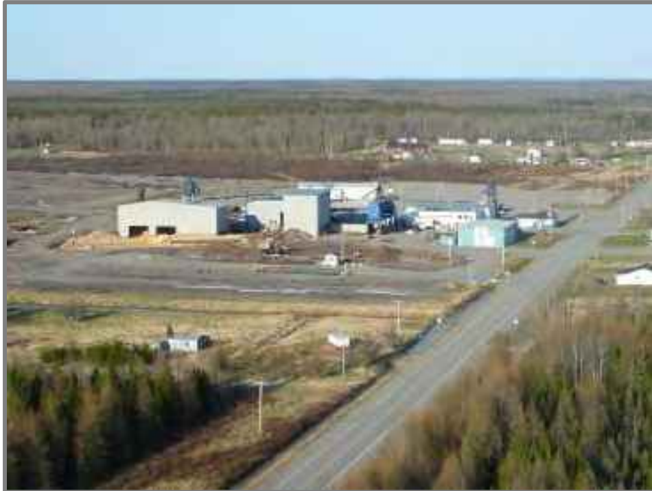
Photo 1 : Vue générale de la scierie avant sa fermeture, photo provenant du site internet de la municipalité de Champneuf (direction Est)
