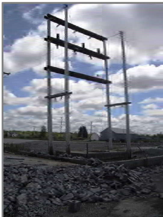
Photo 25 : Ancien poste électrique de l'usine (direction Sud-Est)
