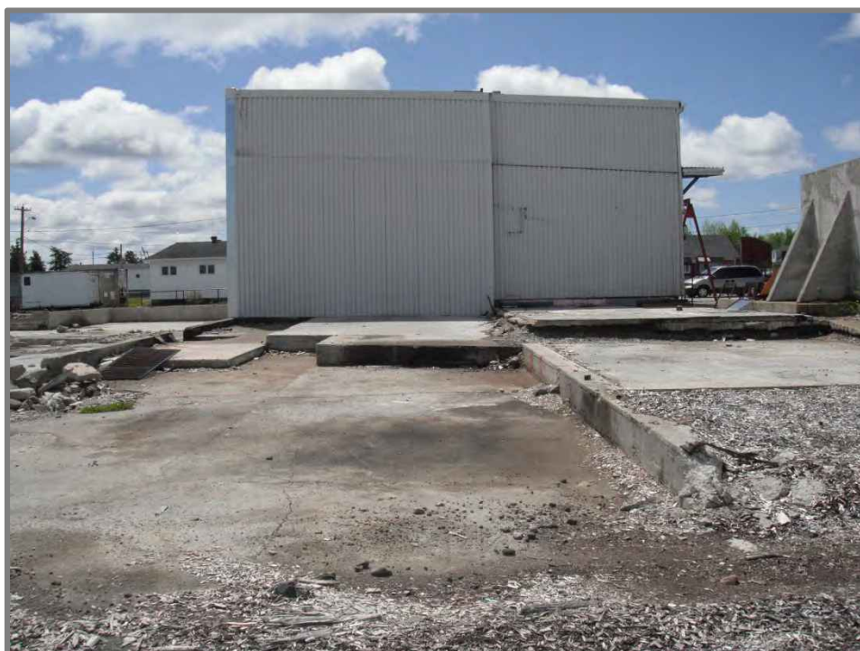
Photo 14 : Côté Nord de l'entrepôt et dalle de béton de l'usine de sciage (direction Sud)
