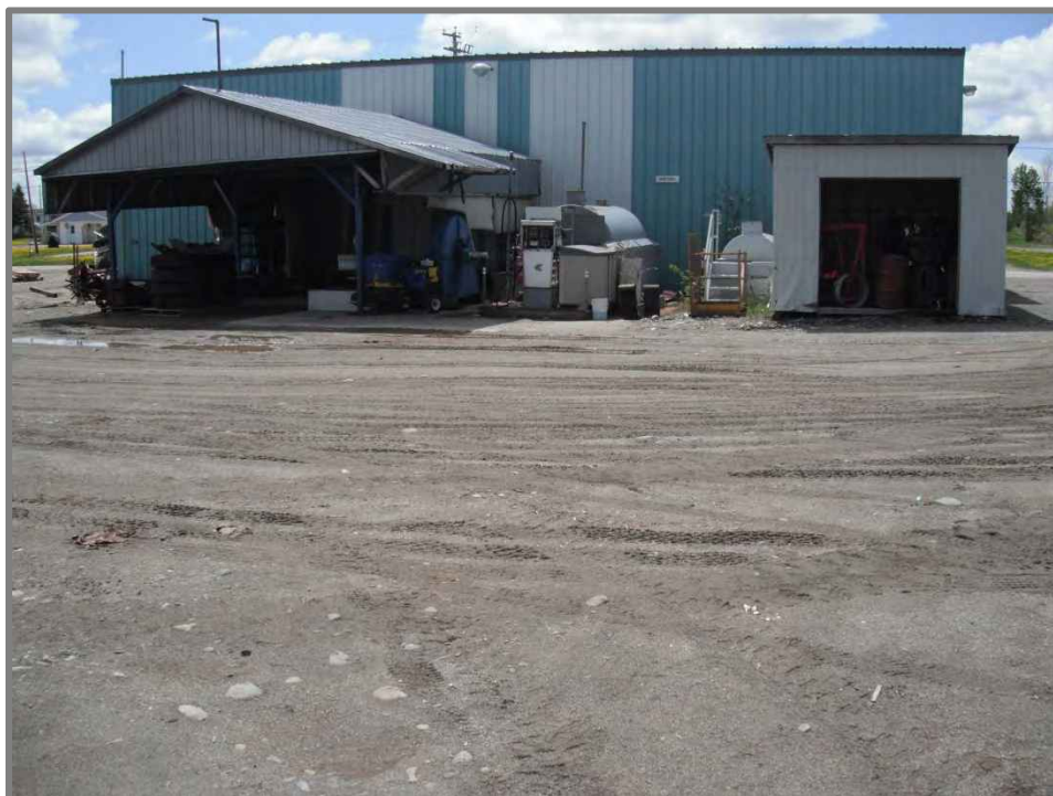
Photo 6 : Côté Nord du garage avec réservoirs hors-sols de diesel et d'huile usée (direction sud)
