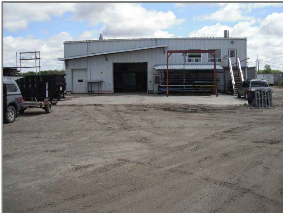
Photo 11 : Côté Ouest de l'entrepôt (direction Est)
