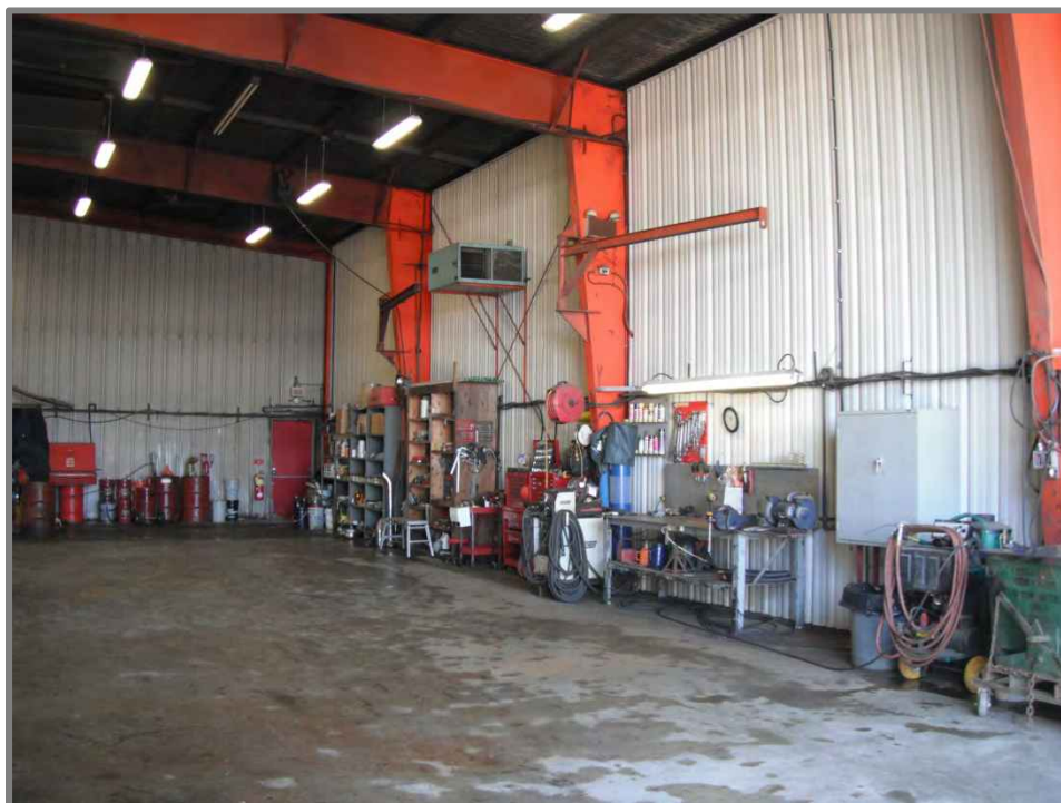
Photo 8 : Intérieur du garage
