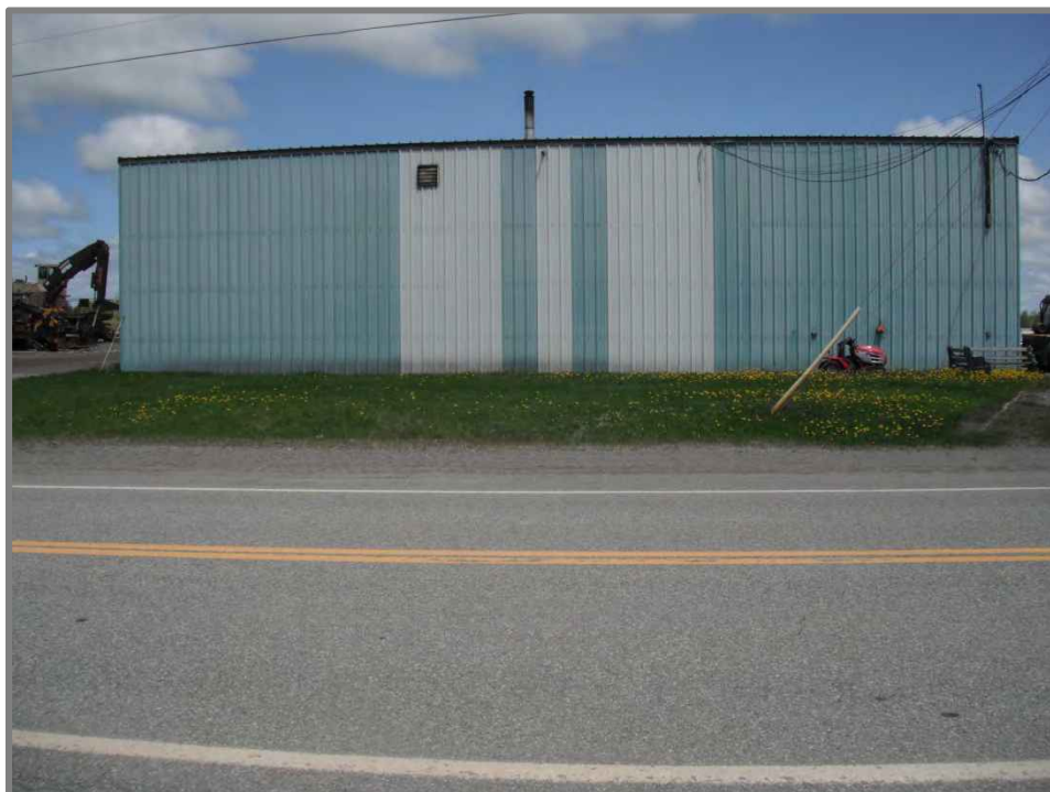
Photo 4 : Côté Sud du garage (direction Nord)
