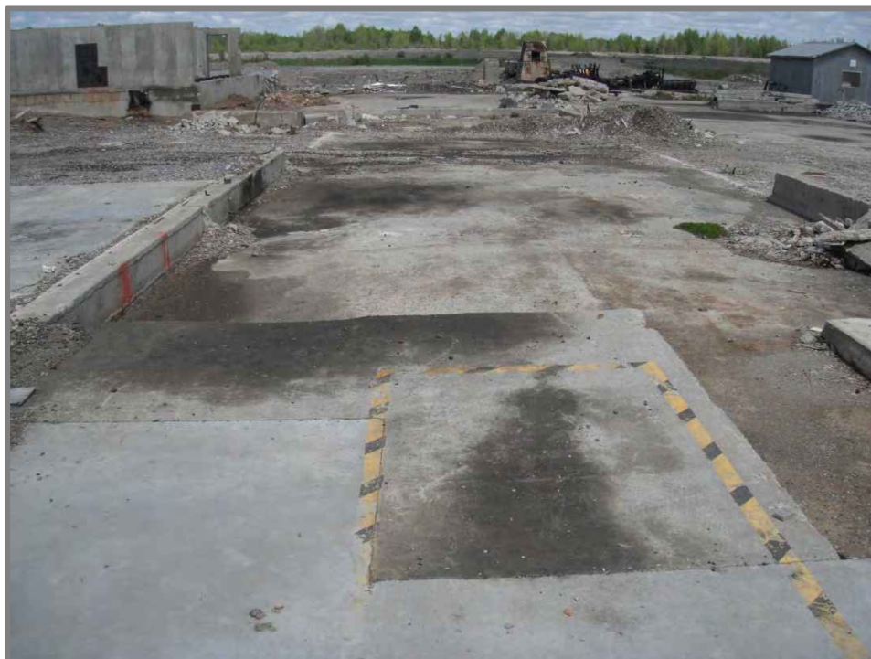
Photo 30 : Structures et dalles de béton de l'usine de sciage (direction Nord)
