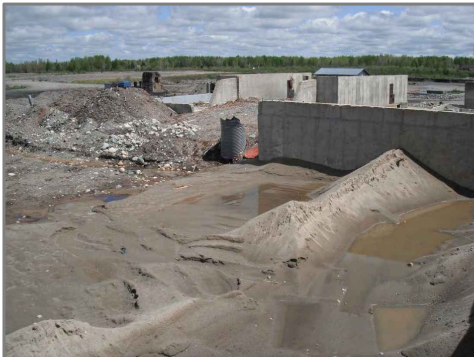
Photo 31 : Structures de béton de la réserve à écorces et de la bouilloire (direction Nord-Est)
