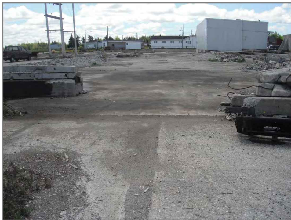
Photo 29 : Structures et dalles de béton de l'usine de sciage (direction Sud)
