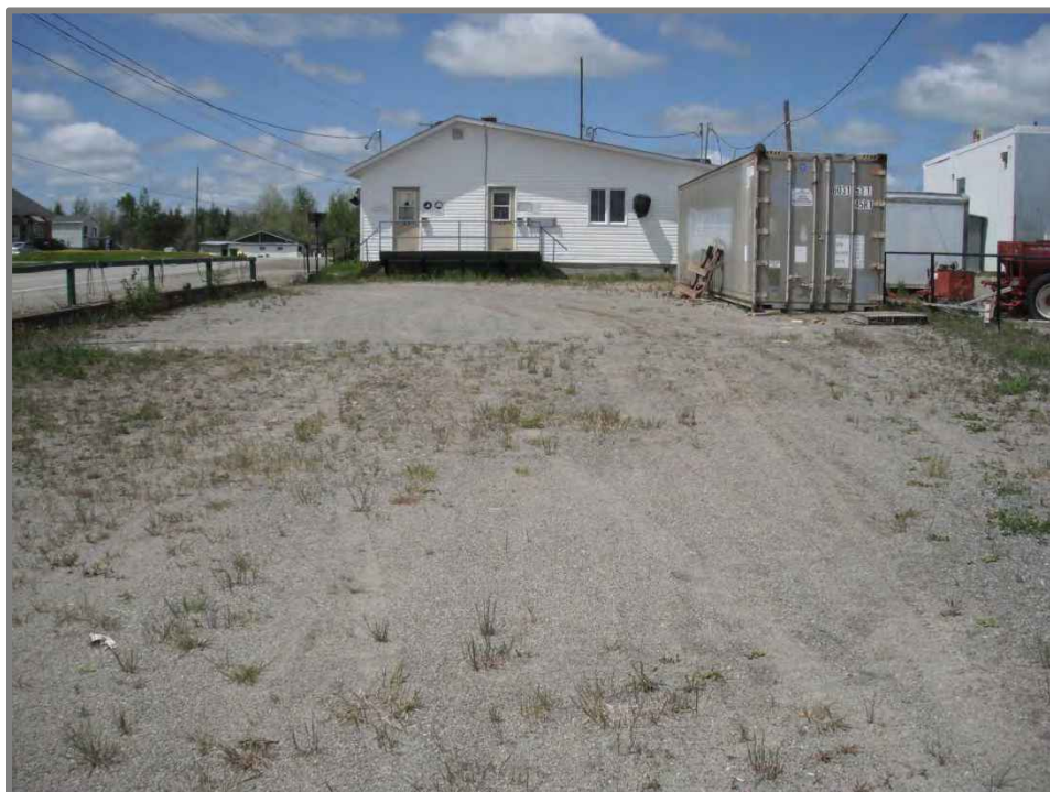
Photo 22 : Côté Est du bâtiment administratif (direction Ouest)
