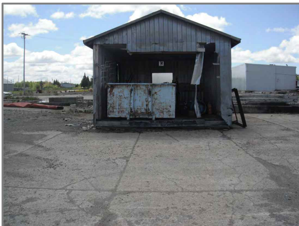
Photo 24 : Entrepôt de matières dangereuses résiduelles (direction Sud)
