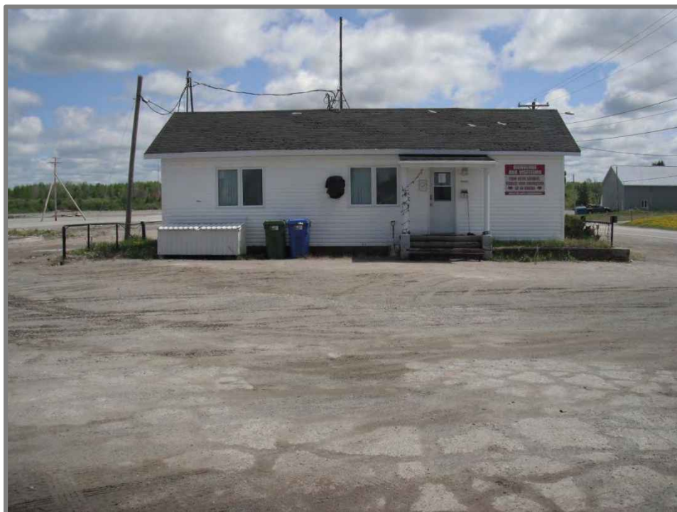
Photo 20 : Côté Ouest du bâtiment administratif (direction Est)
