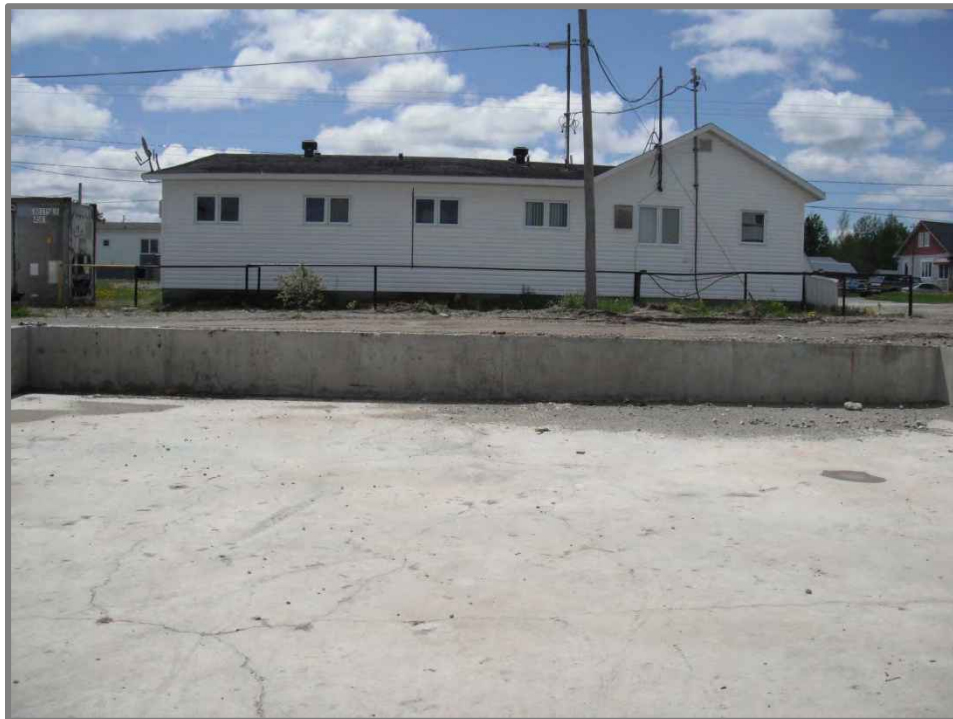
Photo 21 : Côté Nord du bâtiment administratif (direction Sud)
