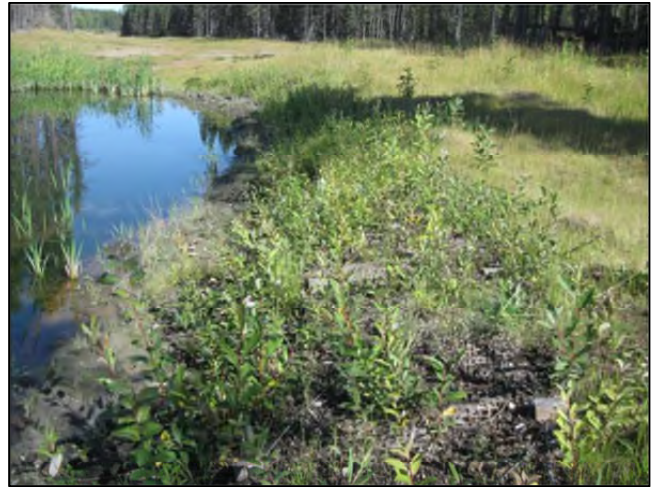
Photo 4 : Reprises de fagots à la base d'un talus érodé (tiré d'Écogénie, 2011)
