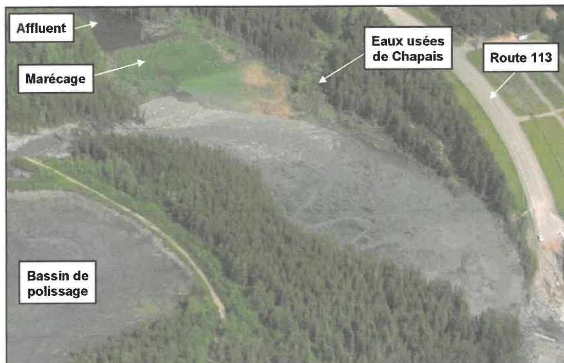
Figure 2-10: Secteur du bassin de sédimentation avant sa construction
