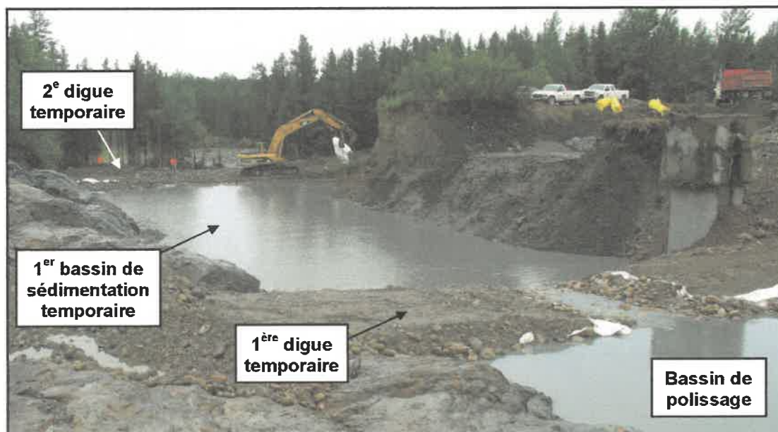
Figure 2-8: Dignes et bassins de sédimentation temporaires
