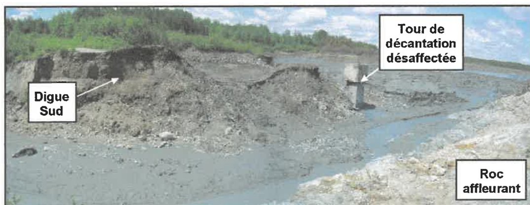
Figure 2-5: Brèche dans la digue Sud
