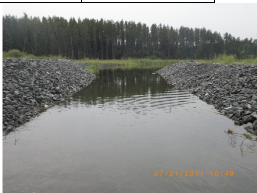
Canal de dérivation, vue vers l'aval
