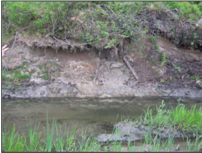
Photo 3 : Reprises de fagots sur matelas de bois (tiré d'Écogénie, 2011)
