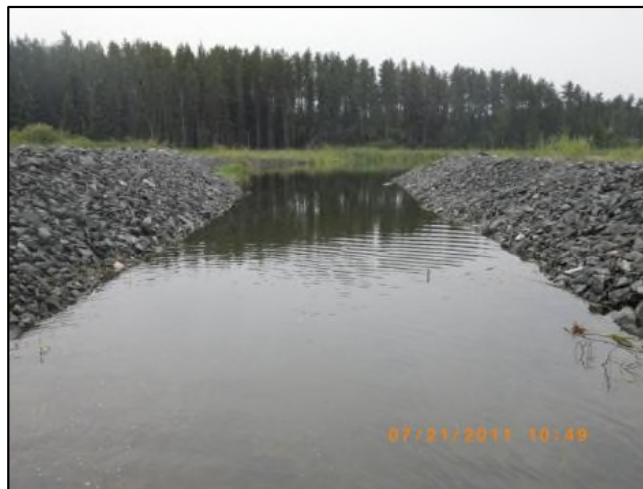
Photo 2 : Canal de sortie du bassin de polissage en 2011
