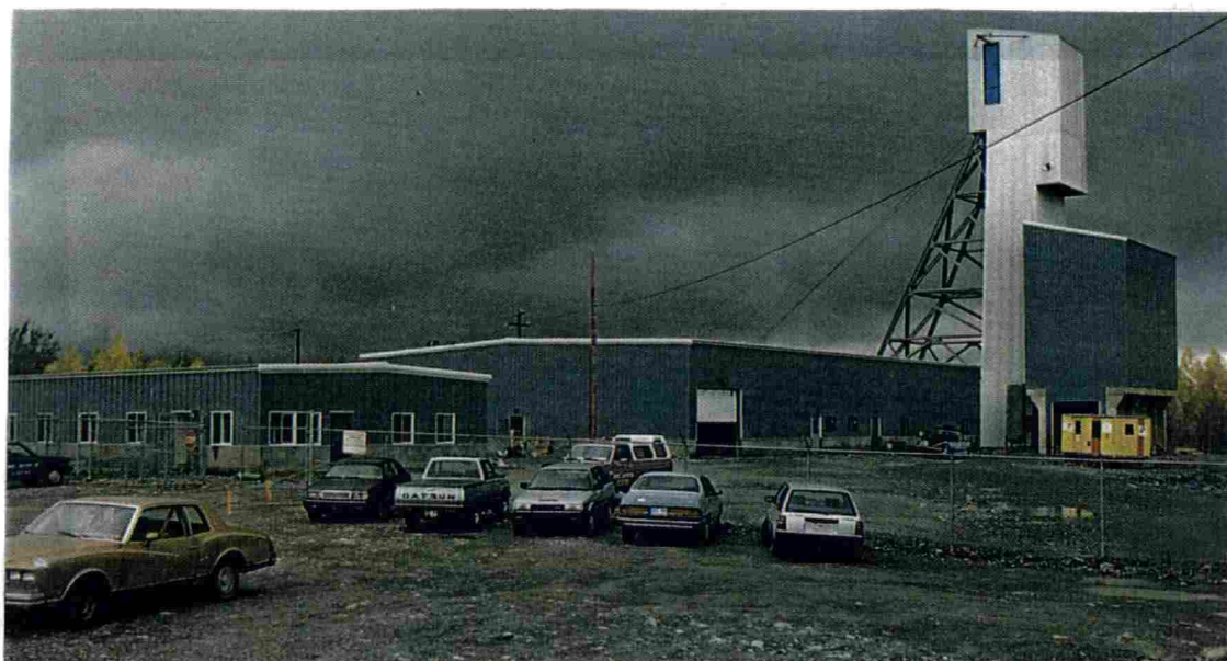
Installations de surface à la mine Elder
