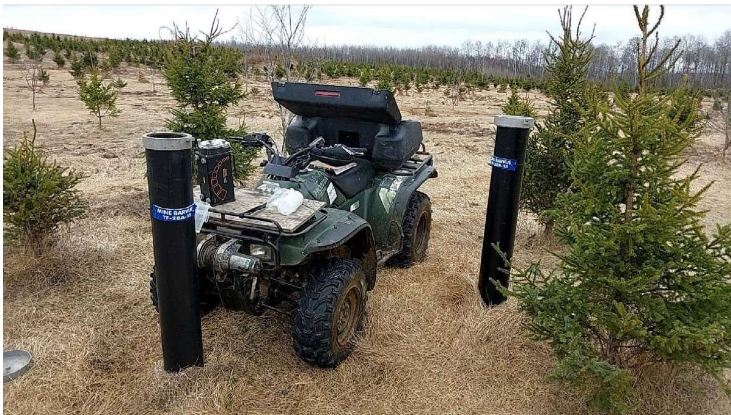
Photo no. 35. Piézomètres TF-28A-15 et TF-28B-15. On observe également le parc à résidus végétalisé par des sapins. Regard vers l'est.
