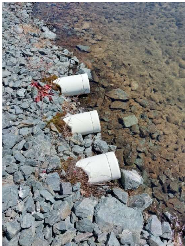
Photo no. 26. Trois tuyaux qui déversent le bassin est.
