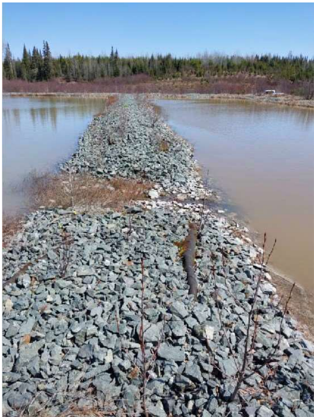
Photo no. 16. Canal de transition entre deux sous-bassins du bassin ouest.
