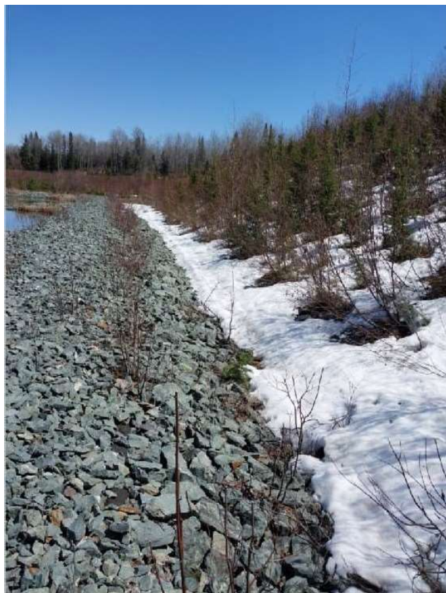
Photo no. 24. Section sud du bassin est. Regard vers l'est.
