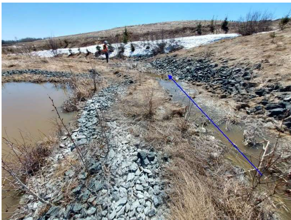
Photo no. 7. Canal sud du bassin ouest, regard vers l'est.
