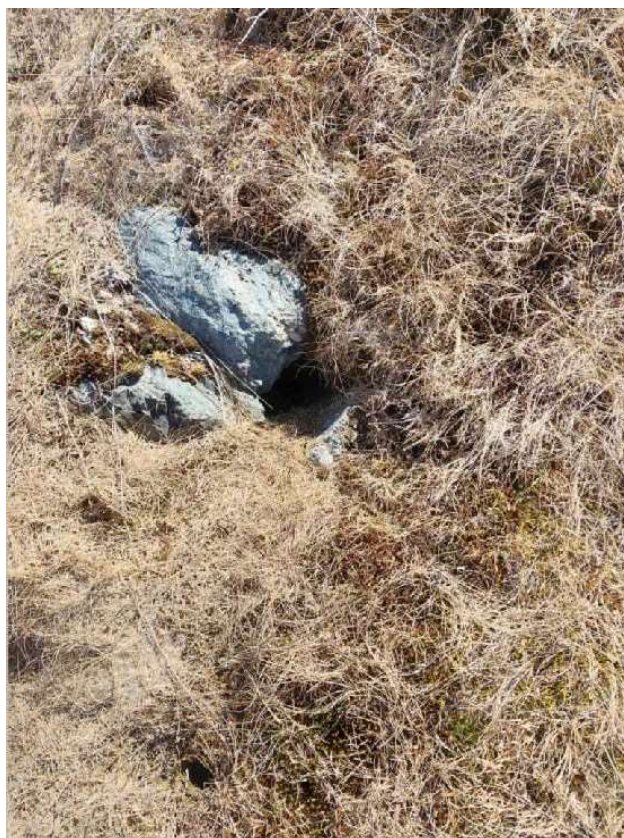
Photo no. 31. Terrier sur la digue nord, coordonnées de la photo UTM Nad 83 18U 303406 E 5378536 N.
