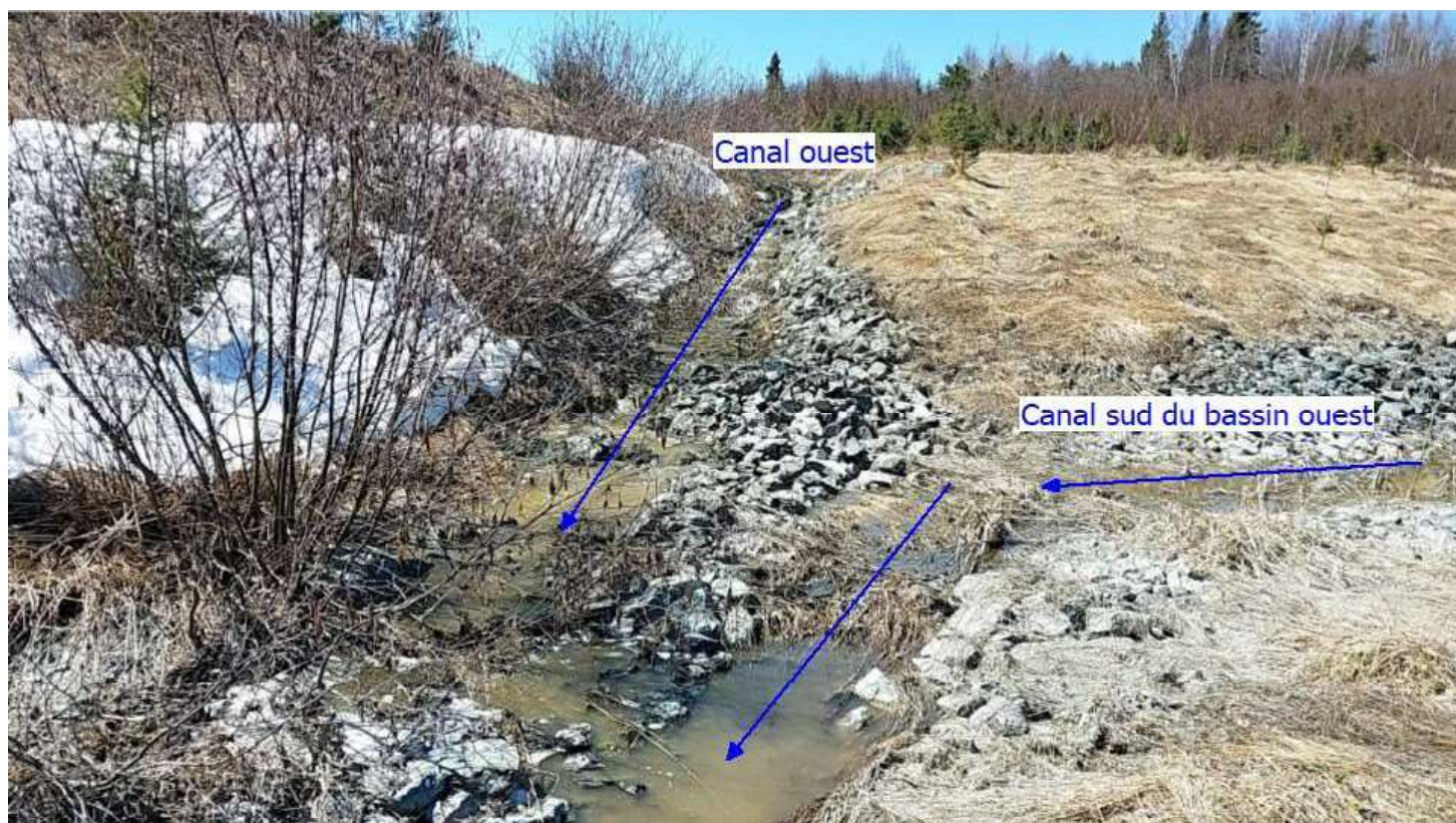
Photo no. 6. Zone de transition entre le canal ouest et le canal nord du bassin ouest. Coordonnée de la photo UTM Nad83 18U 303252 E 5378573 N. Regard vers le sud-ouest.
