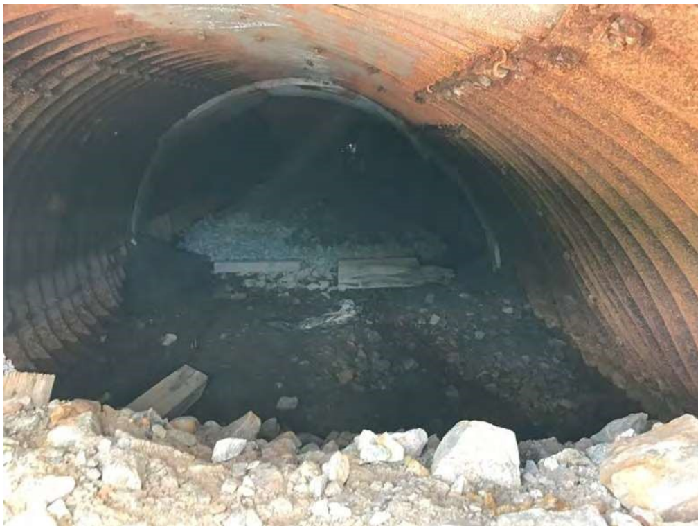
Photo 4 : Intérieur du TTOG (tuyau de tôle ondulée galvanisée)
