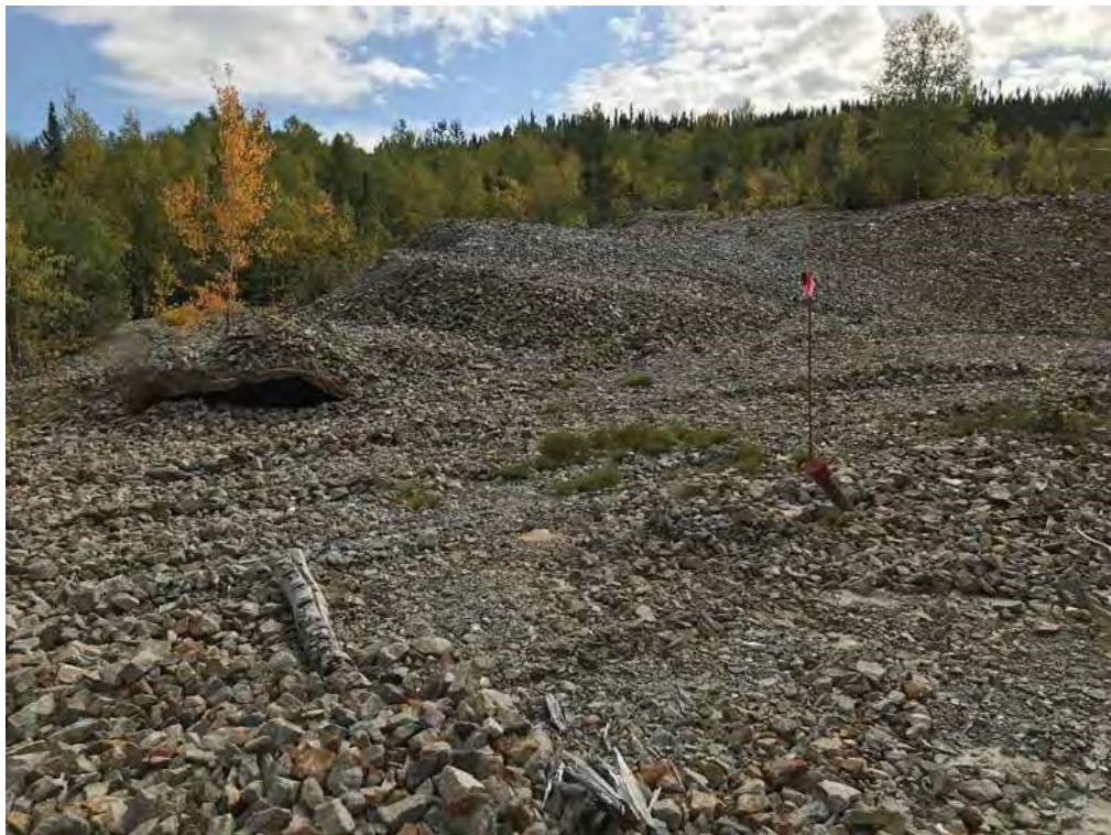
Photo 2 : Piézomètre et TTOG (tuyau de tôle ondulée galvanisée) présent dans la halde à stériles nivelée au niveau du sol
