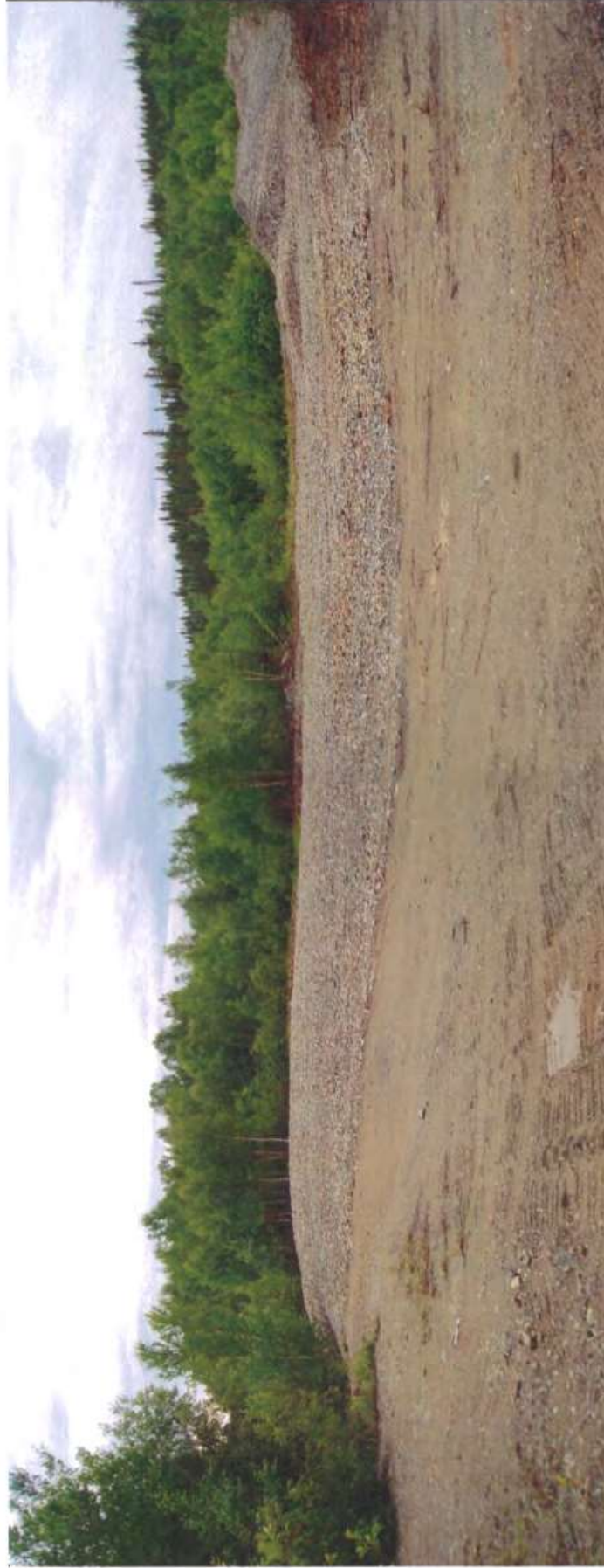
Site des infrastructures nettoyées des matériaux ferreux et dubois. Les fondations ont été arasées et recouvertes de matériaux meubles.
