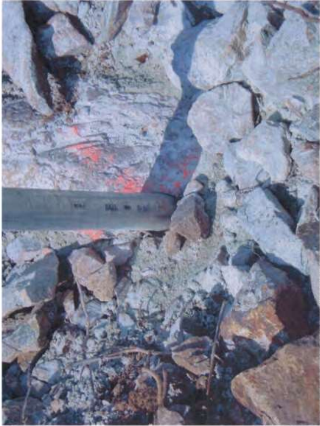
Photographie CER_2011-07-14-004 Les poteaux sont fixés dans le roc.
