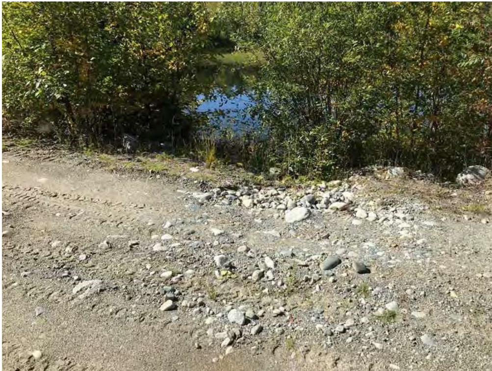
Photo 17 : Érosion du chemin d'accès au parc à résidus, à l'est du bassin de décantation, observée il y a quelques années : aucune évolution observée
