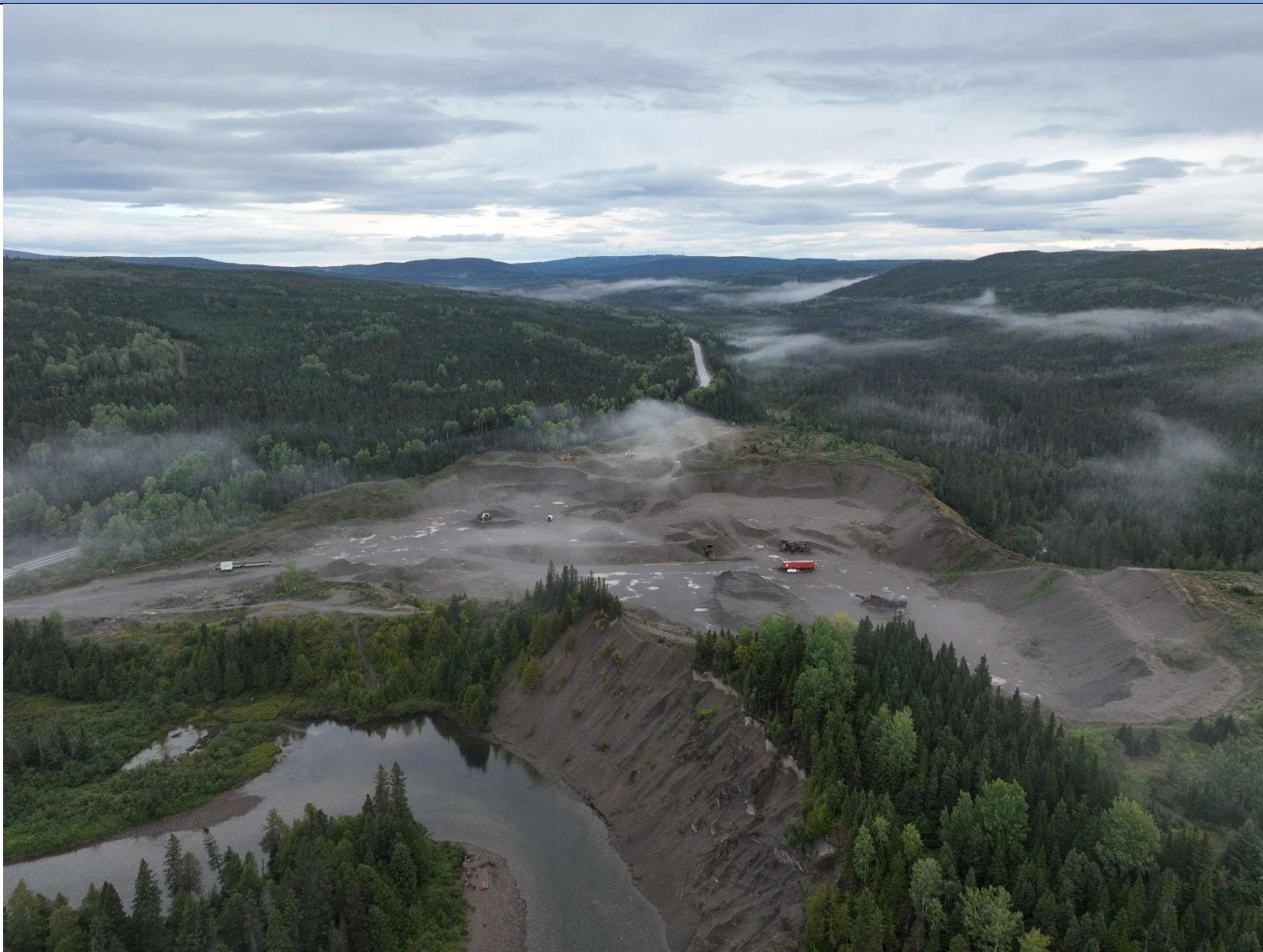
Photo n°3 : Vue générale du site
