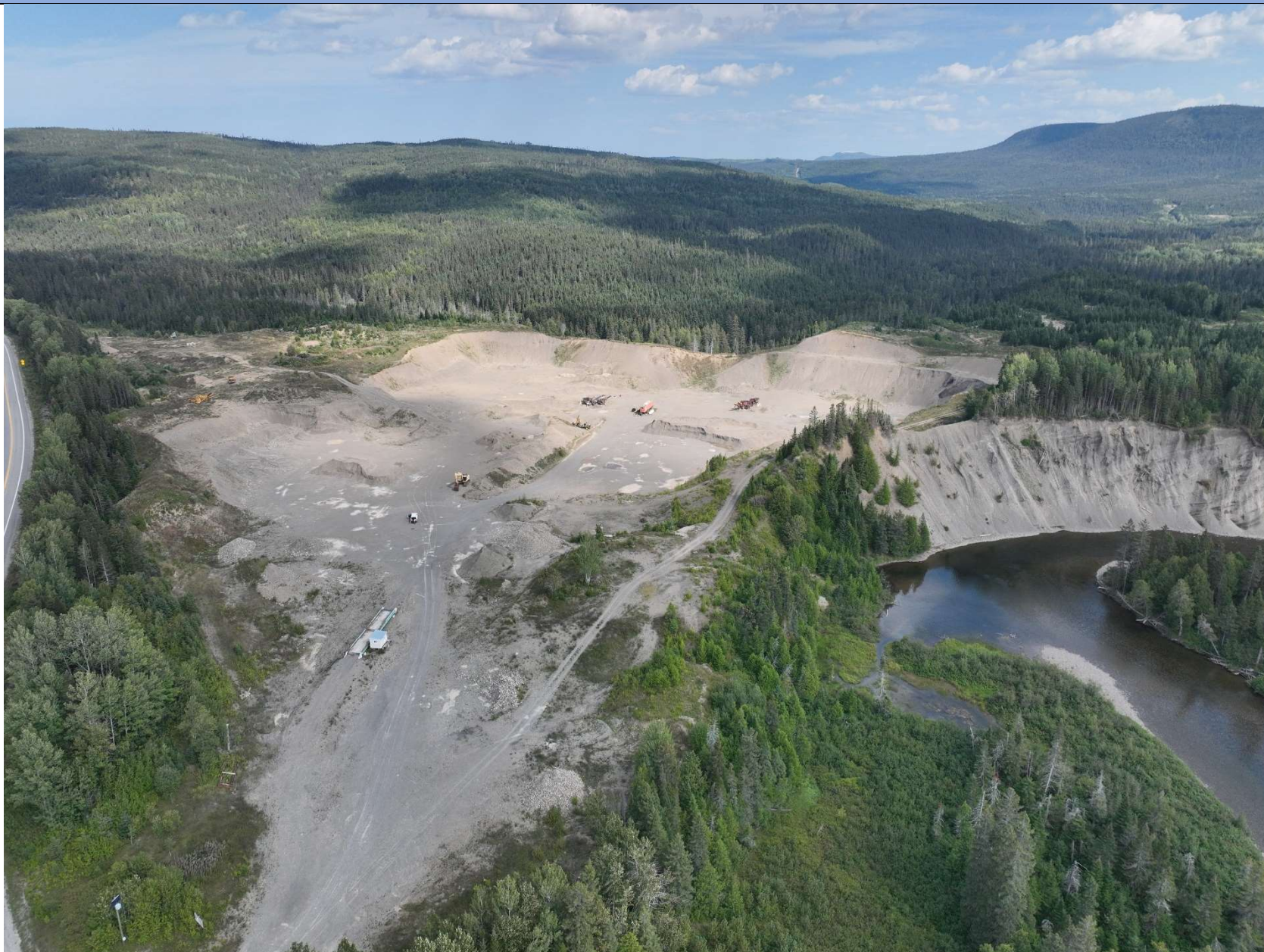
Photo n°1 : Vue générale du site
