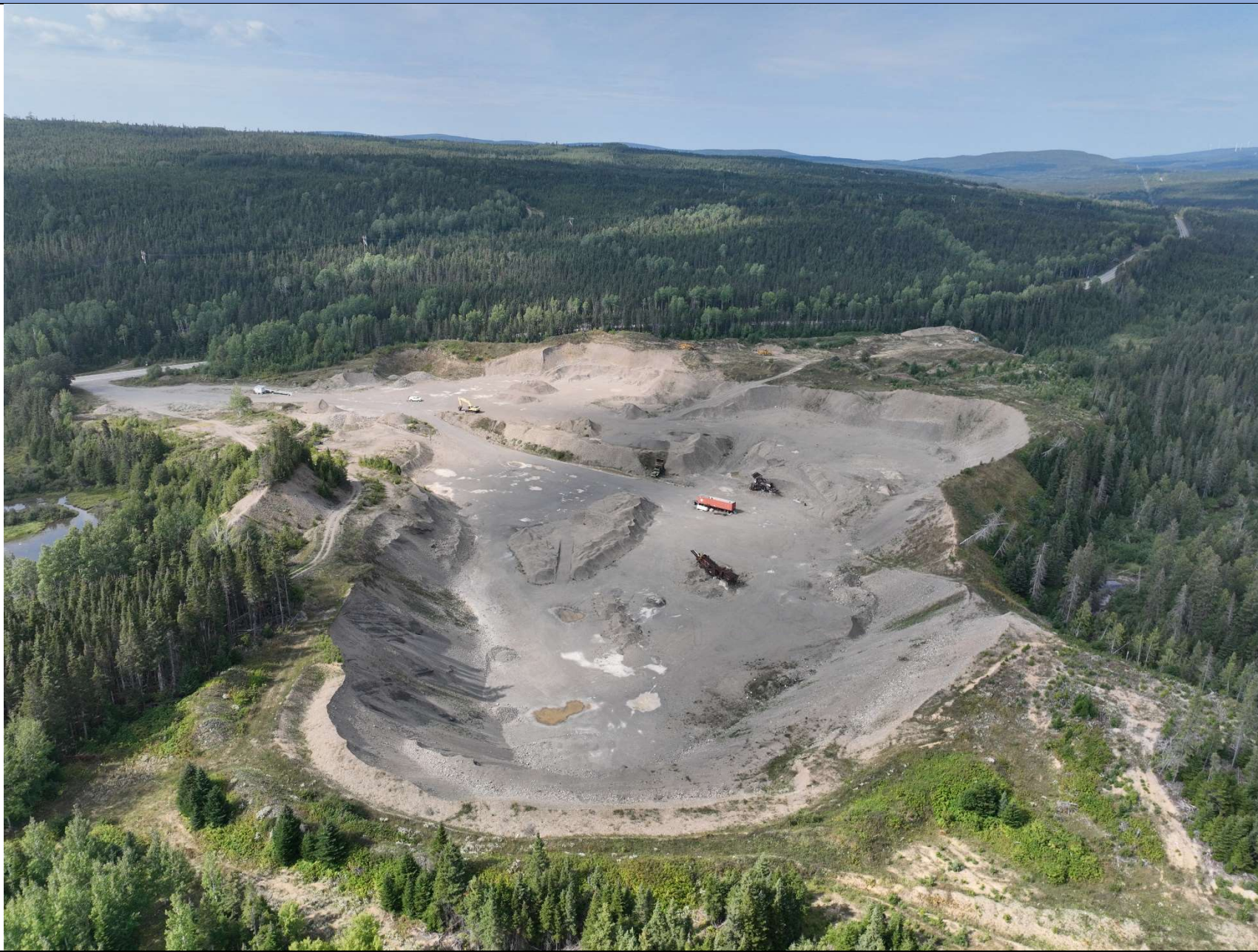
Photo n°3 : Vue générale du site
