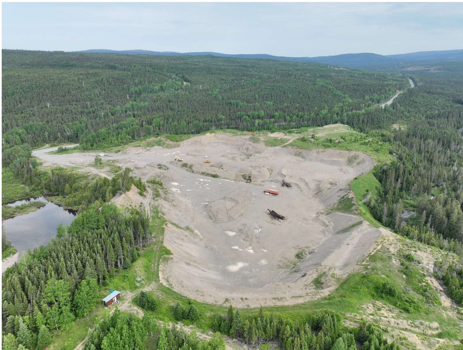
Photo n°3 : Vue générale du site
