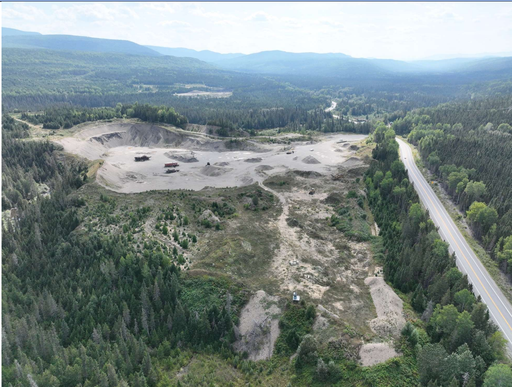
Photo n°4 : Vue générale du site
