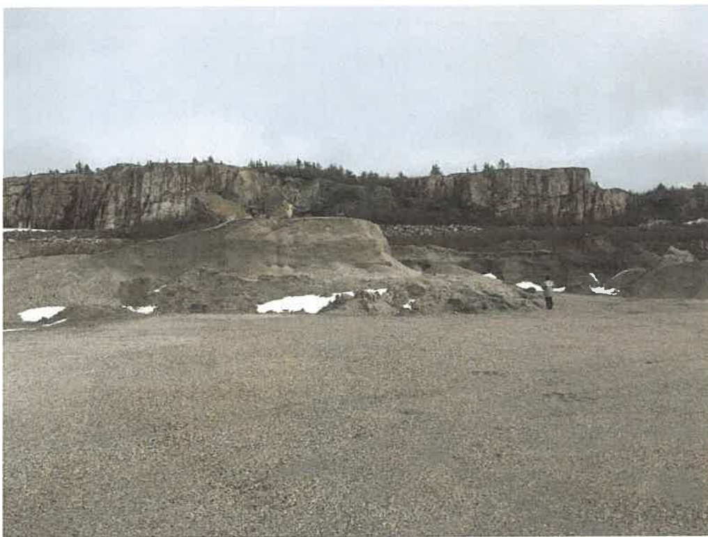
Photo n° 4 : Vue générale de la pile 000.
