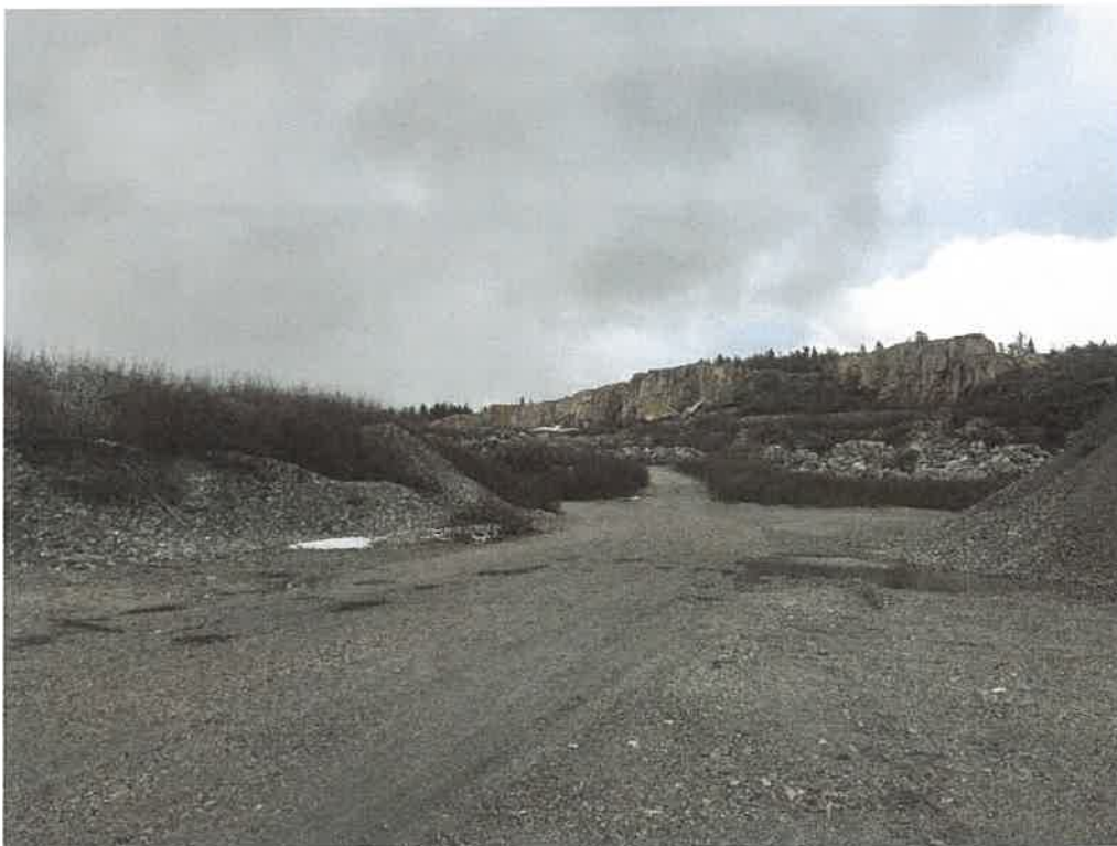
Photo n° 8 : Vue du chemin permettant de circuler à l'intérieur de la carrière SOC-1.
