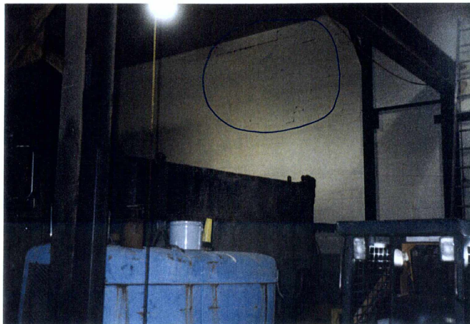
L'ouverture pour les câbles à été obturée
