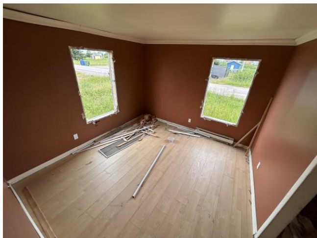
Photographie 31 : 5356916-mur2 (angle fenêtre)
