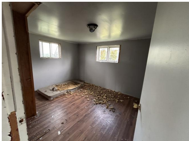
Photographie 21 : 5356949-mur2 (mur en entrant à droite)
