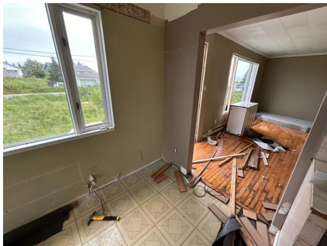
Photographie 2 : 5356913-mur2 (sous la fenêtre)
