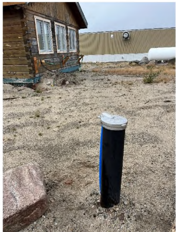
Puits d'eau potable
