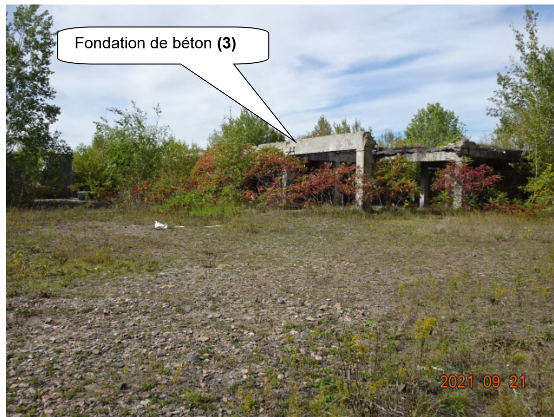
Hil-2021-09-21-004 – Fondation de béton (3) (vue vers le Nord)
