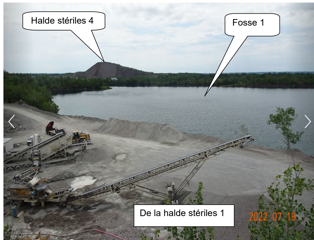
Hil-2022-07-19-005 – Du côté Nord, fosse 1 et en arrière la halde stériles 4 (vue vers le Sud-Est) Coordonnées UTM Nad 83 : 395591 Est, 5040026 Nord
