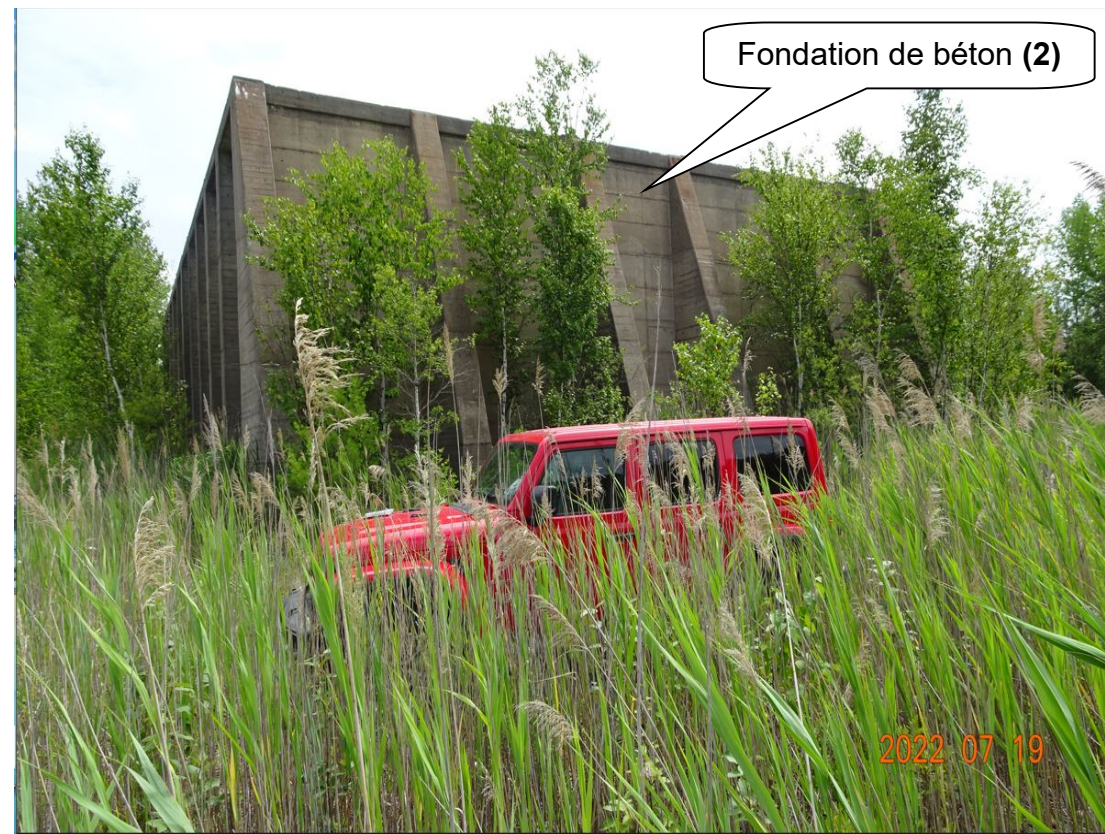
Hil-2022-07-19-002 – Fondation de béton (2) (vue vers le Sud-Est) Coordonnées UTM Nad 83 : 395049 Est, 5039182 Nord
