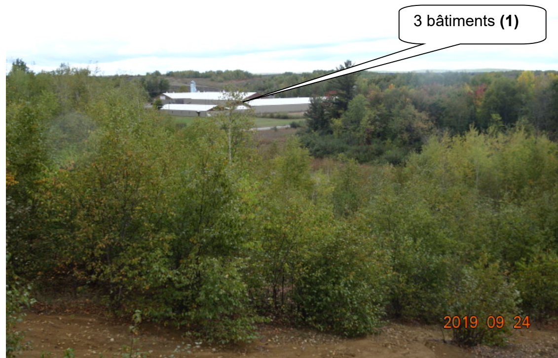
Hil-2019-09-24-001 – De la halde à résidus 3, vue des 3 bâtiments (1) (vue vers le Nord) Coordonnées UTM Nad 83 : 394930 Est, 5038856 Nord
