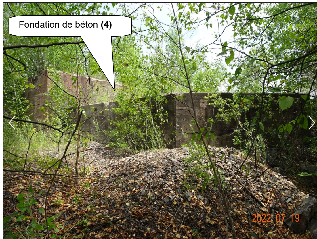
Hil-2022-07-19-003 – Fondation de béton (4) (vue vers Nord-Est)
