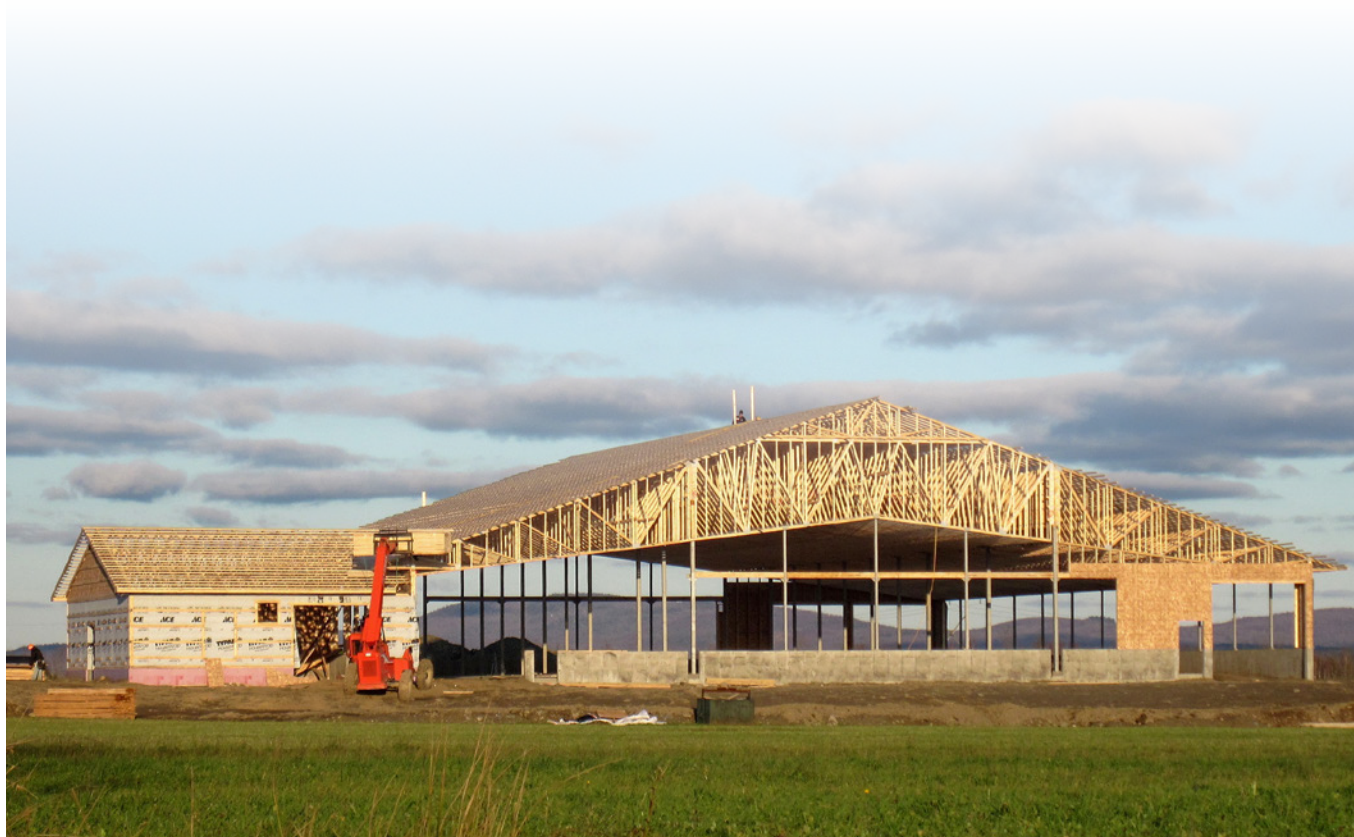
Fermes de toit préfabriquées en bois de grande portée, bâtiment agricole. Photo : Structures RBR
