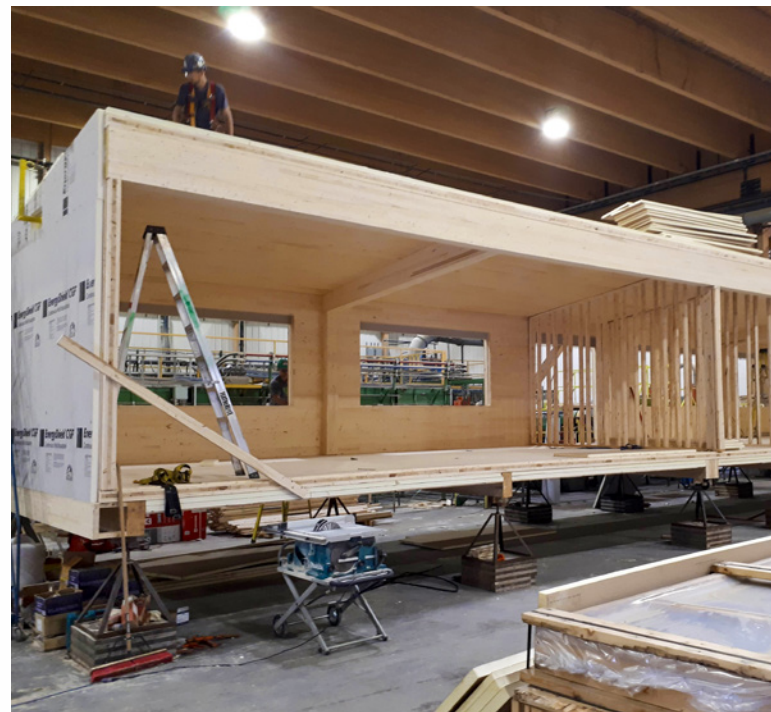
Module préfabriqué en bois massif, école Riverside, Arvida. Photo : Nordic Structures
