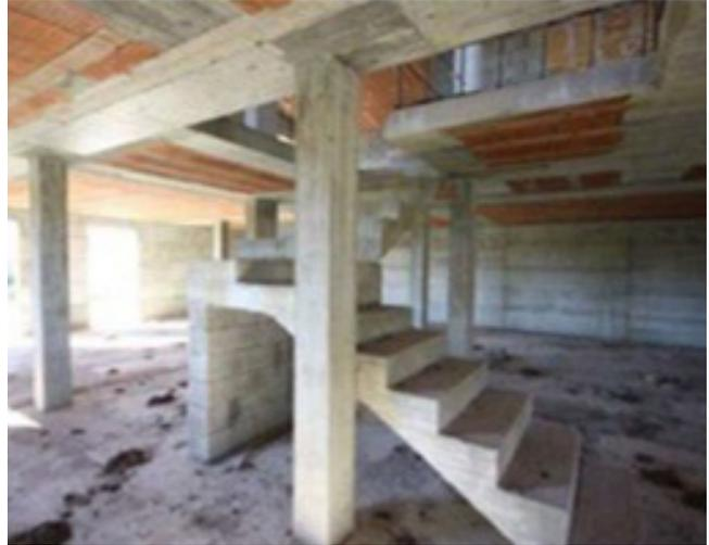
Concernant ces exemples, les mesures d'immunisation visent à ce que le rez-de-chaussée (partie habitable) se trouve au moins à 30 centimètres au-dessus de la cote de crue de récurrence de 100 ans, mais que l'eau puisse pénétrer sous le bâtiment en réduisant au maximum les dommages. Cela réfère au principe de transparence hydraulique. Pour ce faire, le bâtiment doit être adapté pour « céder » face à l'inondation. Aucune pièce habitable n'est autorisée au sous-sol.
