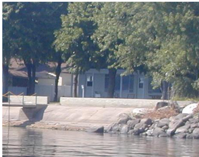
Figure 3. Mur de soutènement, où la limite du littoral correspond au sommet du mur
