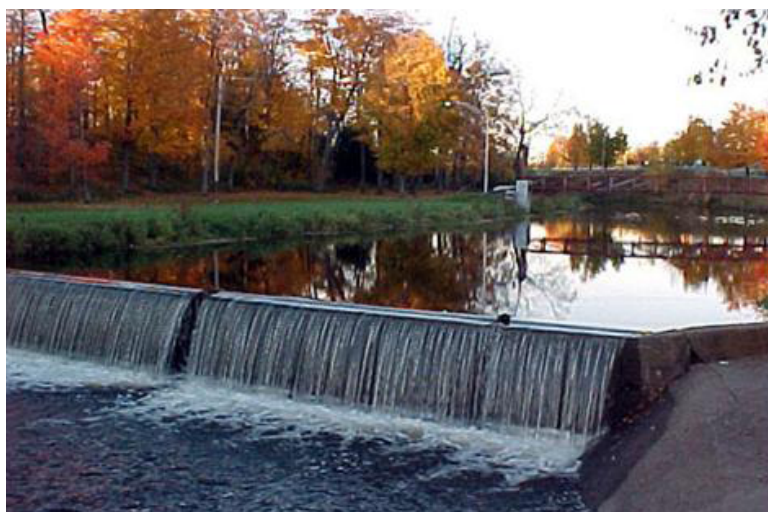
Figure 2. Ouvrage de retenue, où la limite du littoral correspond à la cote maximale d'exploitation
