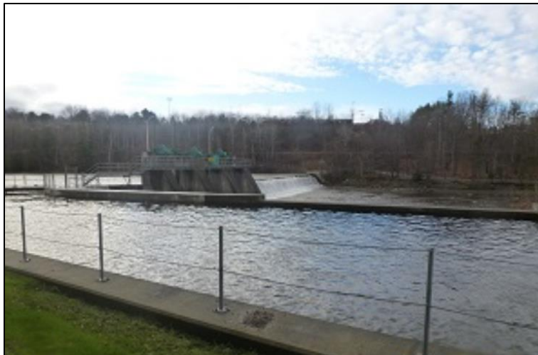
Figure 12 Exemple d'un barrage.
