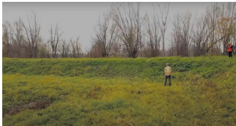
Figure 15 Exemple d'une digue agricole.
