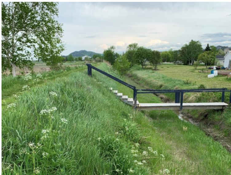
Figure 37 Escalier et passerelle joutés à un OPI.
