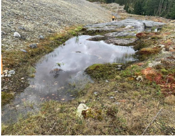
Figure 59 Nappe d'eau stagnante et claire à l'aval d'une digue en terre.
