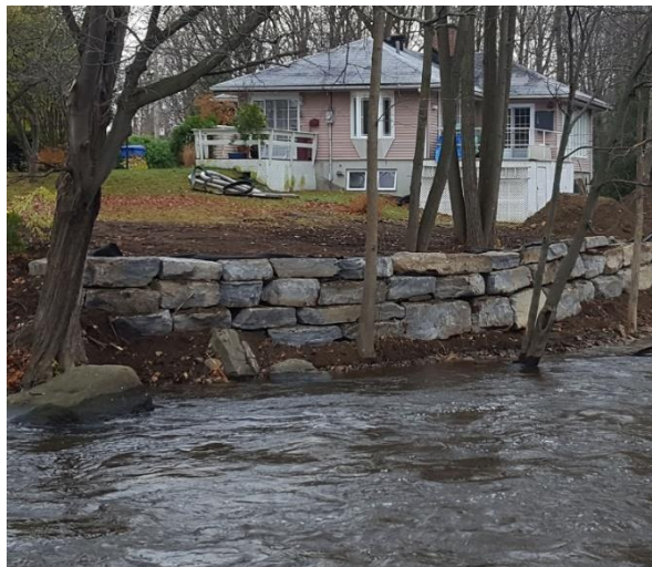
Figure 16 Exemple d'un mur de soutènement.
