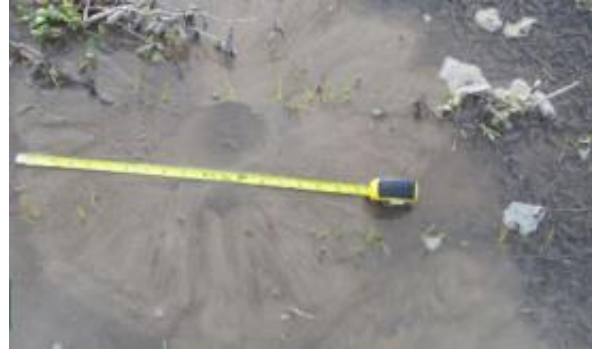
Figure 60 Sol porté à l'état de boue par une venue d'eau, avec transport de particules.
