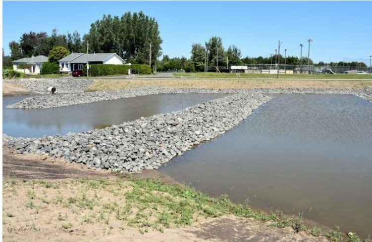
Figure 14 Exemple d'un bassin de rétention des eaux pluviales.
