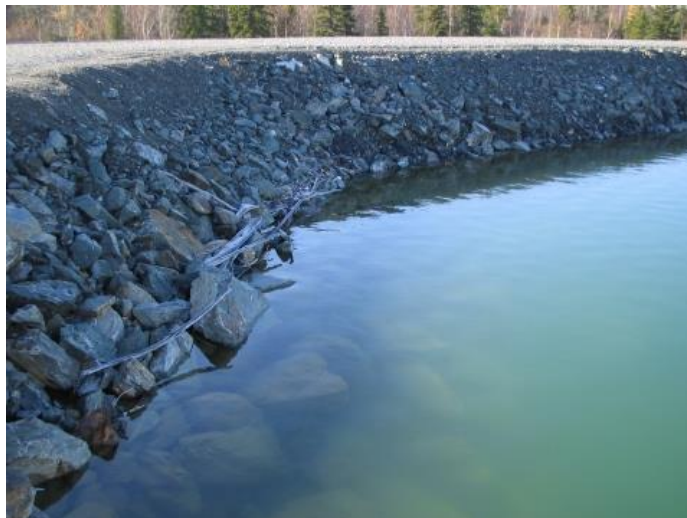
Figure 11 Exemple d'une digue de parc à résidus miniers servant pour le stockage des résidus. Source : VertigO (2006)
