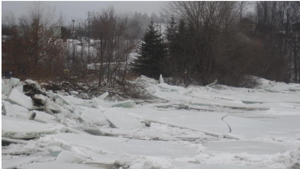
Figure 42 Endommagement d'une digue en terre à la suite de la rupture d'un embâcle.
