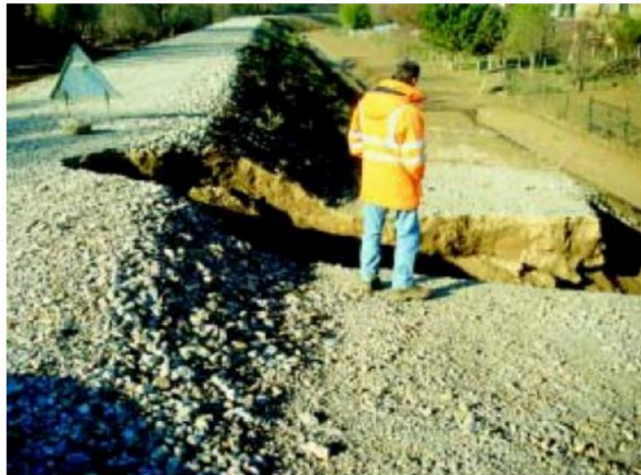
Figure 64 Renard hydraulique. Source : Mériaux et collab. (2004)
