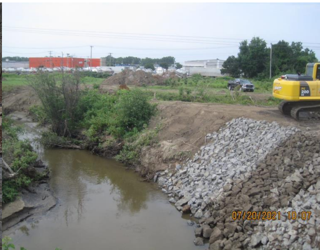
Figure 17 Exemple d'un ouvrage de stabilisation de talus en enrochement.
