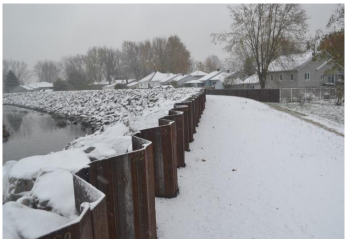
Figure 8 Exemple d'un ouvrage protégeant un secteur habité.
