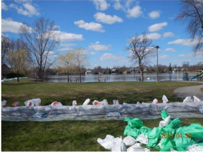
Figure 6 Exemple d'une digue en sacs de sable utilisée comme structure temporaire de protection. Source : MELCCFP
