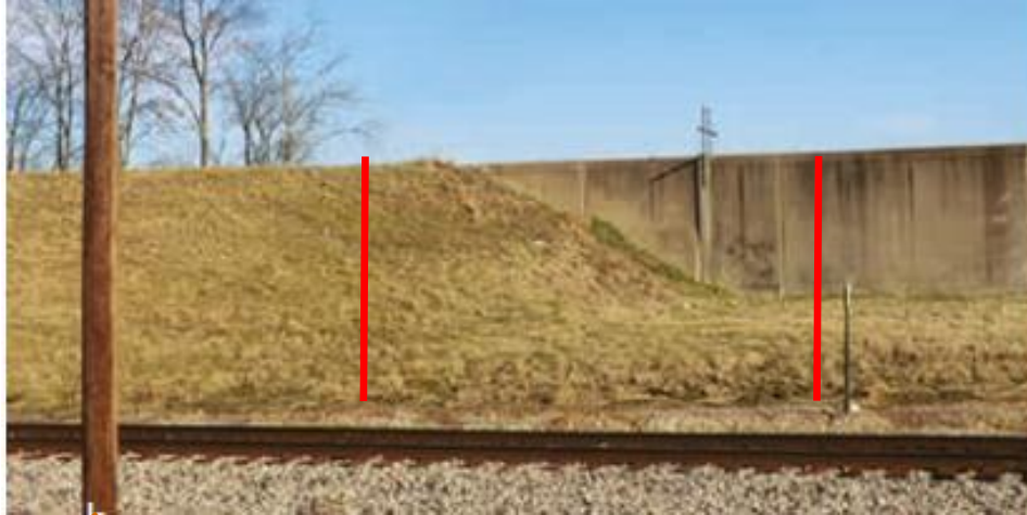
Figure 32 Zone de transition entre deux tronçons.
