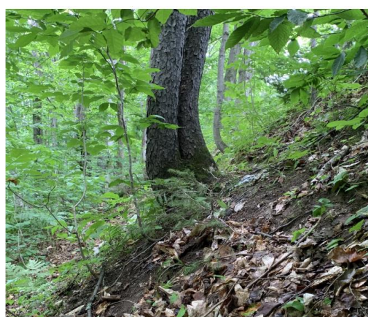
Figure 58 Arbres courbés sur la pente du talus d'une digue.
