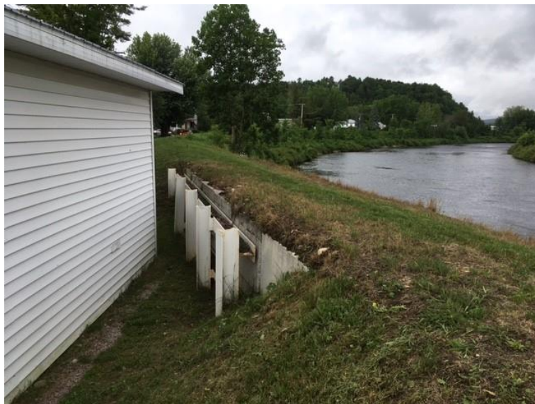
Figure 36 Cabanon restreignant l'inspection du pied de l'OPI. Source : MELCCFP
