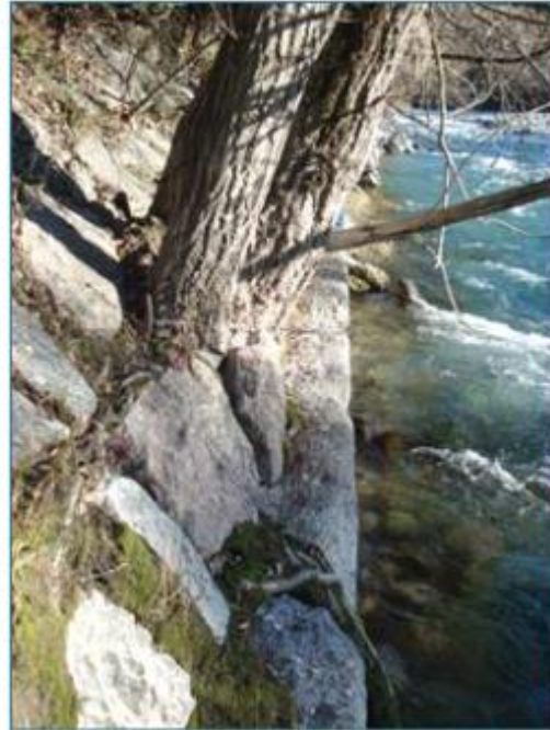
Figure 39 Colonisation d'un enrochement de protection par la strate arborescente.
