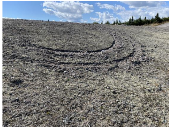
Figure 68 Sillons d'érosion causés par le passage d'un véhicule tout-terrain sur le talus aval d'une digue en terre.
