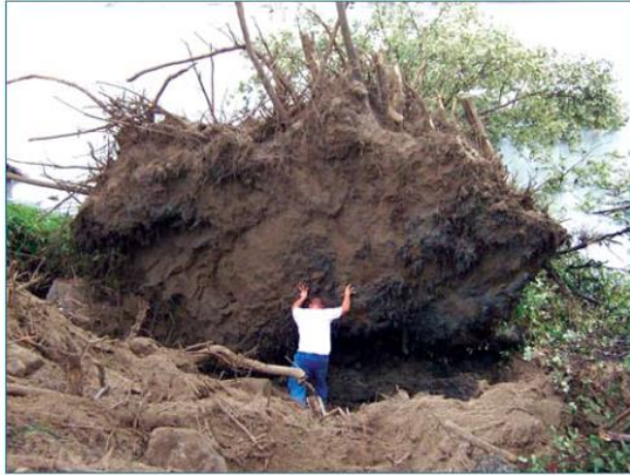
Figure 40 Soulèvement d'une importante masse de terre causé par le déracinement d'un arbre sur une digue.
