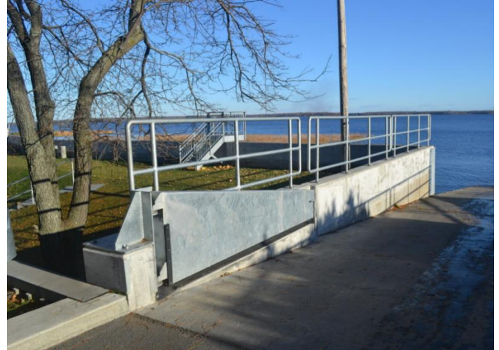
Figure 7 Exemple d'un point bas ponctuel et de courte longueur, fermé au moyen d'une structure amovible, qui n'enlève pas à l'ouvrage son caractère permanent. Source : MELCCFP
