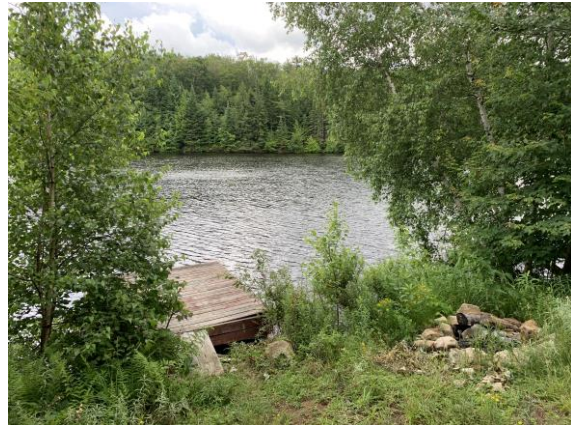
Figure 67 Activité humaine (feu) en crête et intervention en amont (aménagement d'un quai) d'une digue en terre.
