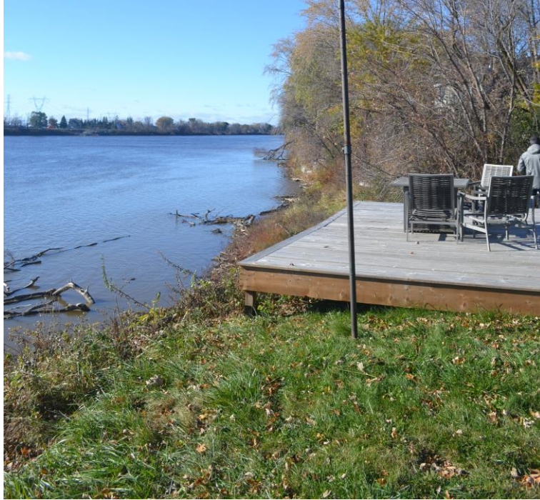
Figure 35 Terrasse installée en crête de l'OPI restreignant la visibilité pour l'inspection. Source : MELCCFP
