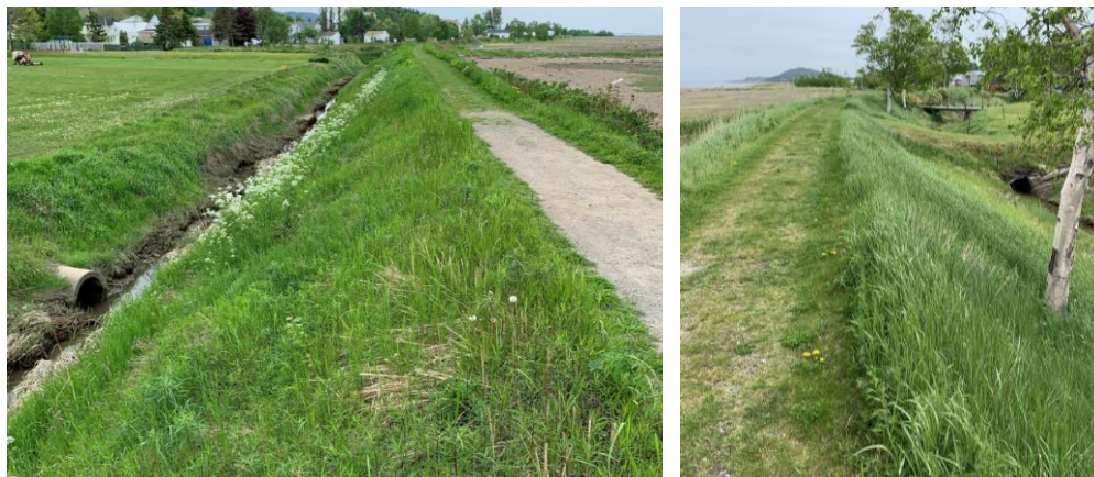
Figure 34 Fossé de drainage de la zone aval et ponceaux sous des accès à la crête dans l'axe longitudinal de l'OPI.
