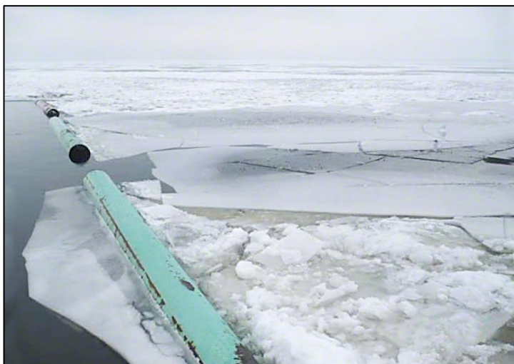
Figure 13 Exemple d'une estacade réduisant les risques liés aux inondations causées par les glaces.
