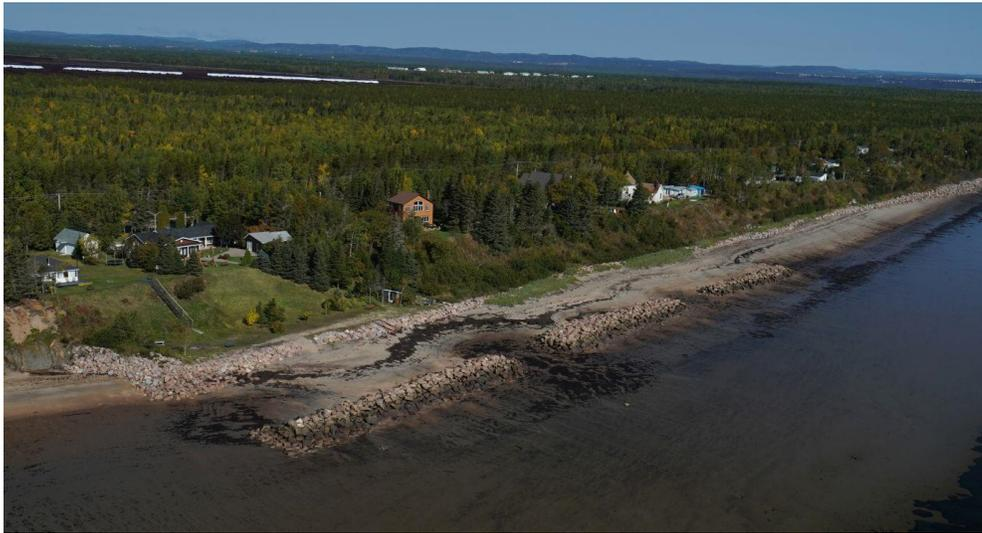
**Figure 24. Ouvrage de protection (brise-lame), installé sur l'estran (Pointe-Lebel, Côte-Nord).**
