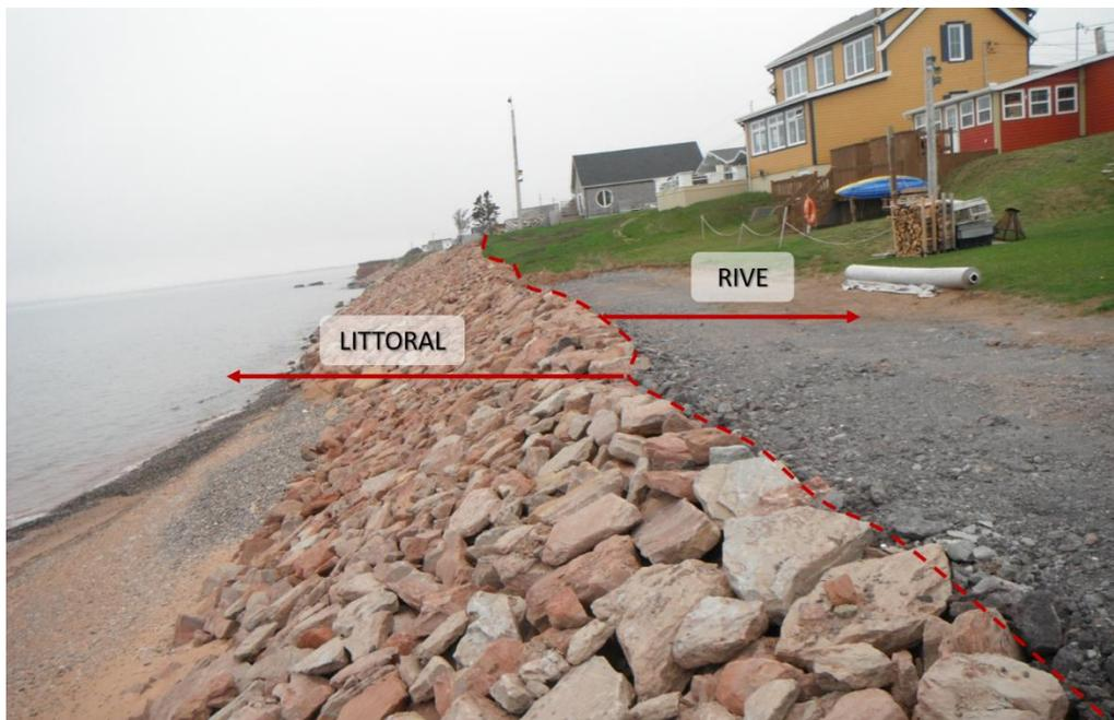
**Figure 29. Positionnement de la limite du littoral dans le cas d'une côte artificialisée. La limite se situe au sommet de l'enrochement et marque une transition subite entre le littoral et la rive.**
