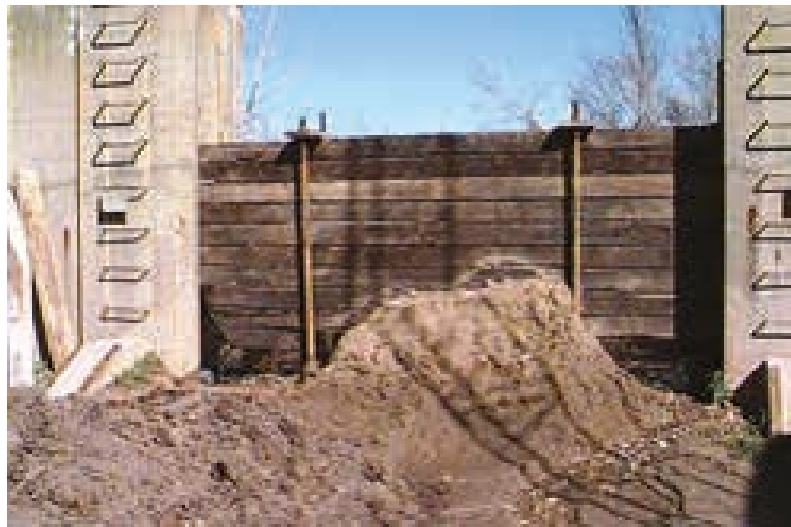
Figure 8 Batardeau comblant une ouverture dans un mur de protection contre les inondations
