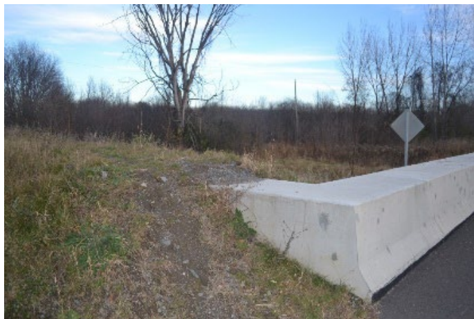
Figure 4 Point de jonction entre deux tronçons d'un OPI, l'un constitué d'un mur en béton le long d'une route et l'autre d'une digue en remblai de terre
