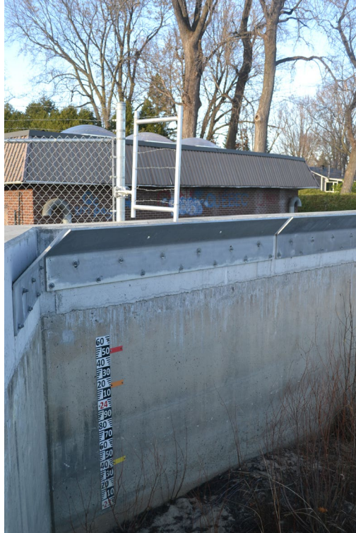
Figure 19 Exemples de repères visuels installés sur un OPI avec un code de couleur « jaune », « orange » et « rouge »
