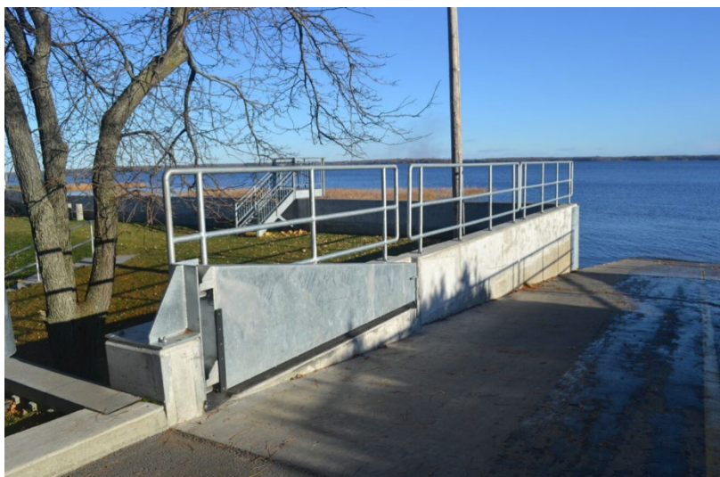
Figure 6 : Exemple de point bas ponctuel et de courte longueur, fermé au moyen d'une structure temporaire, qui n'enlève pas à l'ouvrage son caractère permanent (source : MELCCFP)
