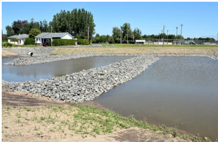
Figure 13 : Exemple d'un bassin de rétention des eaux pluviales (Source : Vingt55, Éric Beaupré)
