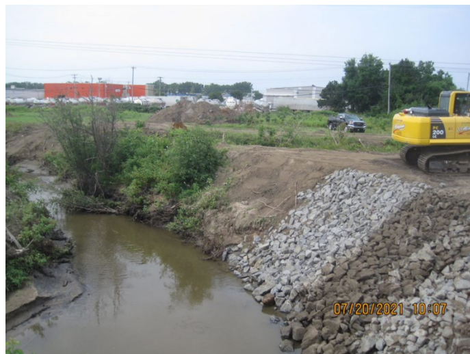
Figure 16 : Enrochement visant la protection d'un talus contre l'érosion (Source : MELCCFP)
