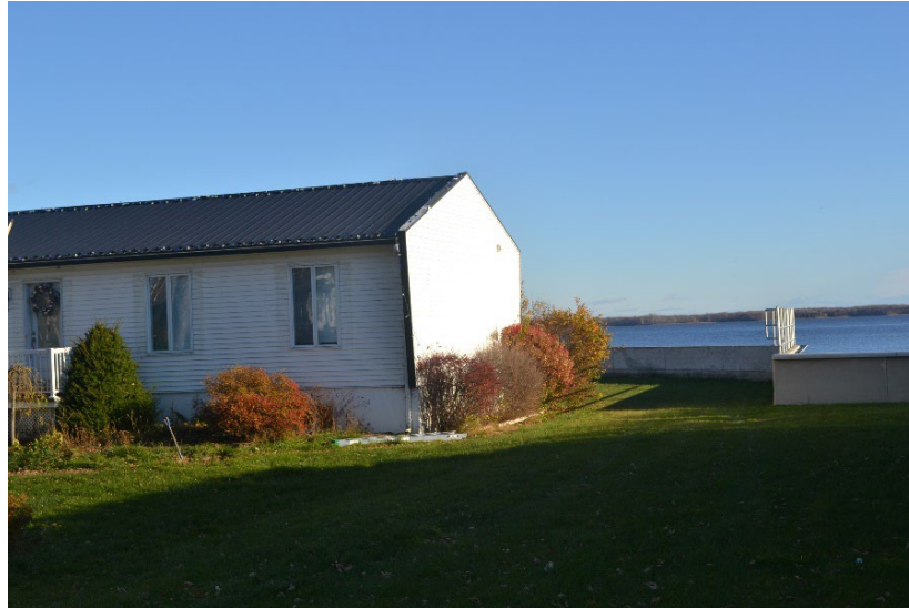
Figure 3 : Exemple d'un mur anti-crue dont la crête est plus haute que le terrain situé derrière lui (Source : MELCCFP)
