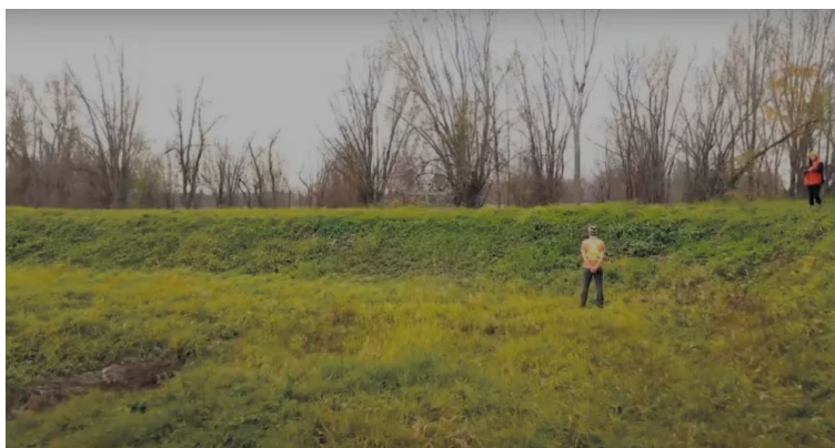
Figure 14 : Exemple d'une digue agricole (source : La terre de chez nous)
