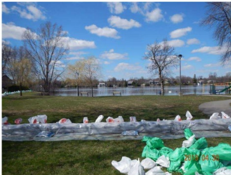
Figure 5 : Exemple d'une digue en sacs de sable utilisée comme structure temporaire de protection (source : MELCCFP)
