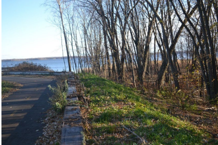
Figure 17 : Exemple d'OPI disposant d'une piste cyclable en crête (source : MELCCFP)
