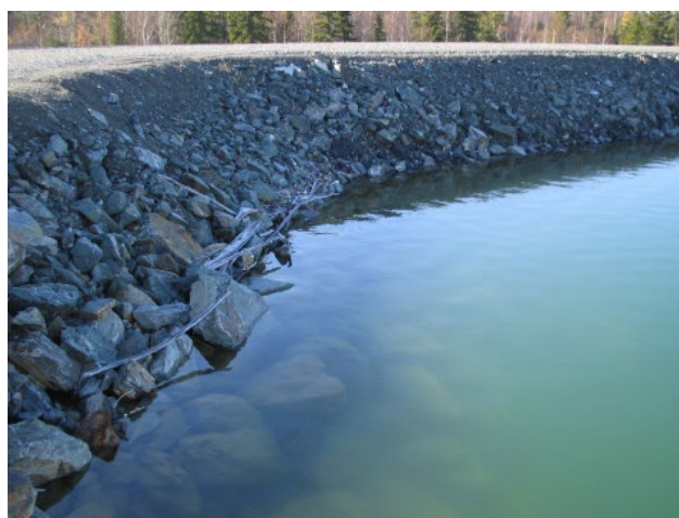
Figure 10 : Digue de parc à résidus minier servant pour le stockage des résidus (source : Vertigo)
