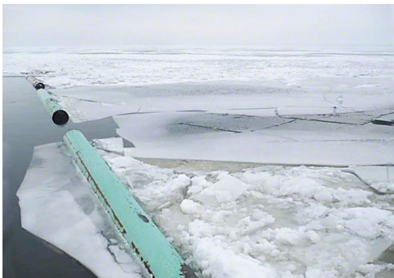
Figure 12 : Exemple d'une estacade réduisant les risques liés aux inondations causées par les glaces (Source : InfOcéans)
