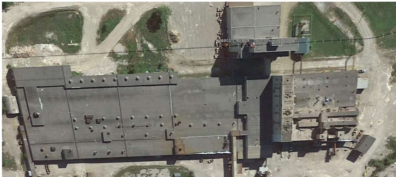
Figure 3 : Bâtiment principal - Usine
