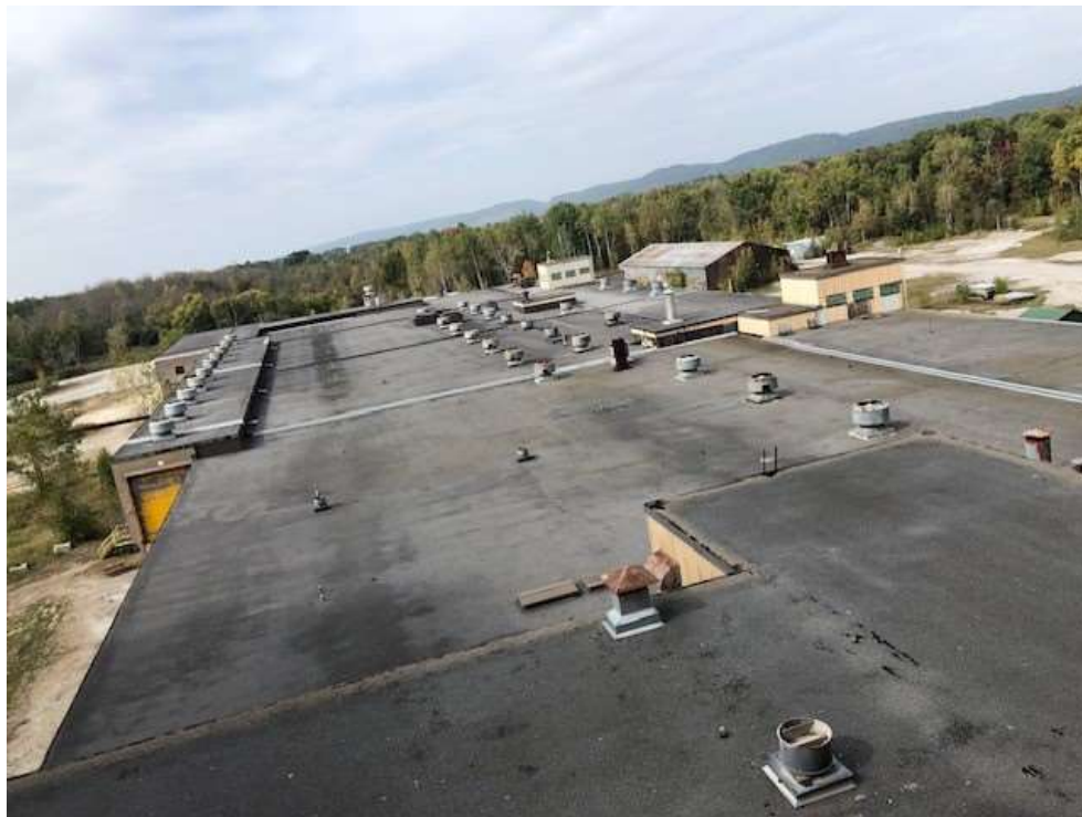
Figure 25 : Événements, extracteurs et cheminées sur la toiture
