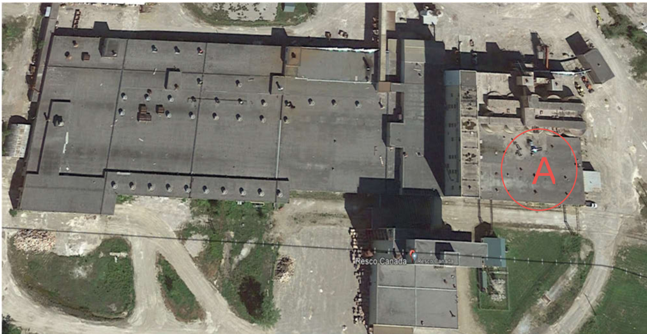
Figure 31 : A - Entrepôt à matières dangereuses
