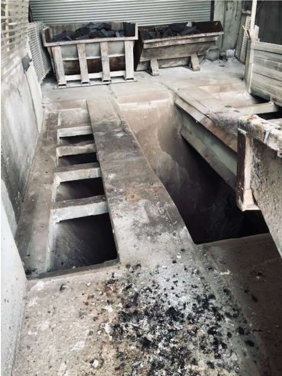
Figure 5 : A - Entrée au niveau du sol vers le concasseur
