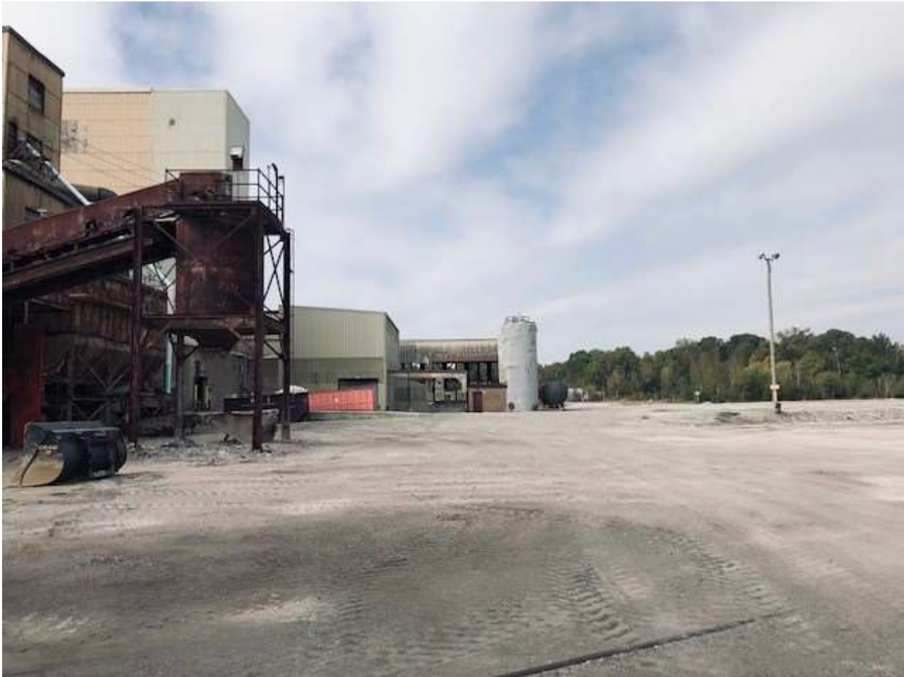
Figure 26 : Cour arrière - Dalle de béton
