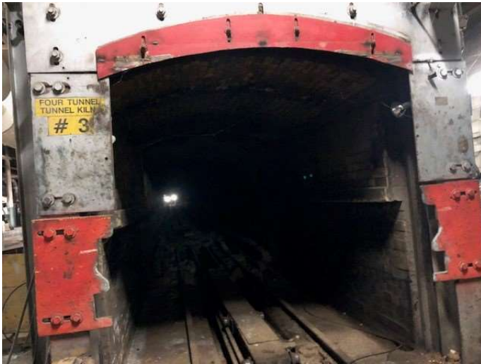
Figure 10 : Entrée four numéro 3
