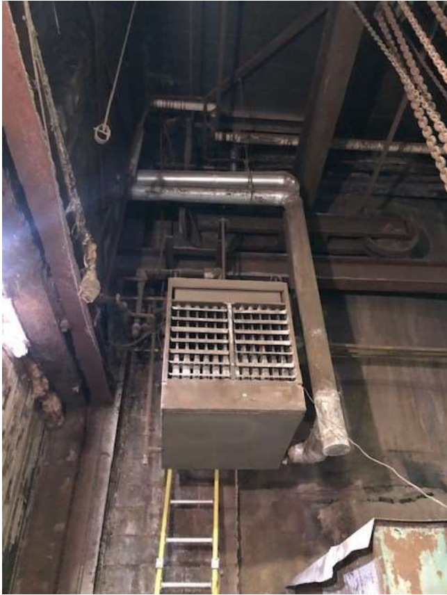
Figure 24 : Chauffage par aérotherme au gaz naturel
