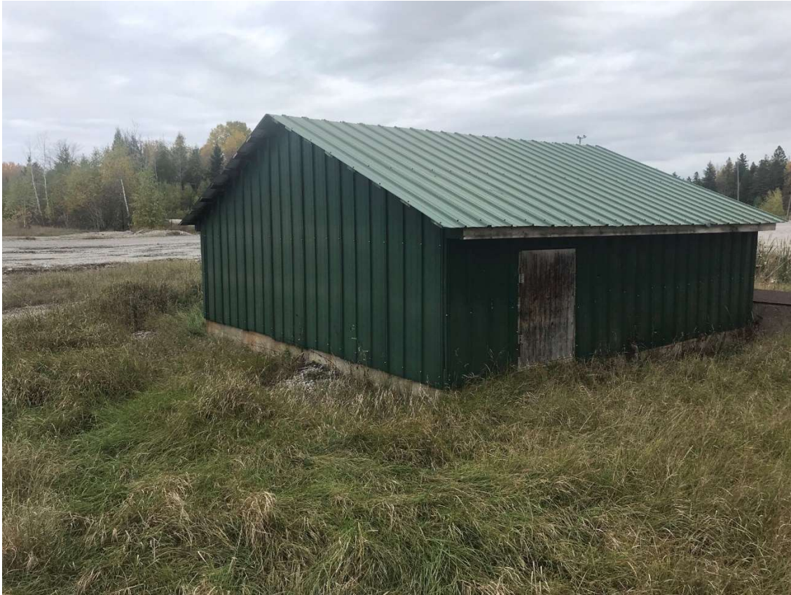
Figure 29 : Réservoir de refroidissement extérieur
