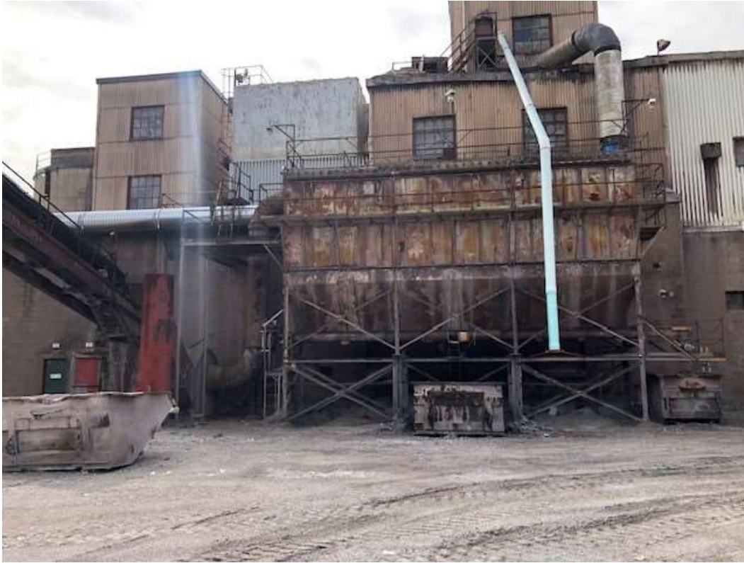
Figure 37 : Dépoussiéreur mécanique rotatif extérieur - Utilisé pour le concassage primaire
