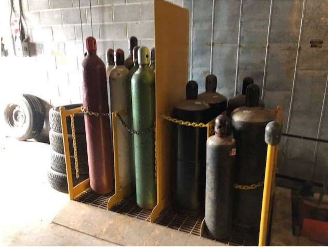
Figure 32 : Îlot de rangement des gaz
