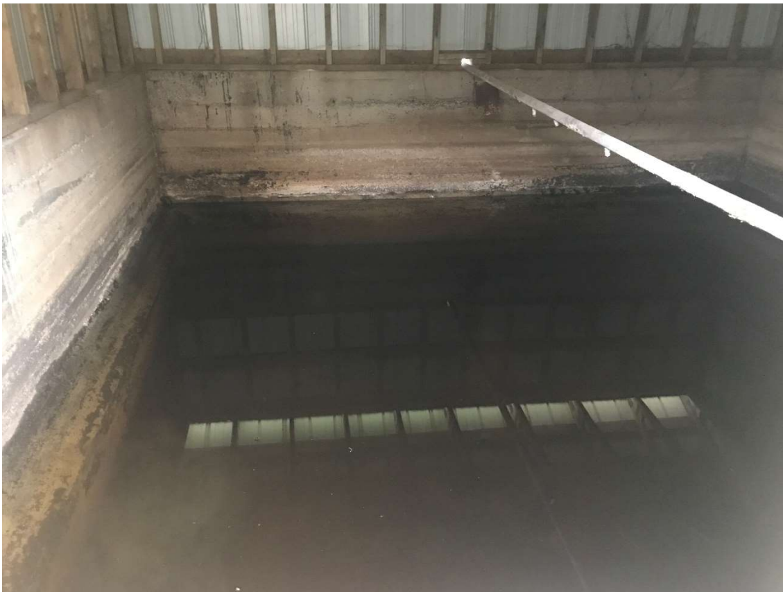
Figure 30 : Intérieur du réservoir de refroidissement - Structure en béton coulé
