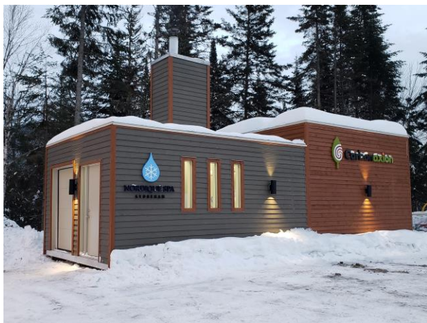
Figure 2.1 Chaufferie et réseau de chaleur, appartenant et exploités par Carbonaxion Bioénergies Inc., qui offre un service de chaleur à Nordique Spa Stoneham.
