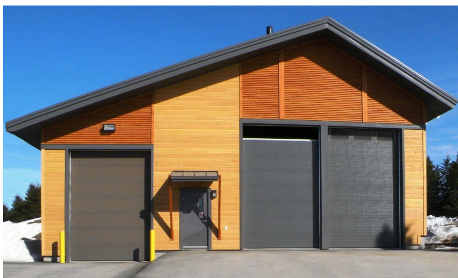
Chaufferie de l'hôpital d'Amqui – Source : Réseau d'expertise et de valorisation en biomasse forestière
