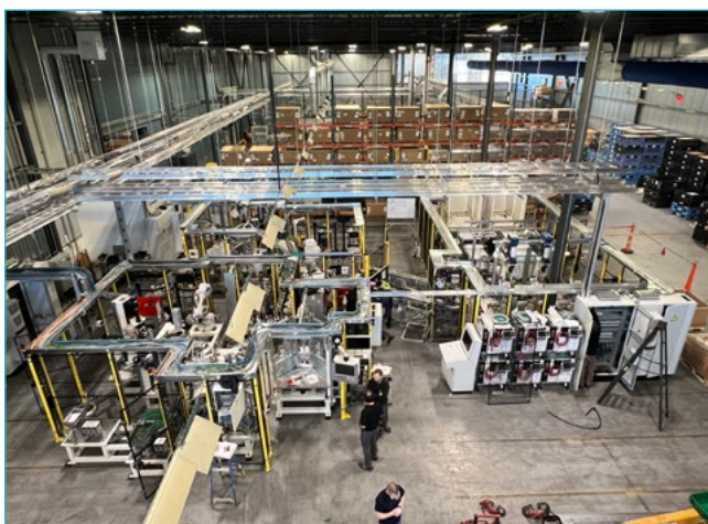
Nouvelle cellule d'assemblage automatisée : Avril 2024
