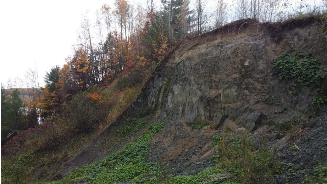
Figure 7: Vue rapprochée d'une paroi dénudée laissée par un glissement sur le flanc droit du ravin.
