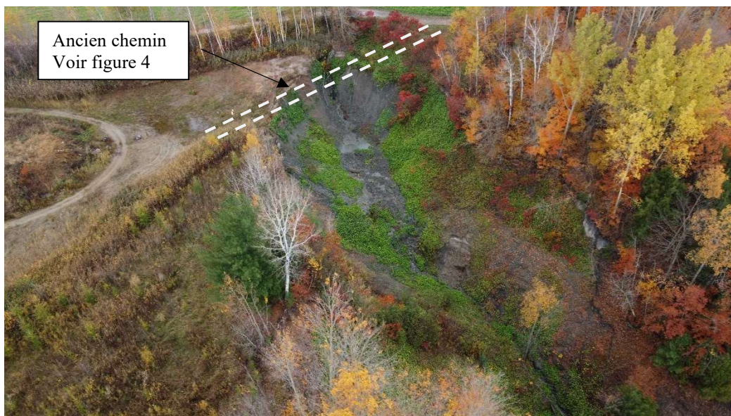
Figure 5: Photographie prise par drone le 19 octobre 2022.
