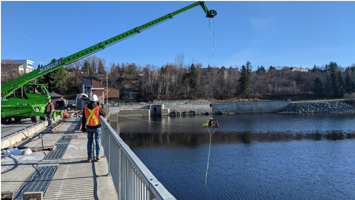
Figure 5. Installation de l'ADCP dans le fond du bassin Sartigan (photo prise par A. Pierre le 3 novembre 2022).
