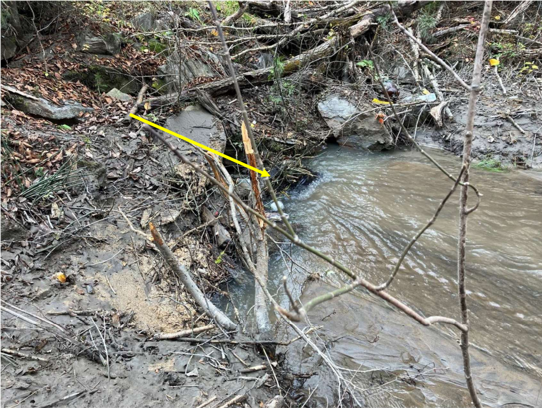
Figure 7 : Entrée du ponceau (flèche jaune), le 24 octobre 2023, après le nettoyage réalisé par la Municipalité.
