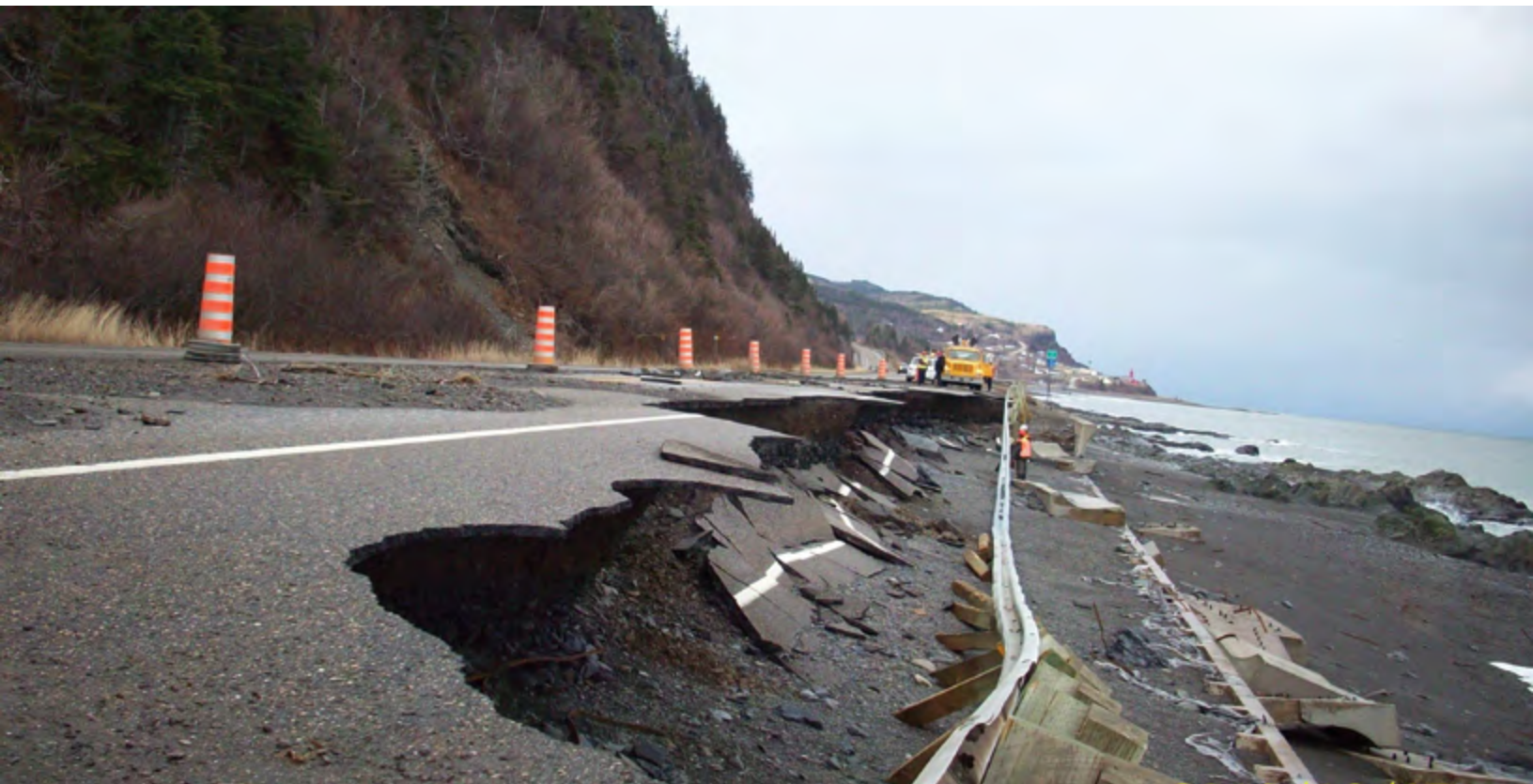
Submersion côtière et inondations dans l'est du Québec, 2010 (Photo : Ministère des Transports du Québec)
