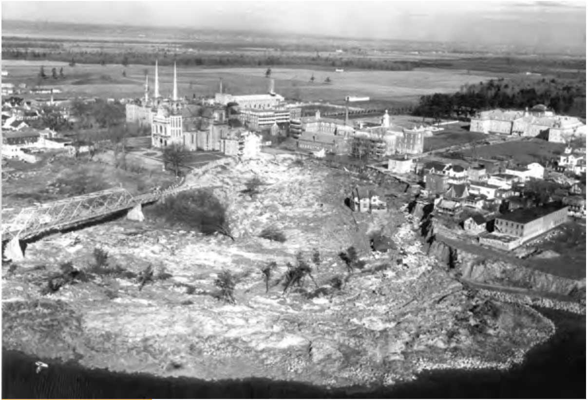
Glissement de terrain, Nicolet, 1955
