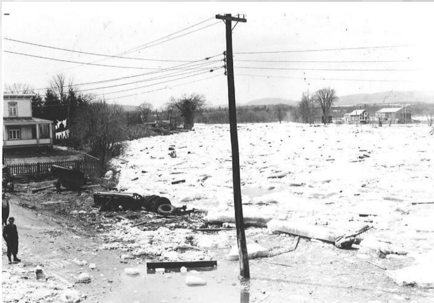
Photo : exemple d'inondation par embâcles, 1950
