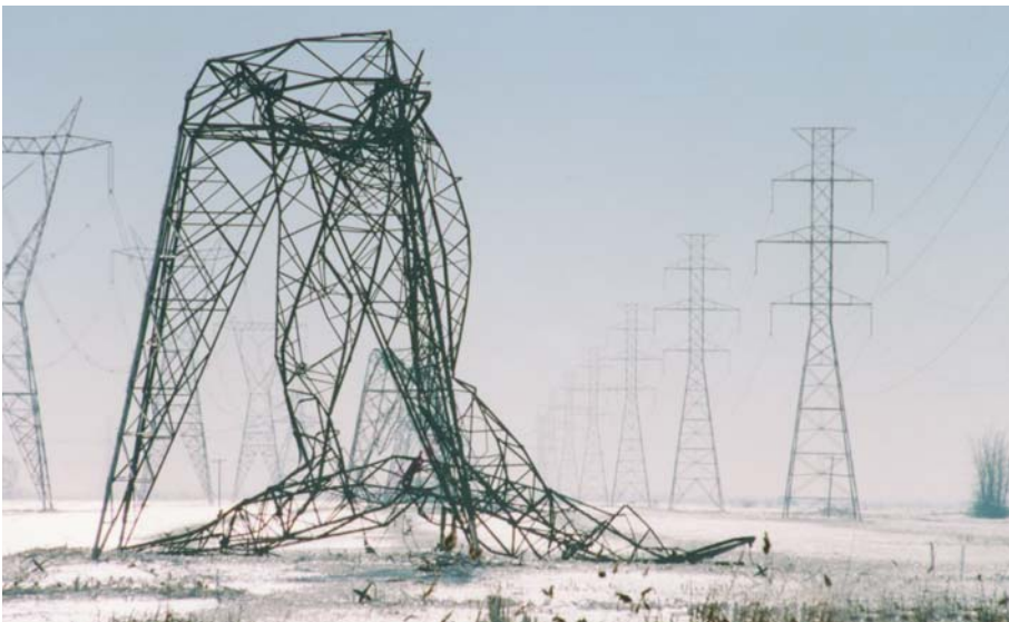
Sud-ouest du Québec, janvier 1998 - Hydro-Québec
