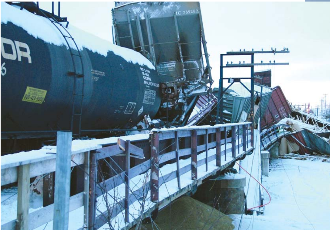
Montmagny (Chaudière-Appalaches), février 2004 - Ministère de la Sécurité publique
