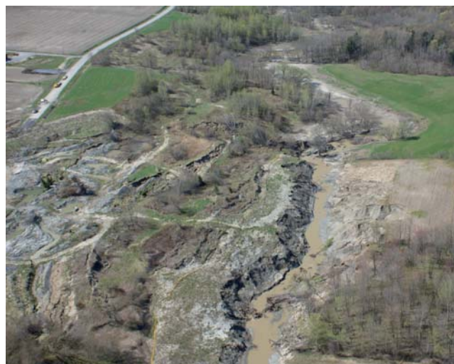
Figure 9.6 Vue de la cicatrice du glissement et du nouveau chenal le 10 mai 2011. Photo prise vers le sud.
