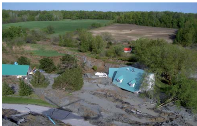
Figure 2.4 Vue de la maison en position inclinée vers l'avant.
