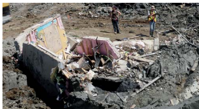
Figure 6.12 Photographie des restes des murs de fondation de la résidence.
