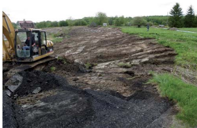
Figure 9.3 Résultat final de l'adoucissement de la paroi arrière du glissement.
