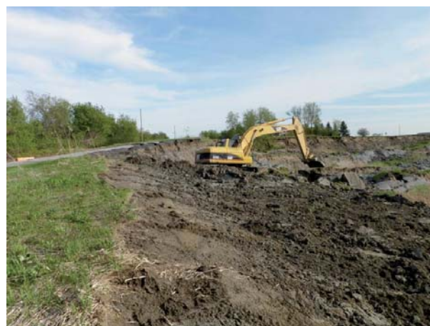
Figure 9.2 Opérations de déblai-remblai visant à adoucir la paroi arrière du glissement.
