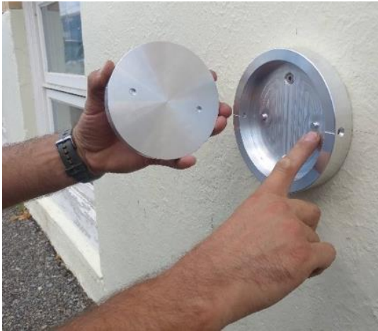
Figure 25. Fixation du disque (exemple sur une infrastructure réceptrice autre qu'un poteau ou un socle)
