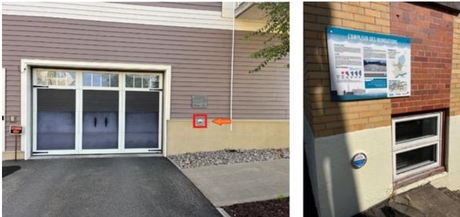
Figure 8. Repères de crue adjacents à une ouverture
