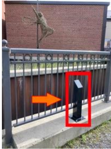
Figure 7. Socle destiné à soutenir un repère de crue en bordure d'un cours d'eau responsable d'inondations
