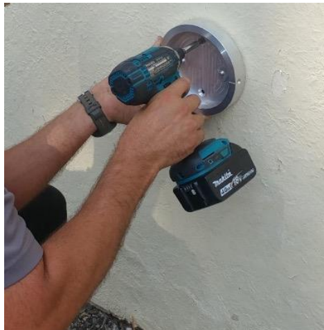
Figure 24. Fixation du disque (exemple sur une infrastructure réceptrice autre qu'un poteau ou un socle)
