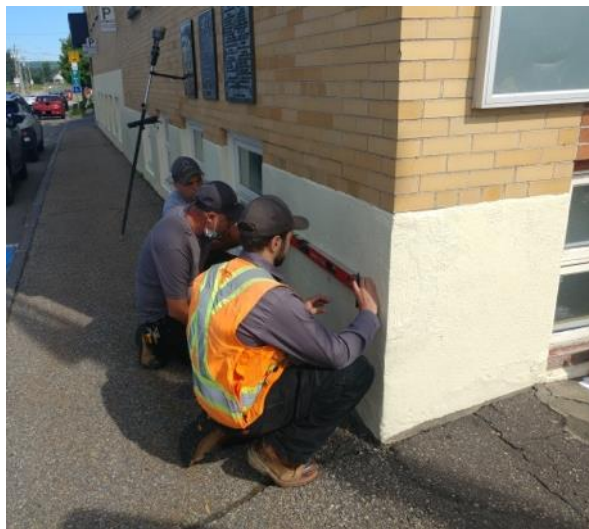
Figure 20. Positionnement d'un repère de crue
