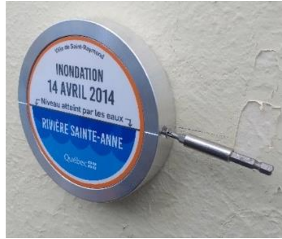
Figure 26. Fixation de la pastille
