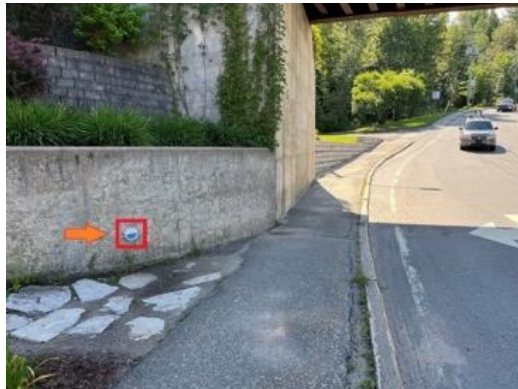
Figure 9. Repère de crue installé à l'extrémité d'une zone inondée
