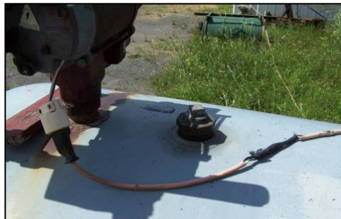
Non-conformité : le câblage n'est pas de type antidéflagrant.
