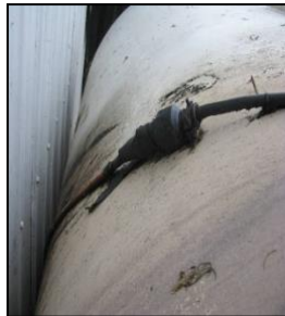
Non-conformité : le câblage n'est pas de type antidéflagrant.
