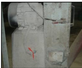
Non-conformité (raison : mauvais entretien ou raccordement)
