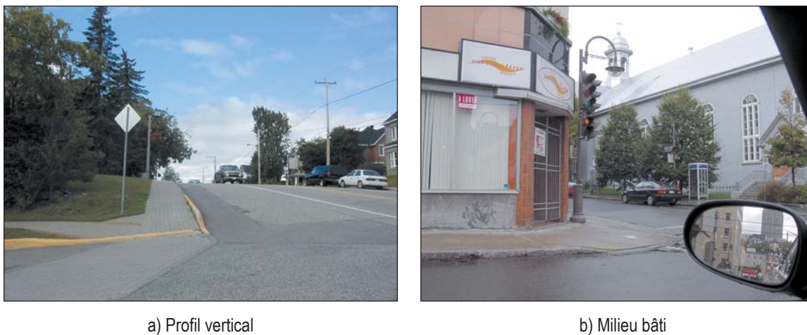
Figure 7-2 Déficience de visibilité causée par un obstacle permanent
