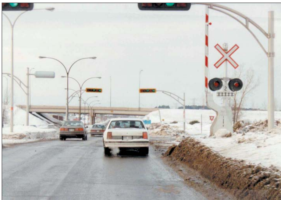
Figure 7-12 Passage à niveau avec barrière
