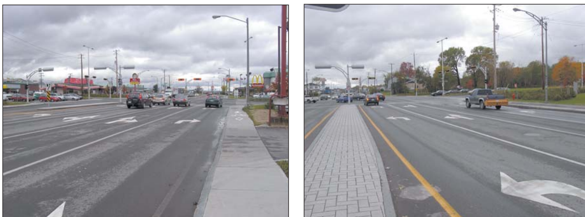
Figure 7-8 Présence d’une double voie de virage
