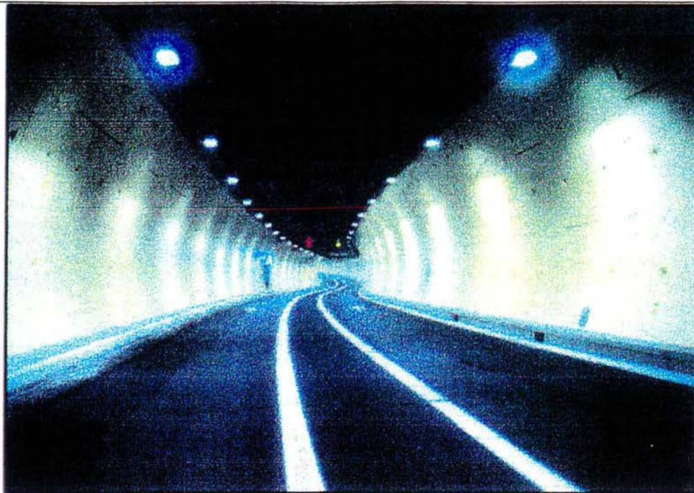
PREMIER TUNNEL - FÉVRIER 1997
