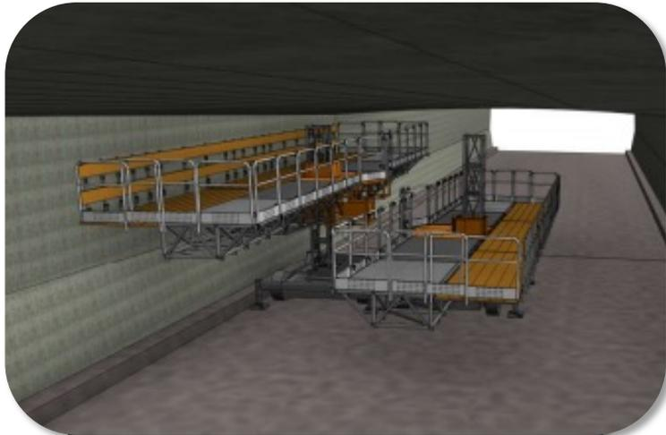
Plateformes pour la démolition manuelle des murs et de la voûte
