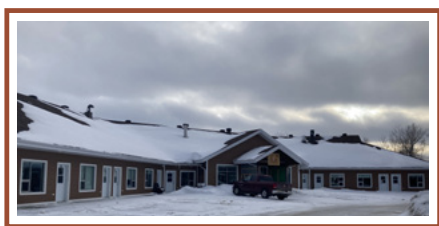
Maison des aînés de la communauté d'Obedjiwan.
