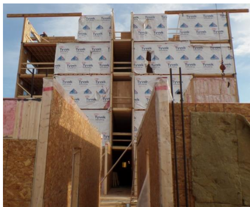
Photo 1 - aperçu des systèmes au chantier
