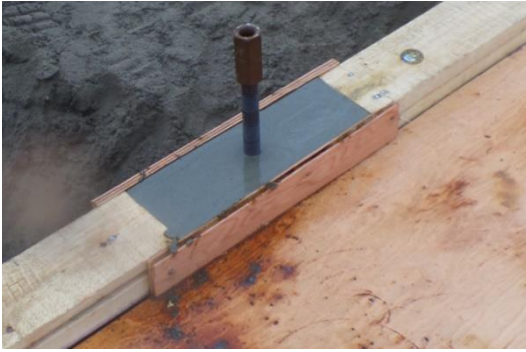
Photo 1 - tirant et bloc béton
