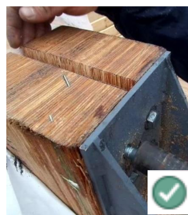
Photo 7 – pré-perçage conforme
