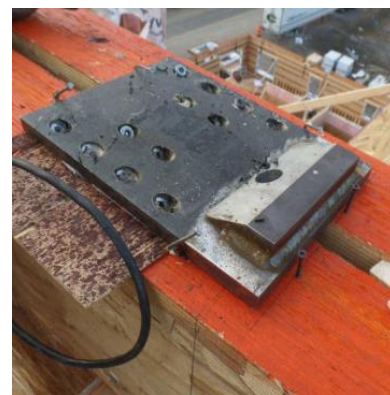
Photo 3 - ferrure balcon toit
