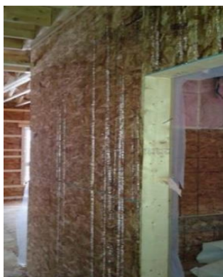
Photo 1 - glace/écoulement
