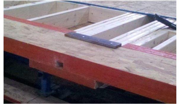
Photo 3 - pré-assemblage en usine
