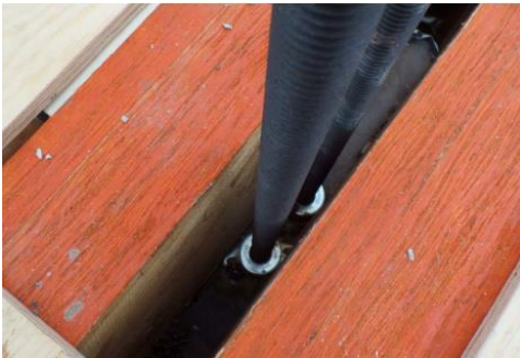
Photo 7 - tirant double/plaque/compensateur
