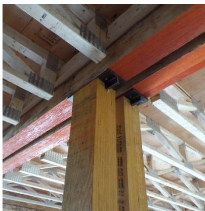
Photo 2 - jonction inter modules axes 2 et 13, plaques en T
